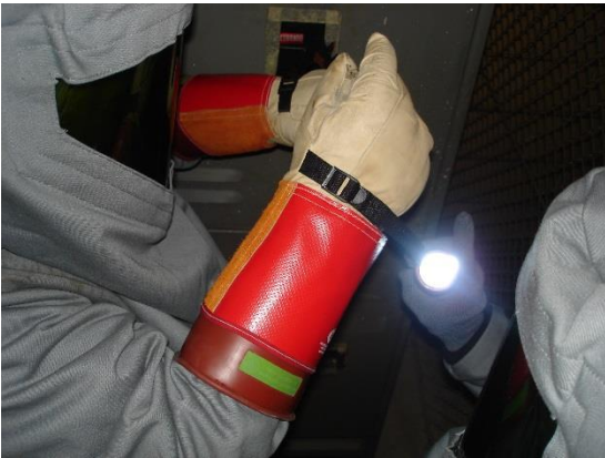
Figura 6.8 Ayuda Externa en Trabajos con traje de Arc Flash. Origen: Propio.
