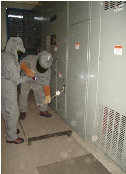
Figura 2.5.4.2 Conexión de una subestación compacta, Origen Propio
