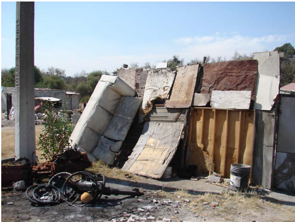
Muros Colindantes con Material de Desecho Fuente: Tomada en visita de campo 13 Mayo 2014
