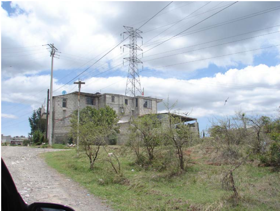
Vivienda construida en Área Federal a lado de Torre de Alta Tensión Fuente: Tomada en visita de campo 25 Enero 2014
