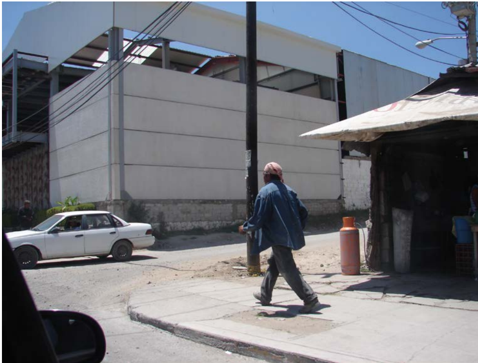
Acceso Principal a San Antonio Arenillas de Terraceria Fuente: Tomada en visita de campo 25 Enero 2014
