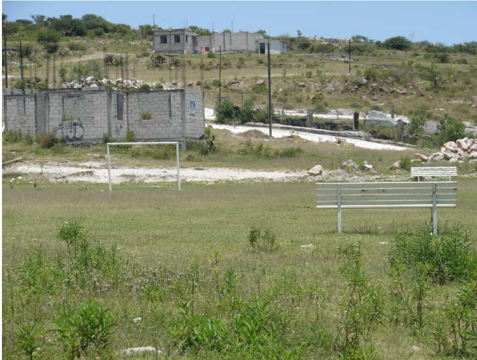
Construcción de Almacén dentro de los 20 mil m 2 donados para Equipamiento donde se encuentra la Cancha Rustica de Fut bol y Parque Recreativo Fuente: Tomada en visita de campo 13 Mayo 2014
