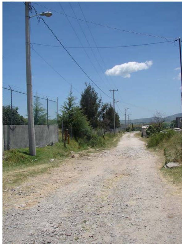
Alumbrado Público en calle Benito Juárez Fuente: Tomada en visita de campo 25 Enero 2014
