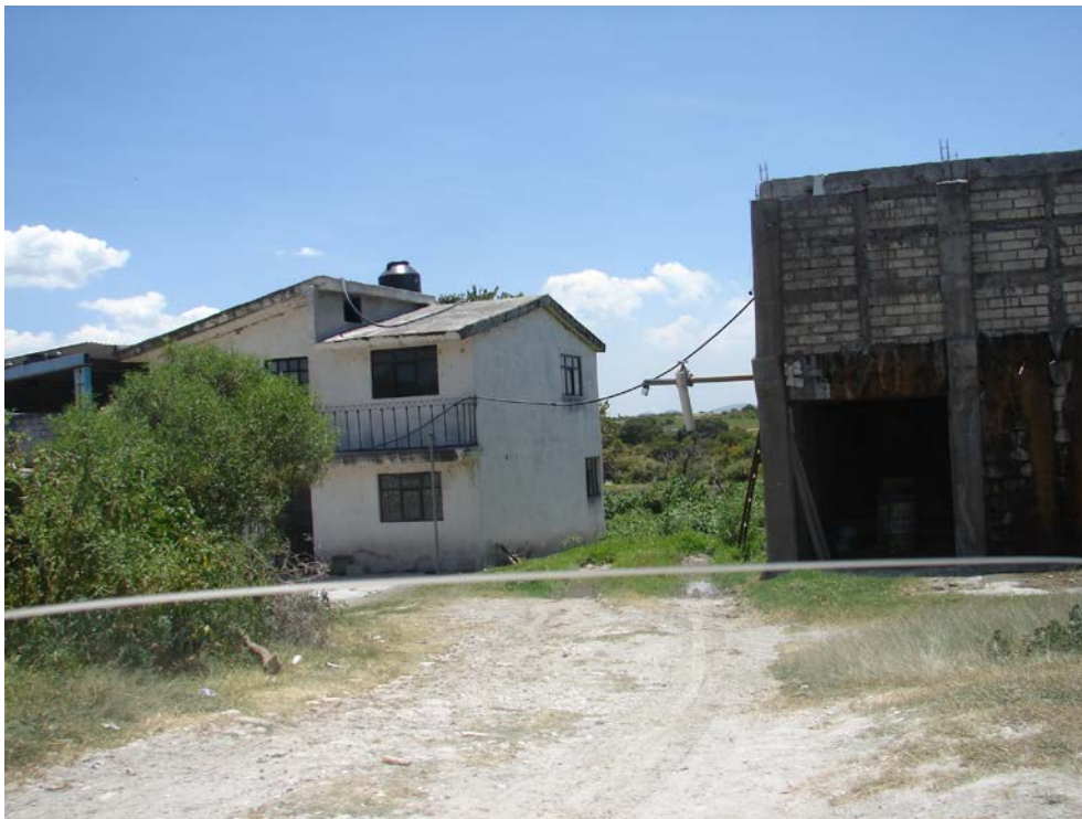
Toma de Agua Clandestina de Agua de la laguna de Valsequillo para Venta de Agua en Pipas Fuente: Tomada en visita de campo 2 Agosto 2014
