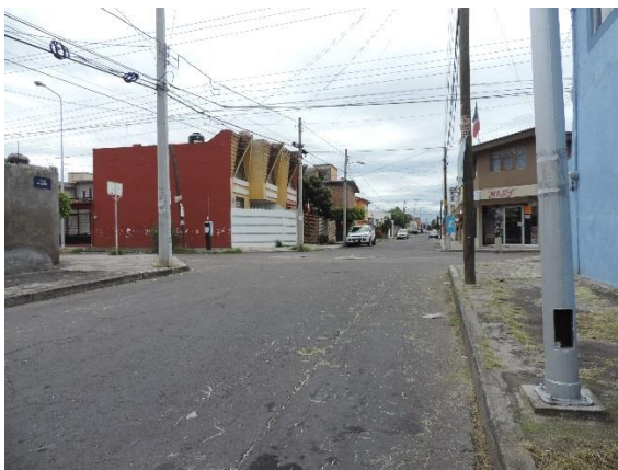
Figura 57 Teléfonos públicos en calle Allende
