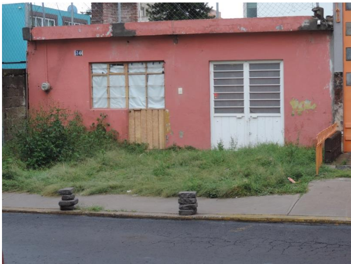
Figura 32 Casa en malas condiciones
