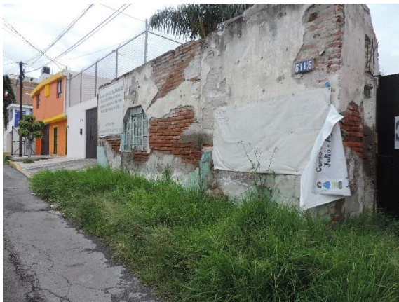
Figura 46 Casa con signos de desorden físico y lona con advertencia a los delincuentes
