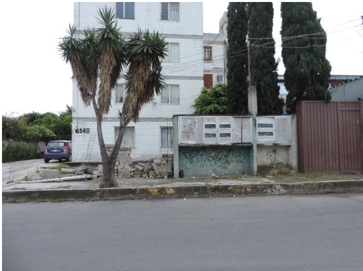
Figura 66 Evidencia de vandalismo en medidores de edificio de departamentos
