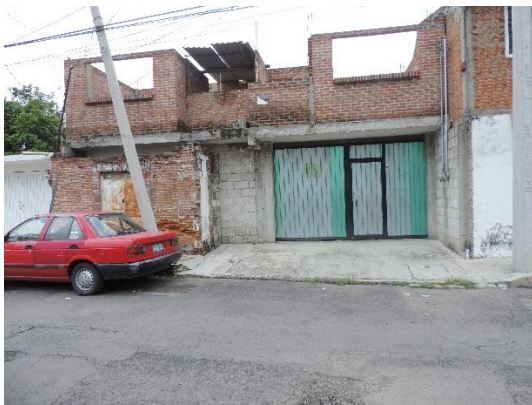
Figura 50 Construcción en obra negra
