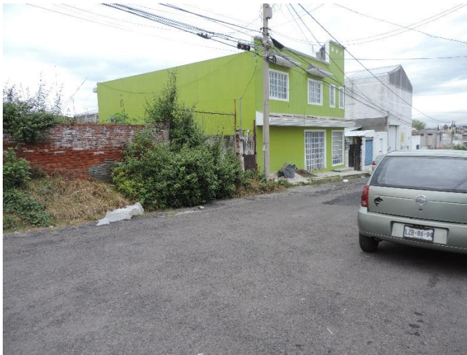
Figura 48 Lote baldío y escombros
