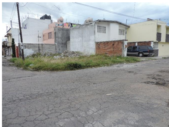
Figura 54 Escombros en lote baldío
