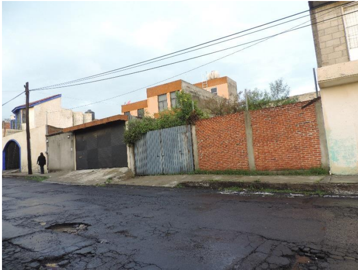
Figura 19 Construcción con señales de abandono
