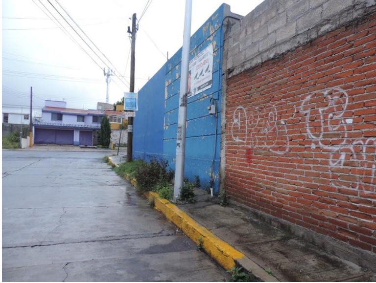
Figura 21 Banqueta dañada, grafiti y letrero de "vecino vigilante"
