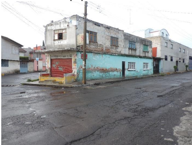
Figura 18 Edificio descuidado y con ventana rota
