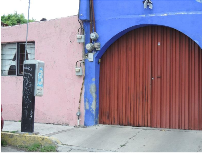
Figura 49 Teléfono público dañado y con grafiti
