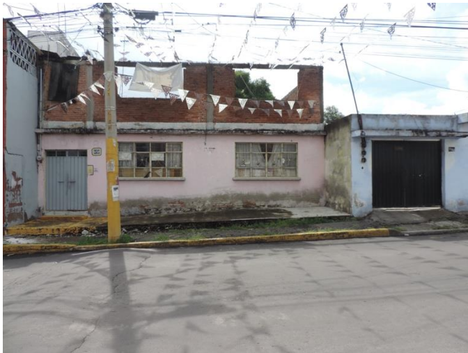
Figura 42 Edificio con construcción en obra negra
