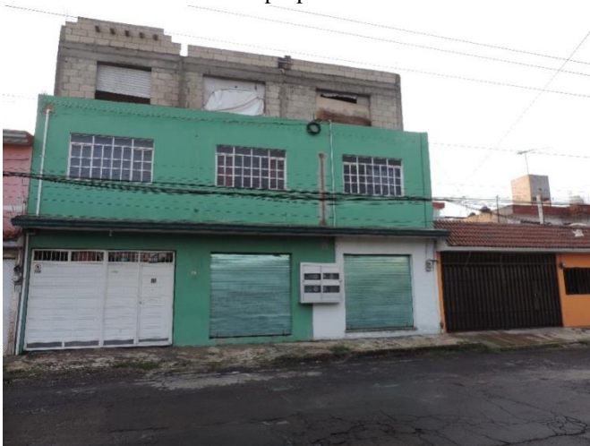
Figura 20 Edificio con construcción en obra negra
