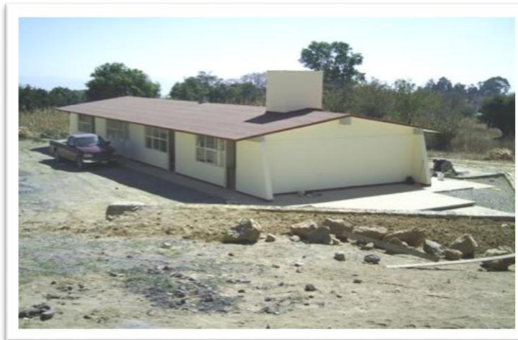
Foto 2.- edificio terminado y obra exterior
