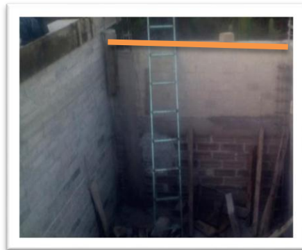
Foto 27.-EJE 1 (Enrace de muros)
