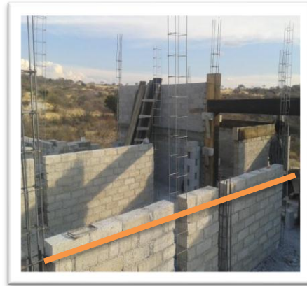
Foto 19.- EJE 5 (Muro segundo nivel)
