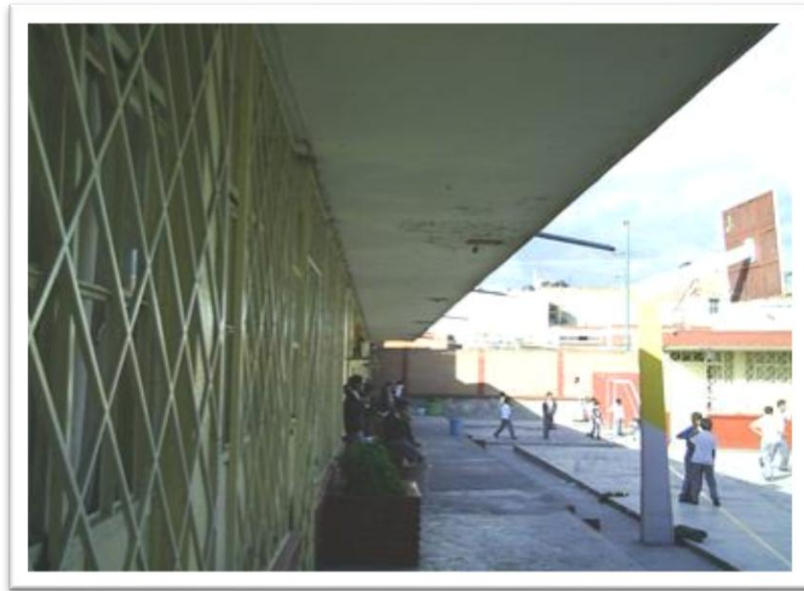
Foto 11.- visita de Obra
