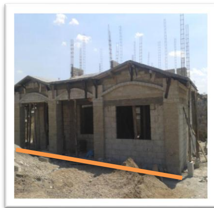
Foto 18.- EJE 9 (Fachada primer nivel)
