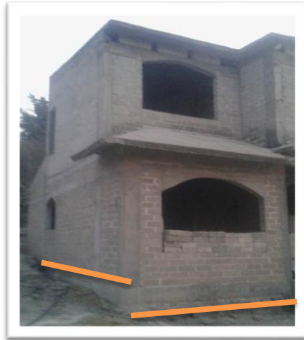
Foto 21.- Ejes 8 y A (Cimientos y muros)
