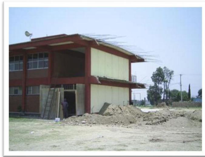
Foto 3.- preparación de terreno para desplante de obra.
