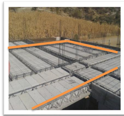
Foto 17.-EJES 7, B y 3 (Armado de loza)
