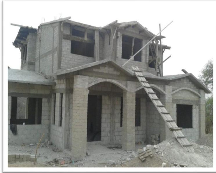
Foto 20.- proyecto terminado en obra negra.
