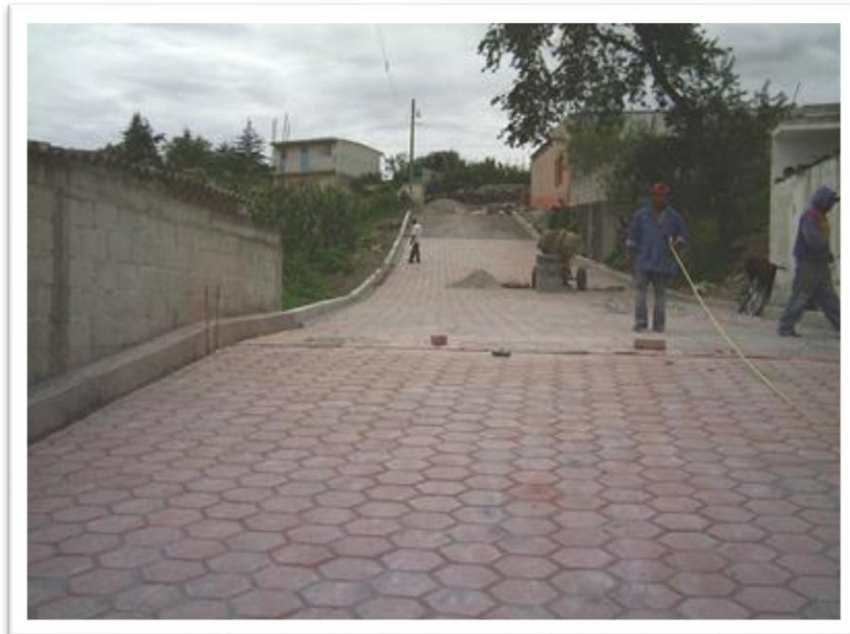
Foto 10.- colocación de Adoquín
