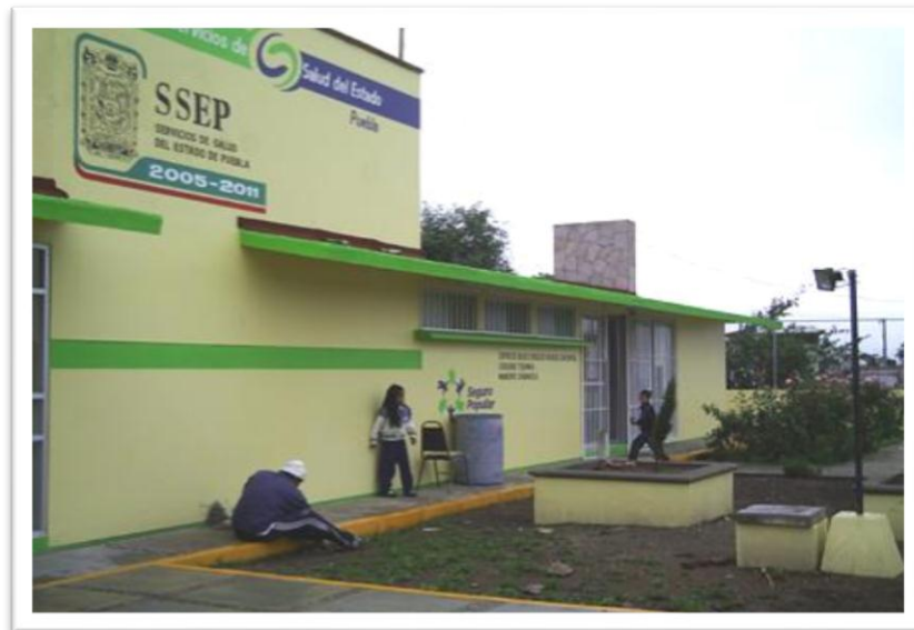
Foto 6.- Ejecución de trabajo
