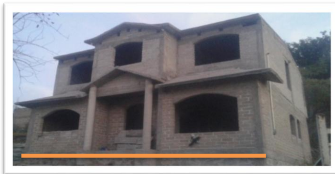
Foto 25.- Ejes 8 proyecto terminado en obra negra.
