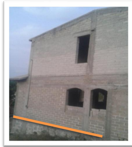
FOTO 22.- EJE D (Cimientos y muros)
