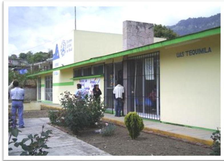
Foto 5.- visita de obra
