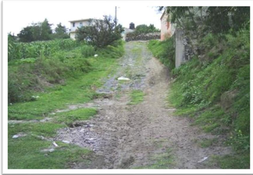
Foto 9.- visita de obra
