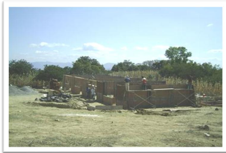
Foto 1.- nivelación de muros para cadena de cabezal.
