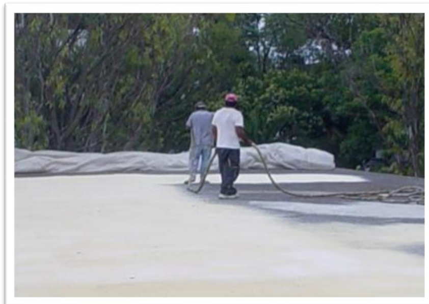
Foto 14.- ejecución de mantenimiento de impermeabilizante
