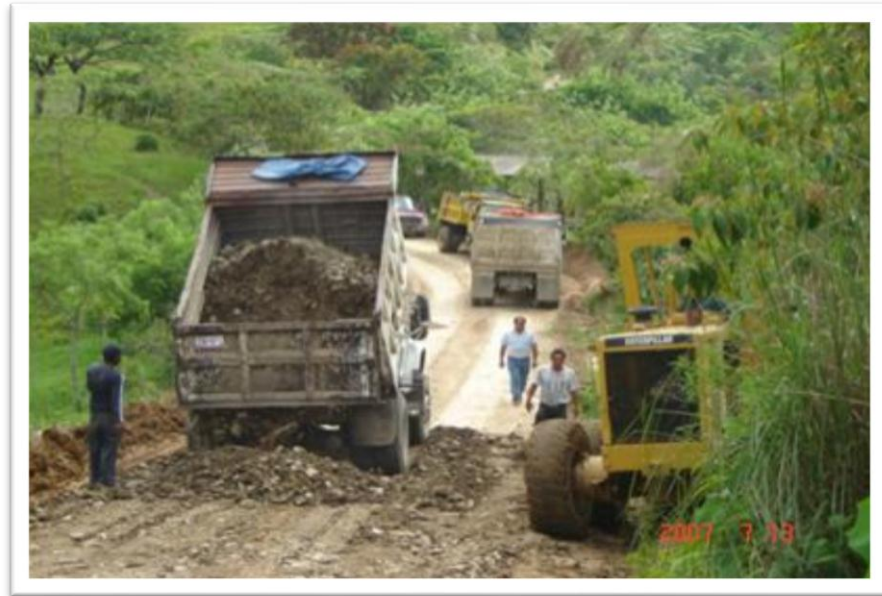
Foto 7.- vaciado de material base
