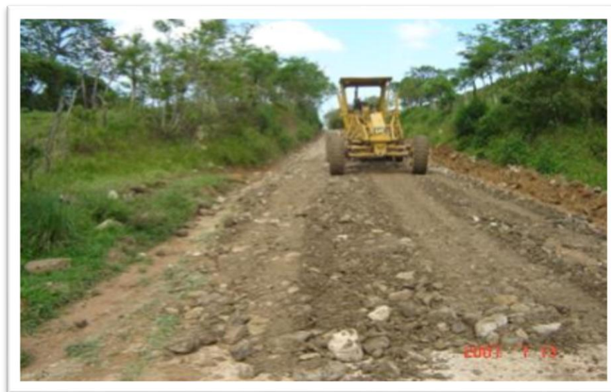
Foto 8.- compactación de material base
