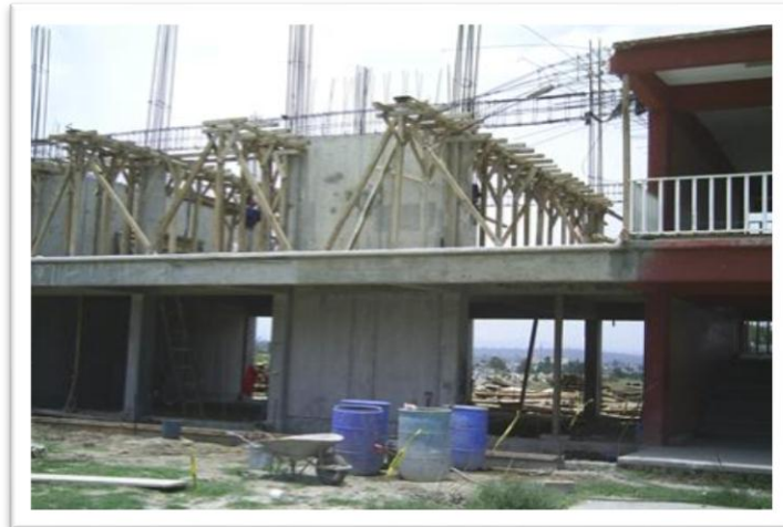
Foto 4.- armado de traves
