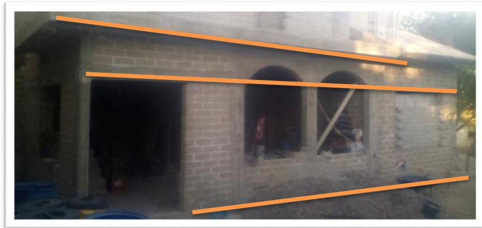
Foto 26.- EJE 7 (muro, cadena de cabezal y loza de entrepiso)
