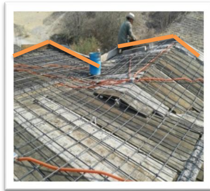
Foto 23.- Ejes 8, 7 y D (Armado loza)
