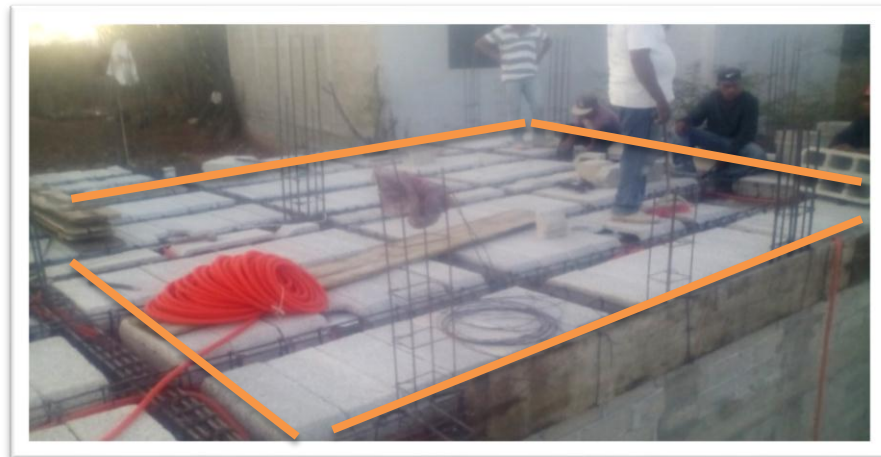
Foto 29.- EJES A, E, 5 y 8 (colocación de vigueta y bovedilla)
