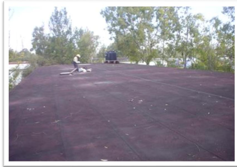
Foto 13.- preparación de área de trabajo
