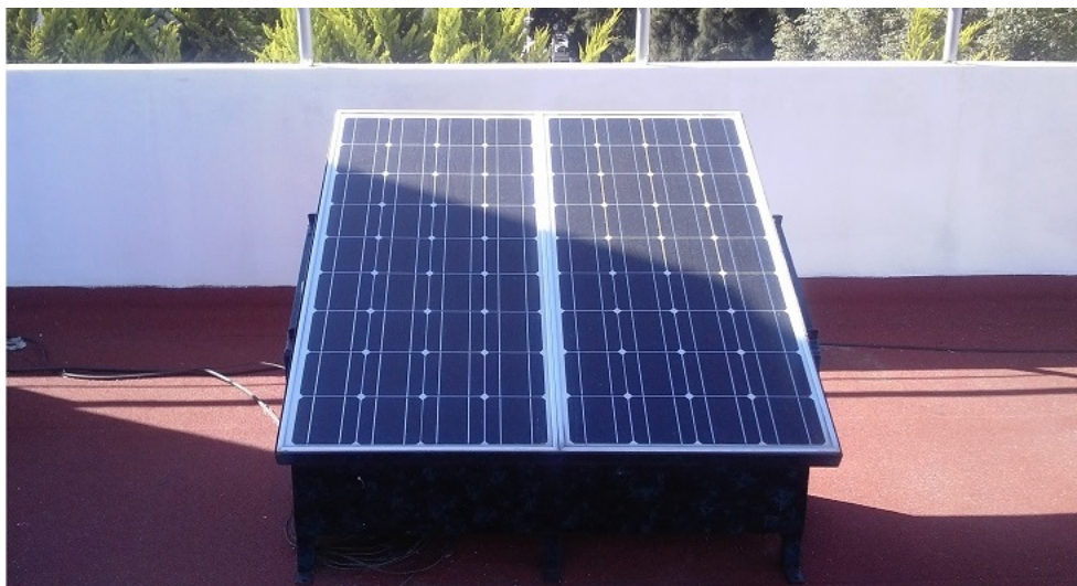
Figura 3.12: Sistema fotovoltaico aislado
