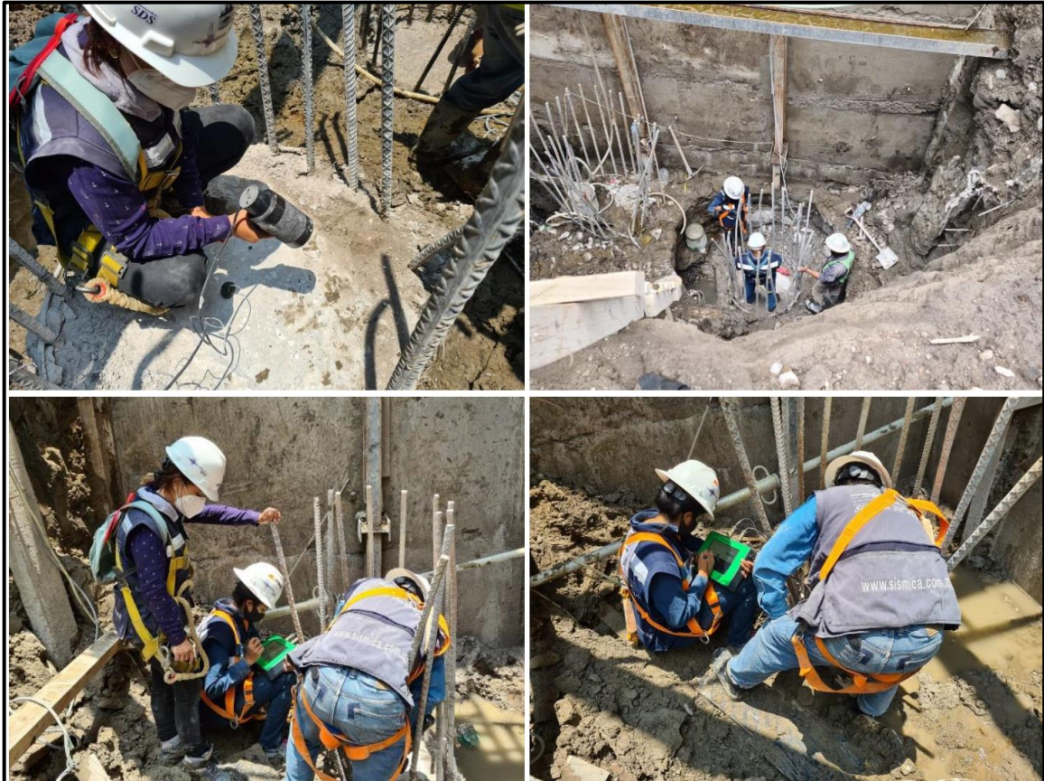
Figura 79. Trabajos de campo durante la ejecución de la prueba de integridad en la Pila P-27
