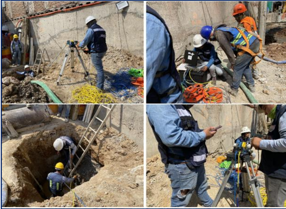
Figura 87. Equipo y ejecución de la prueba de CSL
