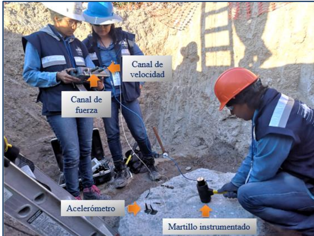
Figura 10. Equipo empleado y ejecución del ensayo TMR (SDS,2020)
