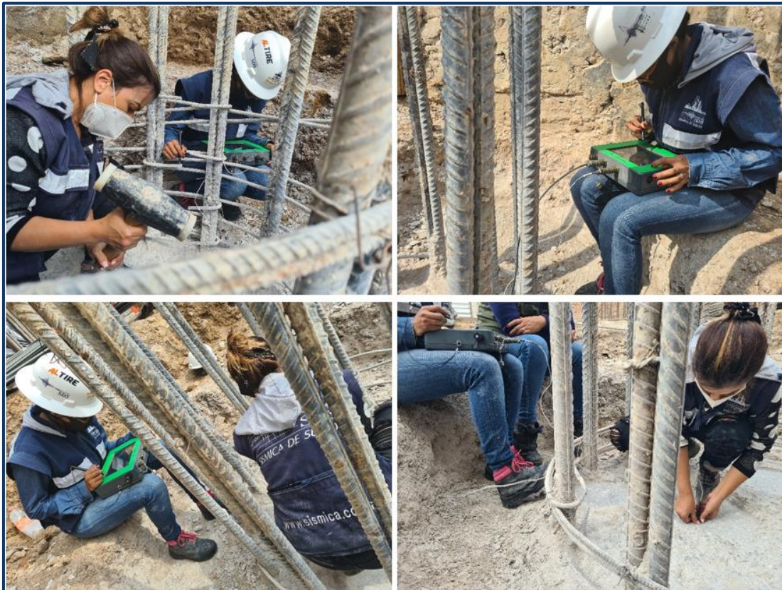
Figura 37. Equipo y ejecución de la prueba de integridad en pilas
