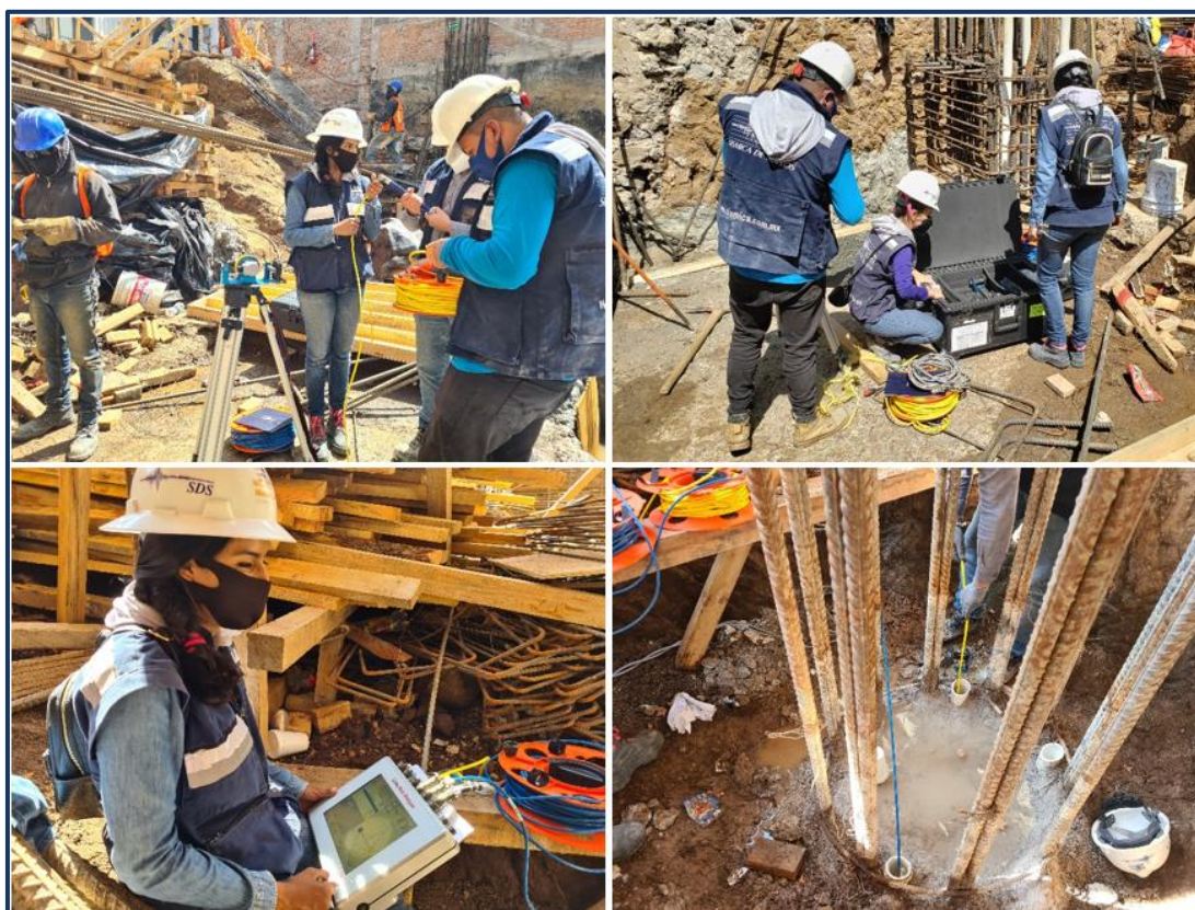
Figura 41. Equipo y ejecución del Cross Hole Ultrasónico
