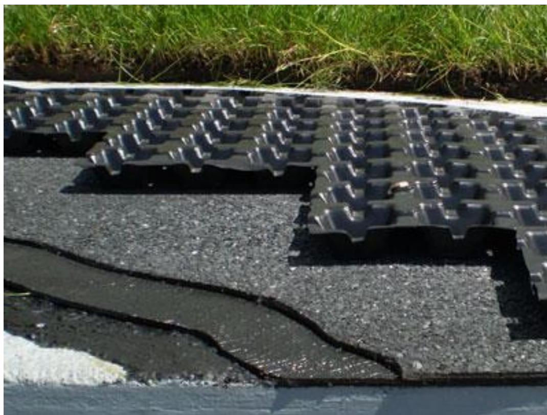
Figura 5. Vista al centro de una Capa Drenante
