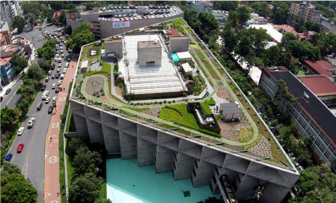
Figura 18. Vista Aérea de la azotea naturada del Edificio del Infonavit Fuente: Elaboración Propia
