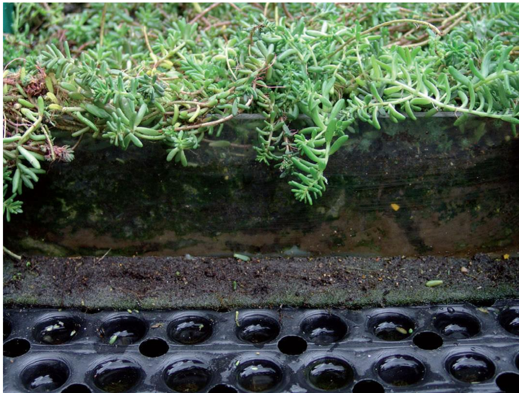
Figura 7. Corte donde se observa la Capa vegetal sobre parte del sistema
