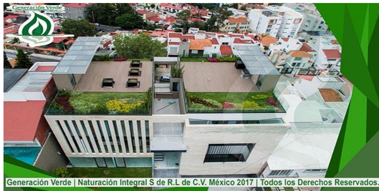
Figura 8. Techo Verde construido por Generación Verde
