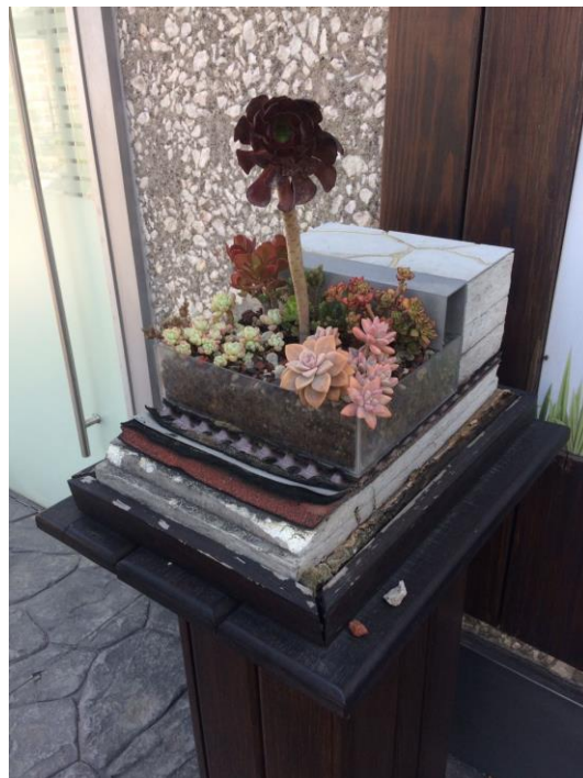
Figura 20. Estructura del sistema de Naturación utilizado en el edificio del Infonavit. Fuente: Elaboración Propia
