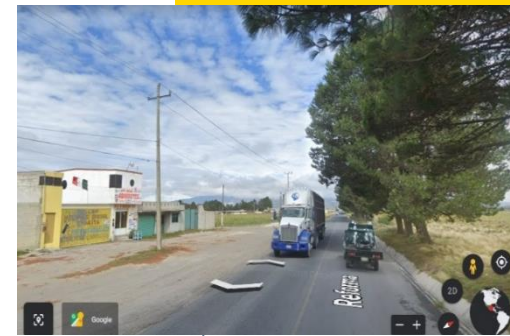
POSTES DE RED DE DISTRIBUCIÓN DE ENERGÍA ELÉCTRICA EN COLONIA EL VALLE
