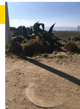
Pozo de visita (1) Tubería de 10"
