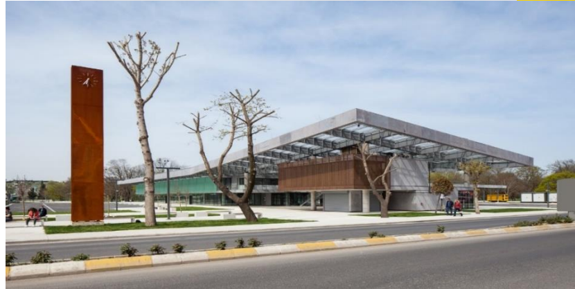
ESTACIÓN DE AUTOBUSES LÜLEBURGAZ
