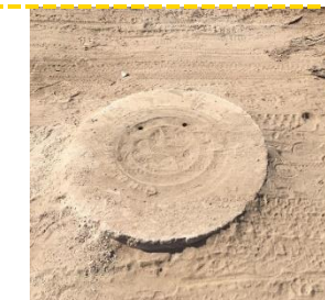
Pozo de visita (2) Tubería de 10"
