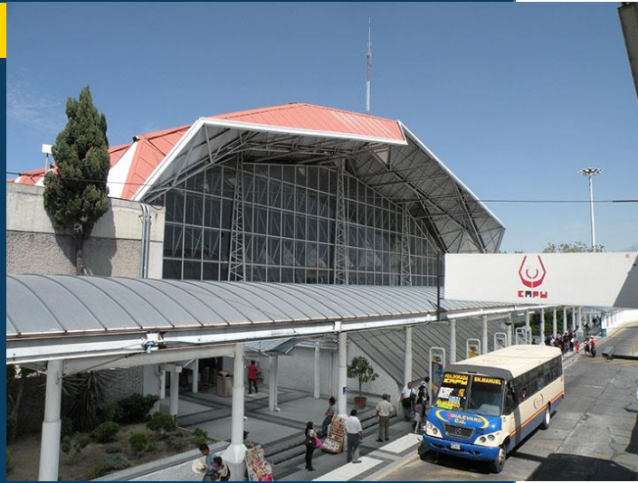
FACHADA PRINCIPAL DE LA ESTACIÓN DE AUTOBUSES
