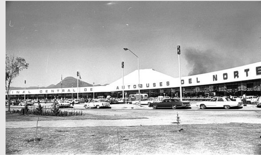
TERMINAL CENTRAL DE AUTOBUSES DEL NORTE, CIUDAD DE MÉXICO, (1973)
