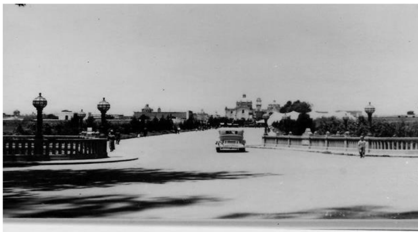
Fuente de Consulta: Puentes del Río San Francisco Puebla.
