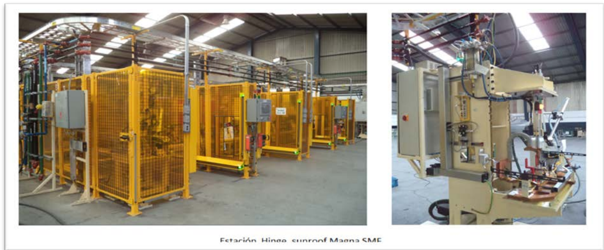
Figura 31. Montaje en las instalaciones de FFT
