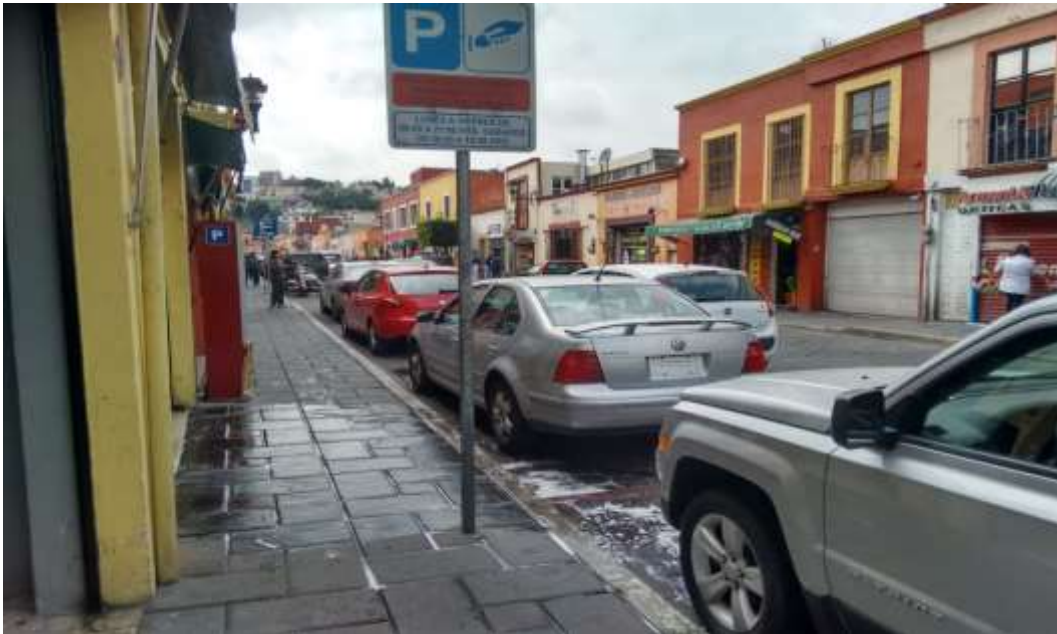
Figura V.18.- Parquímetro instalado sobre Avenida 20 de Noviembre.
