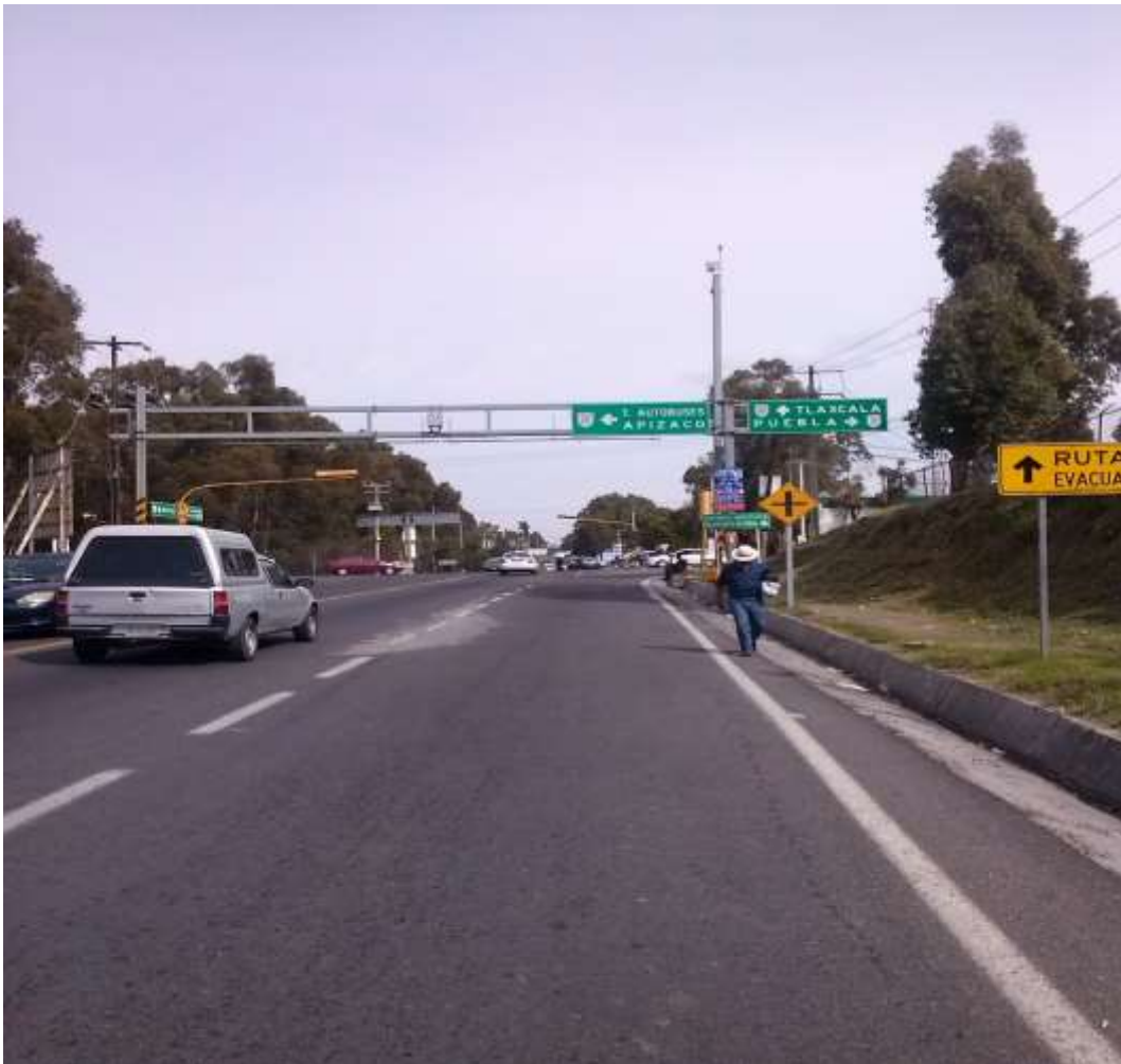
Figura III.10.- Falta de señalamiento vial que restringe el paso de vehículos doble rodada al centro de la Ciudad.
