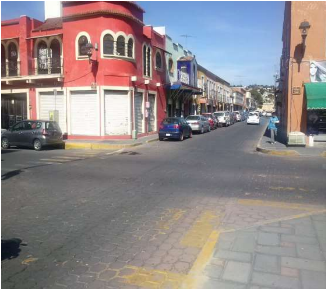
Figura III.24.- Cruce Peatonal sin Señalamiento Horizontal para Cruce de Peatones.
