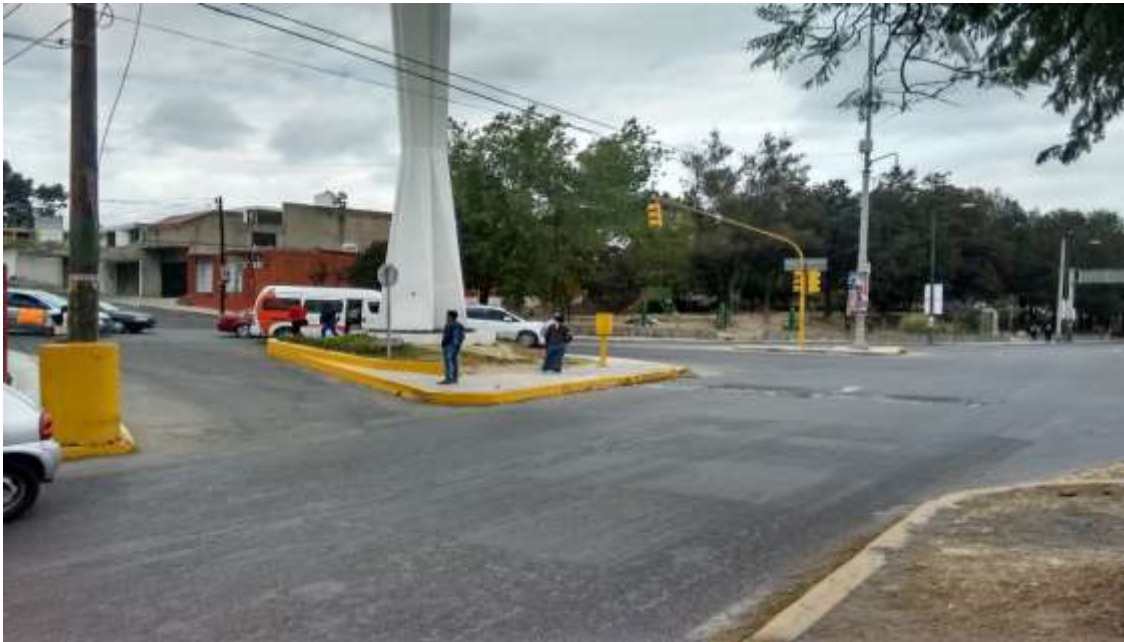
Figura IV.38.- Isleta canalizadora que no cumple con especificaciones técnicas.
