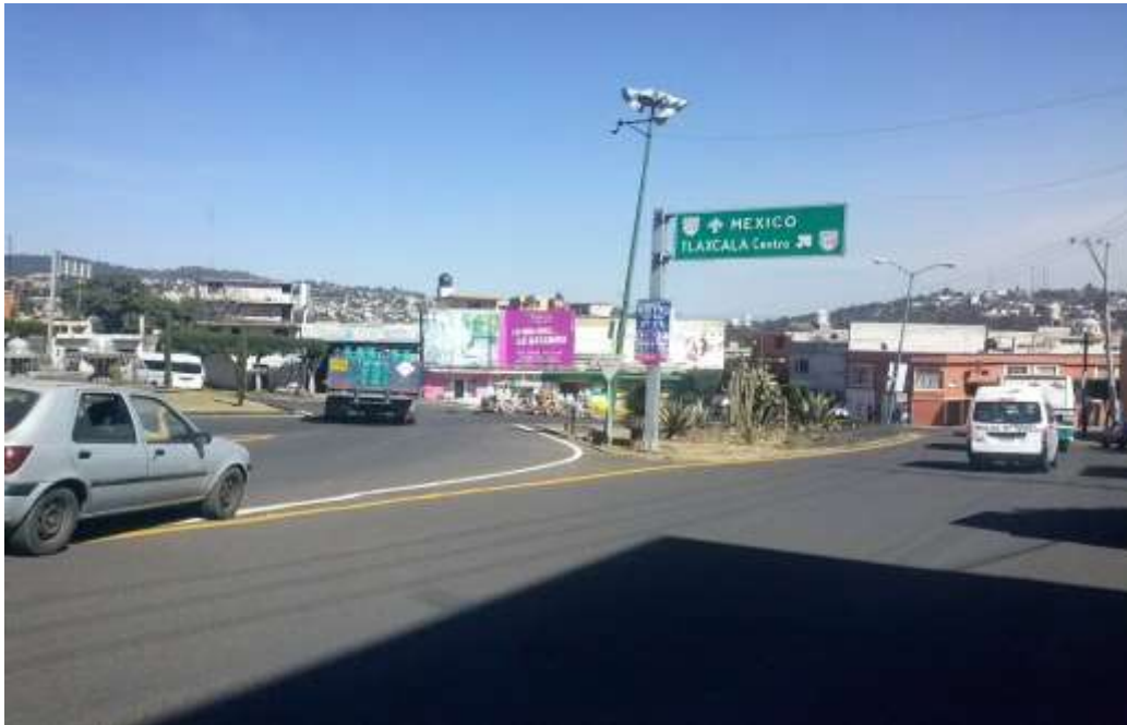
Figura III.20.- Estado que guardan las señales informativas de destino elevadas.
