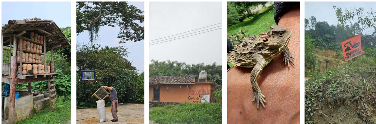
Figura 21. Construcciones y viviendas en abandono dentro de la RTP-105 (fotografías propias, 2023).
