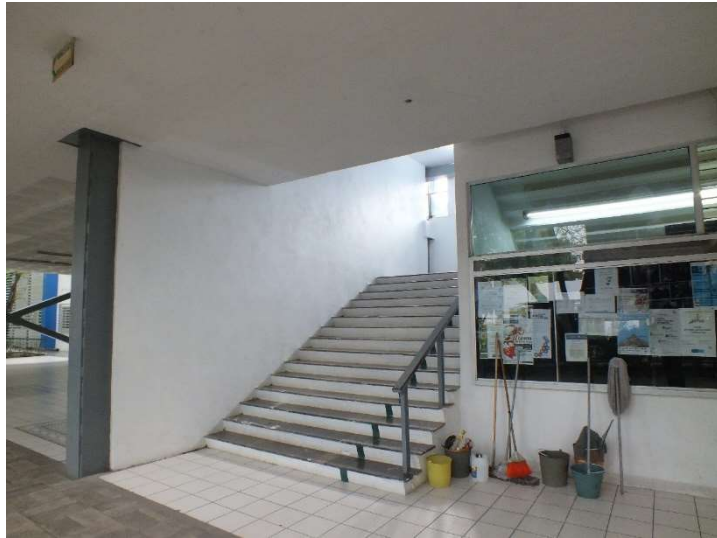
Imagen A. 5. Cubo de escaleras (vista Planta Baja).
