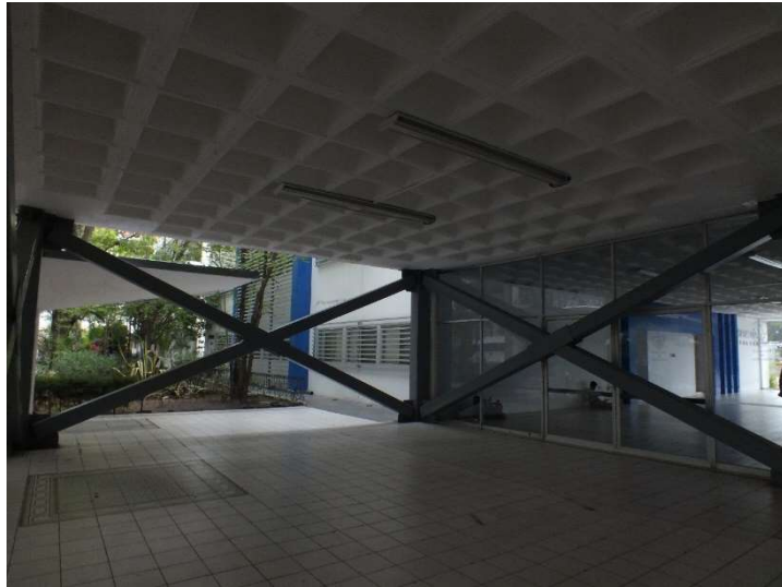
Imagen A. 3. Vista sureste del edificio.
