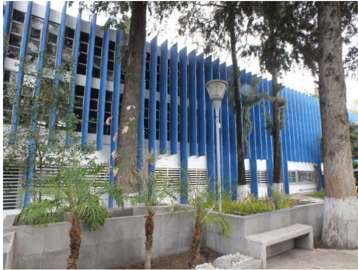
Imagen A. 1. Fachada sur del edificio.
