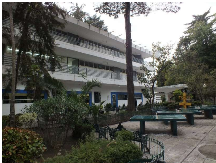
Imagen A. 2. Fachada norte del edificio.
