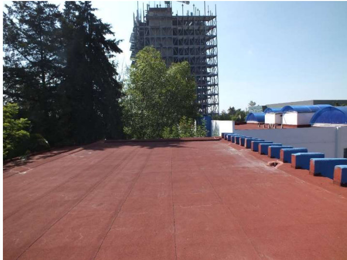
Imagen A. 7. Azotea (Vista este).
