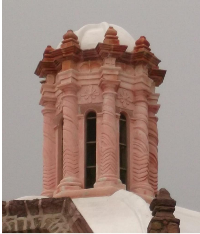
Imagen 50. Linternilla de la cúpula del transepto de la iglesia del convento franciscano de Zacatecas, 2020.
