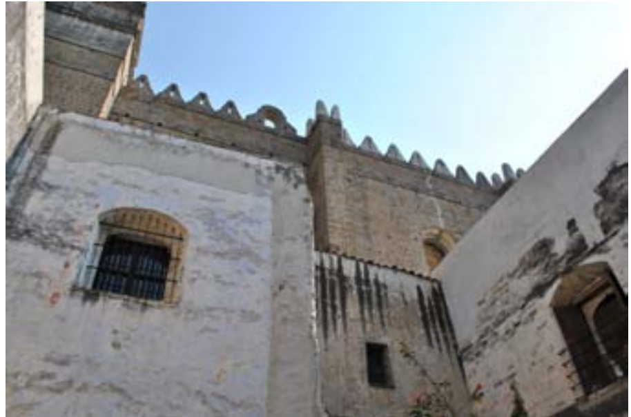
Figura 39: El edificio del convento, Huejotzingo (Elaboración Propia, 2013)
