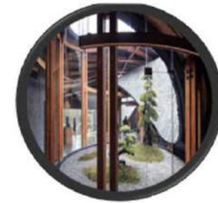
Estructura de madera prefabricada en su 70%.
