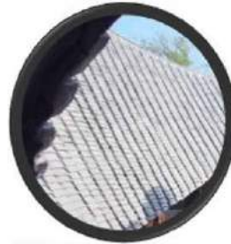
Cubierta con tejas
