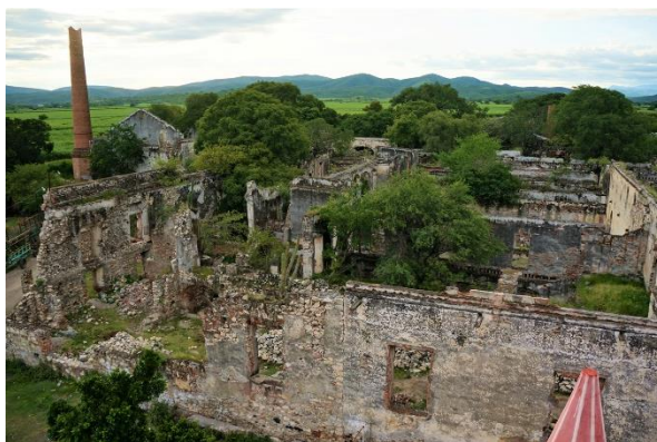
[Fig. 2.44] Estado actual de la casa del hacendado en el ingenio San Juan Colón. Fuente: Morán. 2020.
