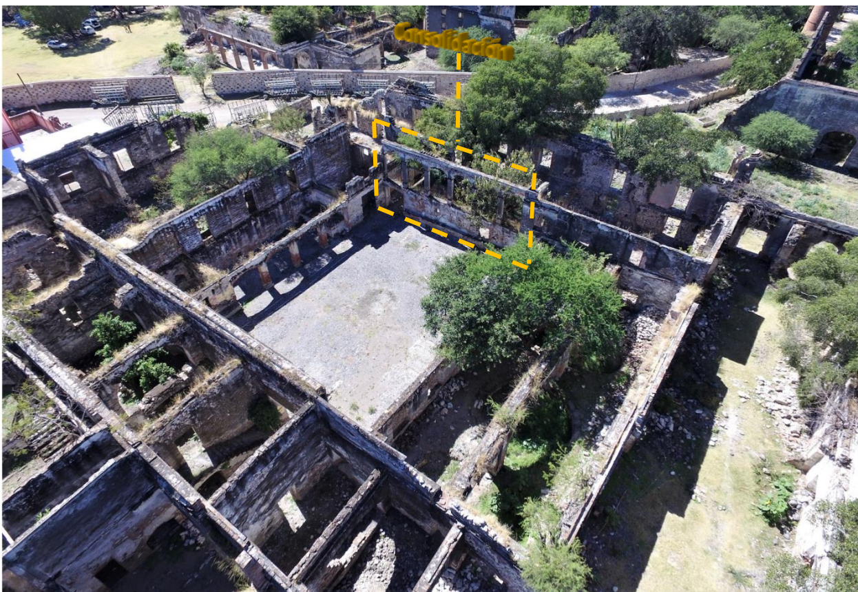
[Fig. 4.20] Fachada interior norte, elemento susceptible de consolidar. Fuente: Morán 2022. Fotografía: Sánchez, P. 2021
