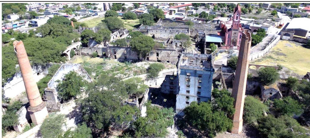
[Fig. 2.48] Conjunto arquitectónico del ingenio San Juan Colón en estado de ruina. Fuente: Sánchez, P. 2021.
