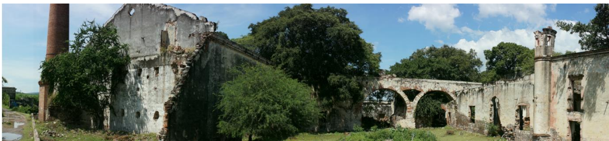
[Fig. 2.37] Panorámica actual del ex ingenio San Juan Colón. Se observa la ruina de la nave industrial, el acueducto, almacén y parte de la casa grande. Fuente: Morán. 2020.
