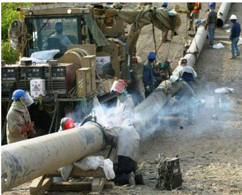
Figura 4.7.- Las fallas estructurales en sistemas de tuberías, ocasionan una gran movilización de recursos (humanos, materiales, económicos, etc.). Afectando la economía de los países y de su población.
