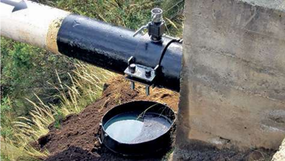
Figura 4.9.- La imagen establece una situación de alto riesgo, el empotramiento de una tubería y una tubería debilitada por un inserto realizado en las peores condiciones de seguridad, ocasionando hasta 5 mil mdd, de pérdida anual por robos a Pemex 17
