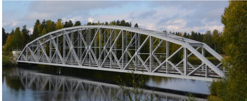
Figura III.4 Puente de Armadura. Puente Suecia, Boden, Fuente: Pxhere, https://pxhere.com/es/photo/658371
