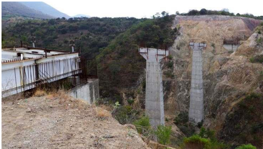
Figura IV.4 Topografía abrupta en la zona del Viaducto Km 117+174. Fuente: Al México
