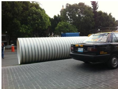
Fotografía 19. Intervención de la Av. 11 sur Fuente: Archivo ROQ
