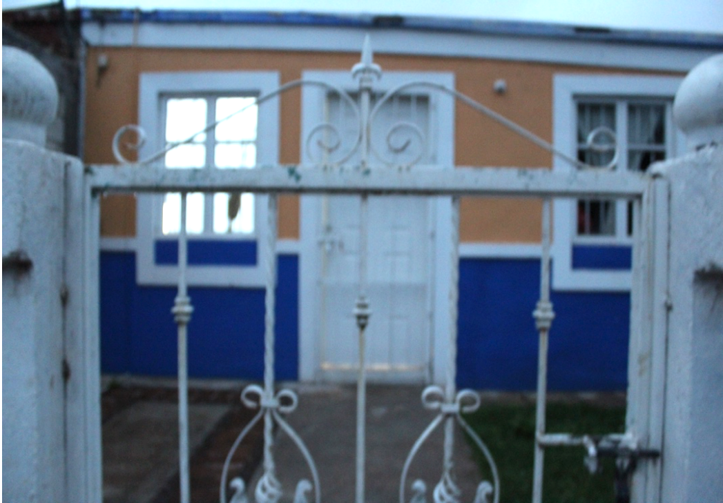
Figura 17. Fachada de una de las veinte casitas
