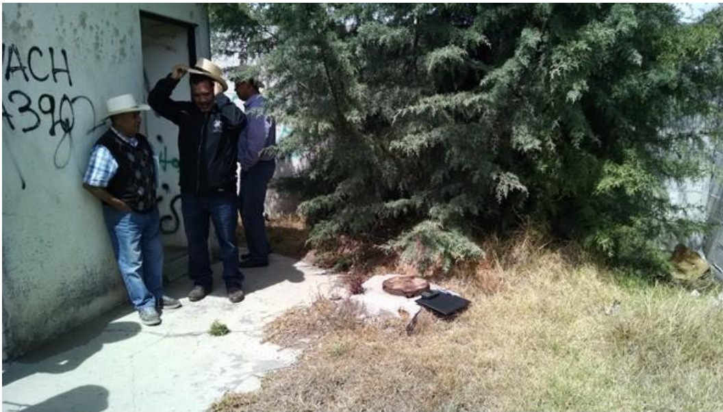
Fotografía No. 34. Pozo Bachilleres cuyas coordenadas geográficas son: 19° 01' 44.1" de latitud norte y 97° 57' 58.60" de longitud oeste, con una altitud de 2 299 m.s.n.m.
