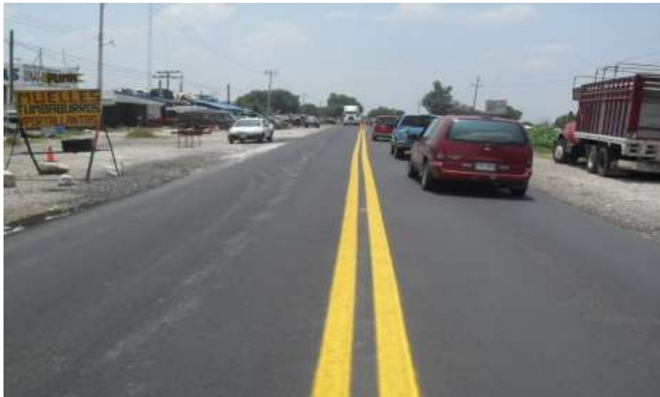
Foto 1. Tramo: Puebla-T San Hipólito, de la Carretera: Puebla-Tehuacán, km. 37+000, en el Estado de Puebla.
