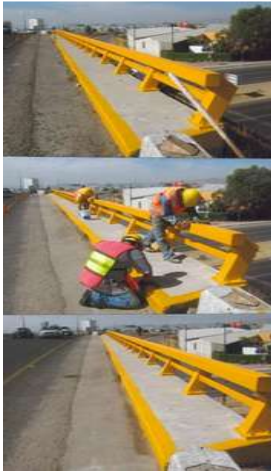
Foto 3. Trabajos de Conservación Rutinaria del Puente Agelópolis I, Carretera: Puebla-Huajuapán de León, Tramo: Puebla-Atlixco, km. 5+800, en el Estado de Puebla.
