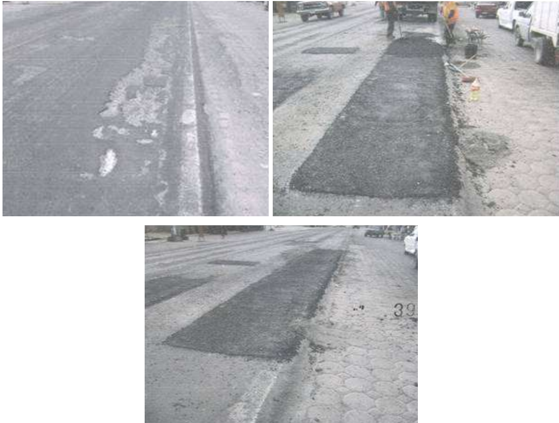
Foto 2. Trabajos de Conservación Rutinaria del Tramo: "T" San Hipólito-Lim. De Edos. Pue/Ver., de la Carretera: Puebla-Jalapa, km. 35+000, en el Estado de Puebla.
