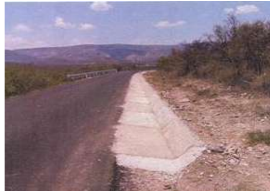
Foto 4. Trabajos de Conservación Periódica de la Carretera: Tehuacan-Huajuapán de León, Tramo: Tehuacan-Lim. De Edos. Pue./Oax., km. 35+000, en el Estado de Puebla.
