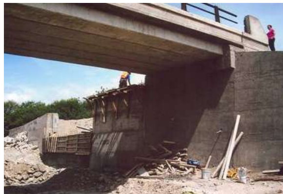
Foto 6. Trabajos de Reconstrucción del Puente Río Zapotitlan, Carretera: Tehuacan-Huajuapán de León, Tramo: Tehuacan-Lim. De Edos. Pue./Oax., km. 31+900, en el Estado de Puebla.
