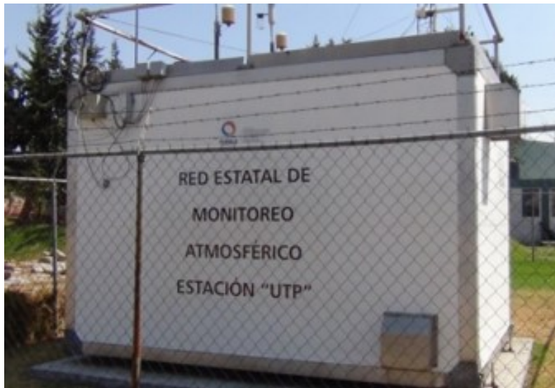
Figura 1.1: Estación de monitoreo atmosférico del municipio de Puebla (Figura extraída de https://calidaddelaire.puebla.gob.mx/views/principal_monitoreo.php ).
