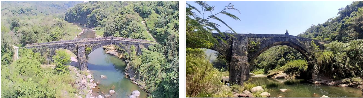
Figura 22 Fotografías del puente antiguo en el río Ajajalpan que comunica a San Felipe Tepatlán con sus comunidades.
