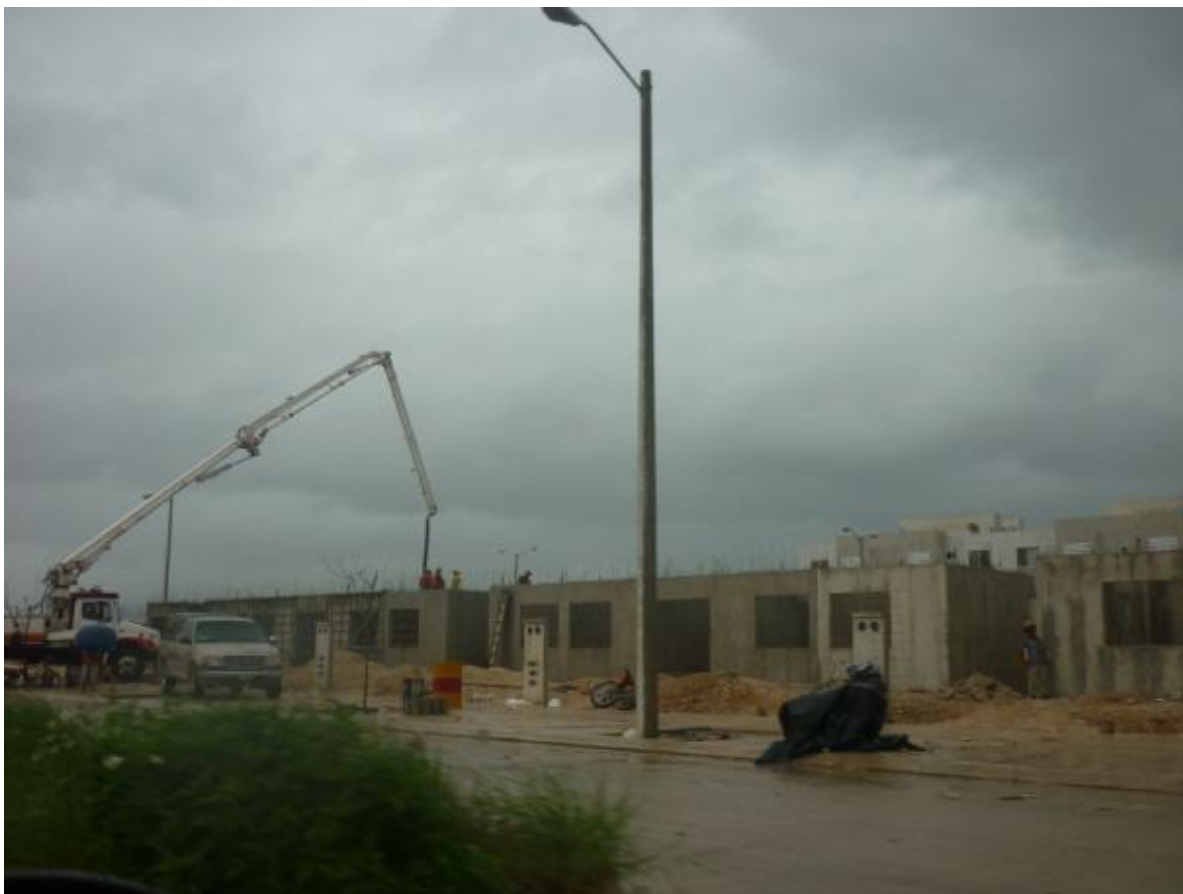
Imagen 55.- Viviendas pertenecientes al fraccionamiento “Prado Norte”, edificadas con concreto.
