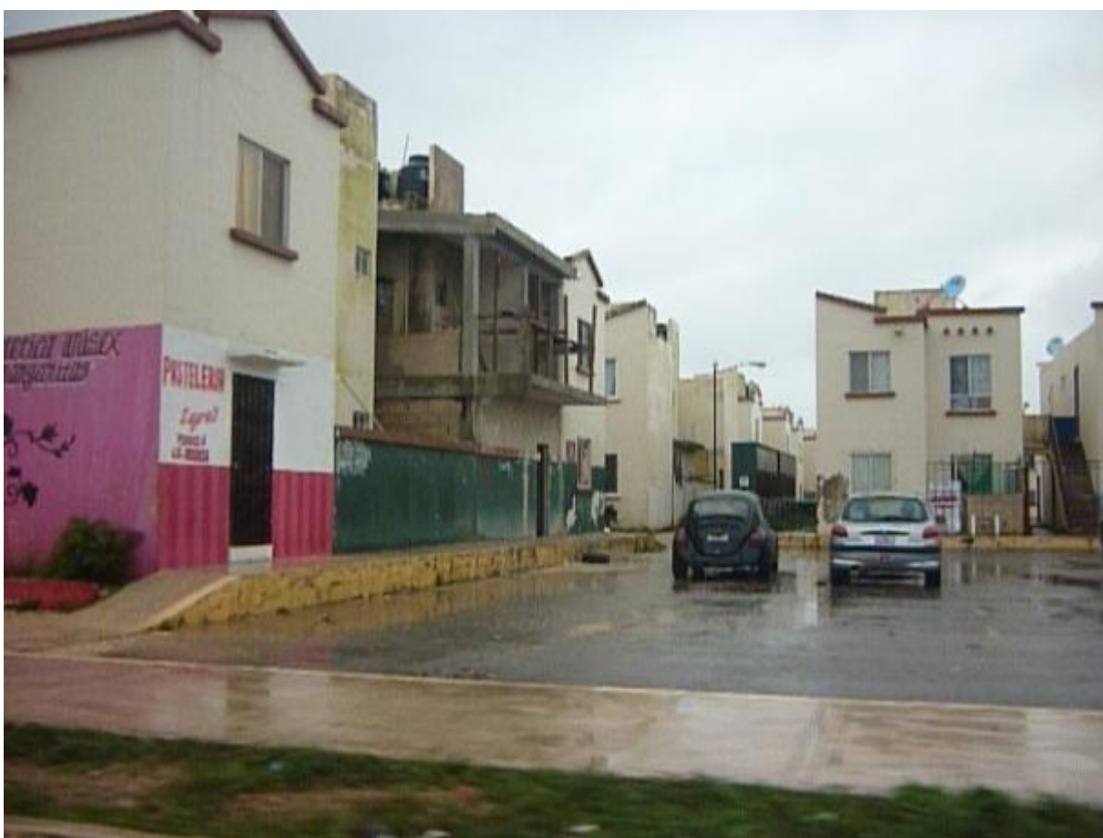
Imagen 42.- Adecuación al interior de vivienda, sacrificando el área de sala-comedor, para establecer una estética y pastelería.
