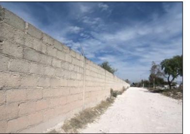
Foto 12: vista de la calle Ciruelas Fuente: visita en campo
