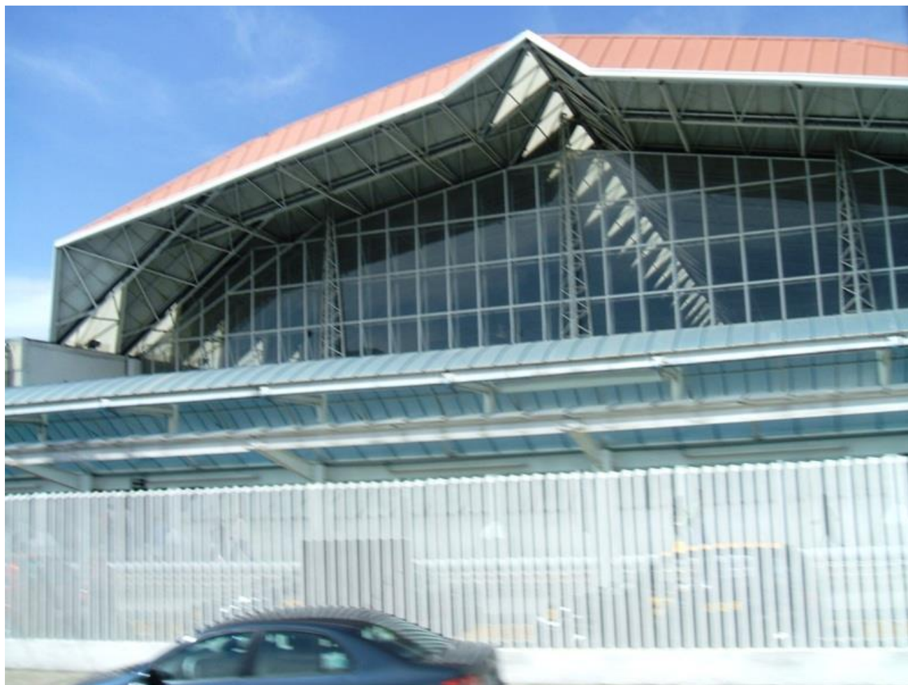
FACHADA SUR DE LA CAPU
