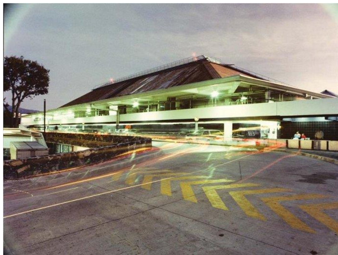
PASO A DESNIVEL PARA ACCESO PÚBLICO A LA CAXA
