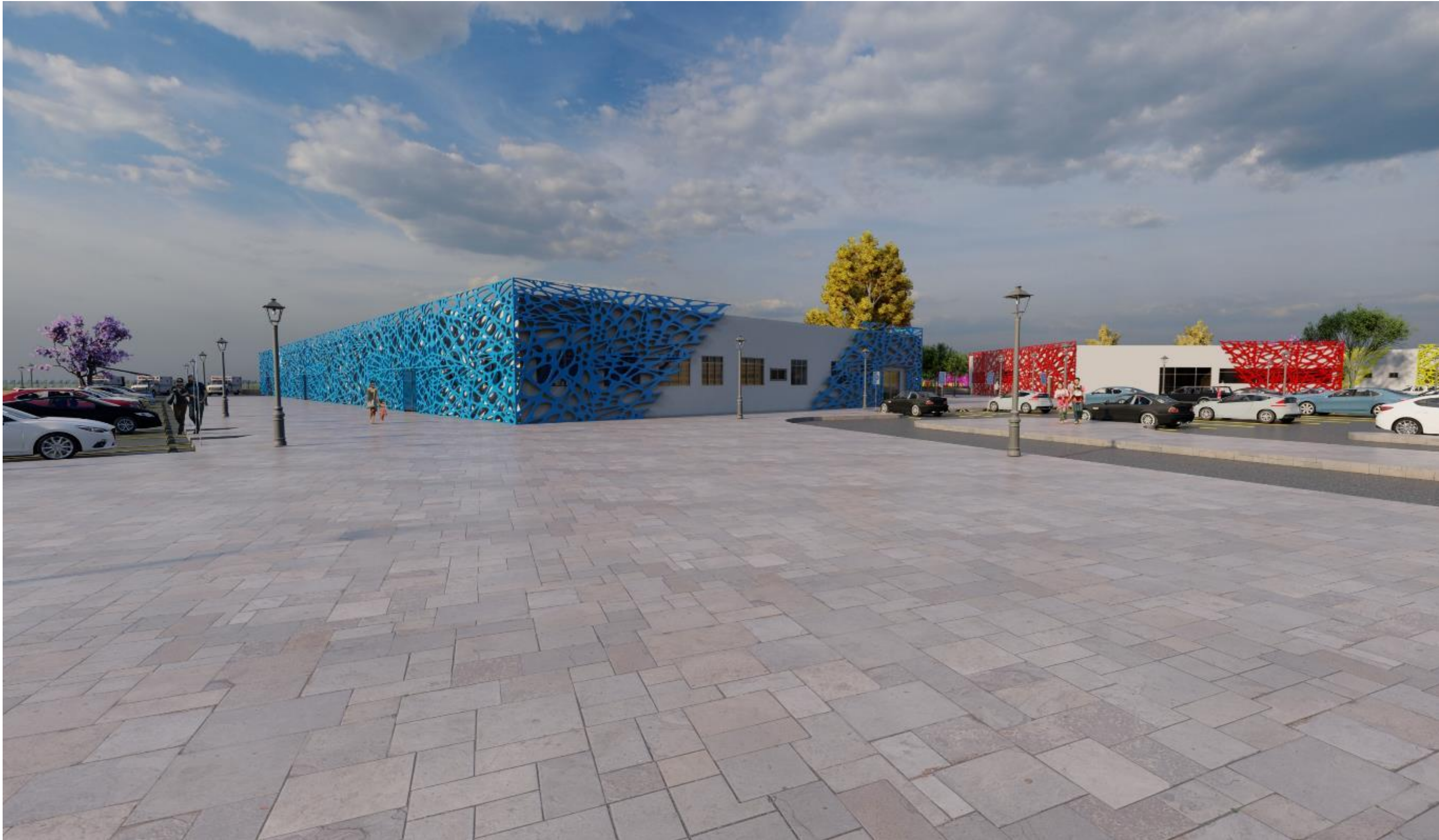
Vista desde acceso peatonal a Bloque 1 y Zona Pública
