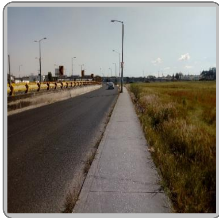
Figura 41. Lateral del periférico ecológico y predio. Fotografía por los autores.
