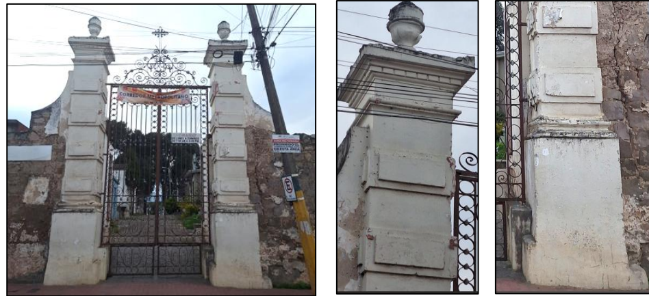
Pórtico de acceso estilo neoclásico. Se muestran detalles de los elementos que lo componen. Fuente: Karla Vélez Ochoa. Septiembre 2014.
