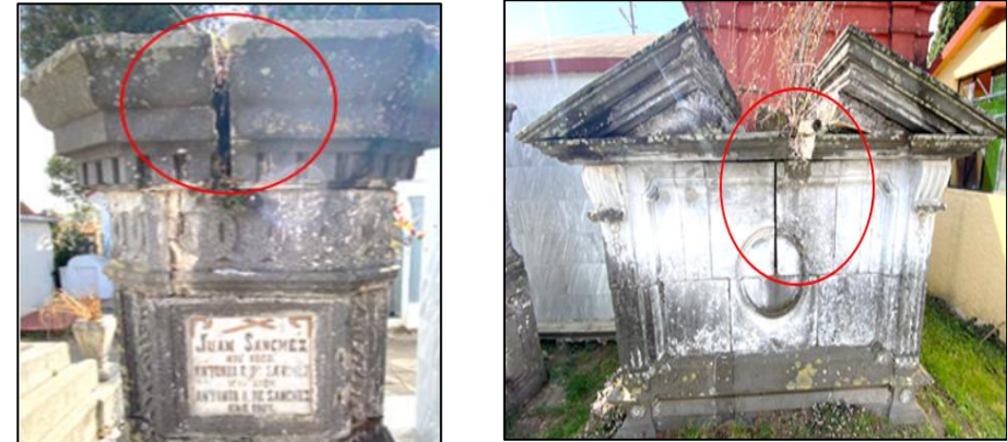
Pérdida de junta, fracturas y el desplazamiento de piezas estructurales que conforman los monumentos. Fuente: Karla Vélez Ochoa. Marzo 2024
