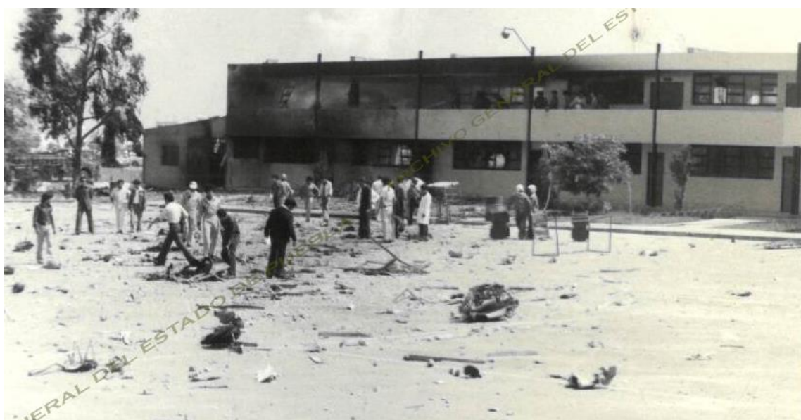
Imagen 54: Vista interior del edificio de aulas de la Ciudad de los Niños donde impactó la aeronave, se aprecian las huellas de la explosión y el incendio que provocó. Fotografía proporcionada por el Archivo General del Estado de Puebla.
