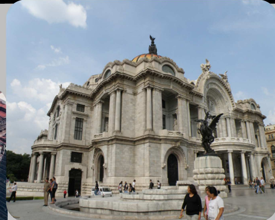
Fachada sur-oeste, Fuente. R. Galdámez https://vivearquitectura.wordpress.com/2010/07/20/bellas-artes/
