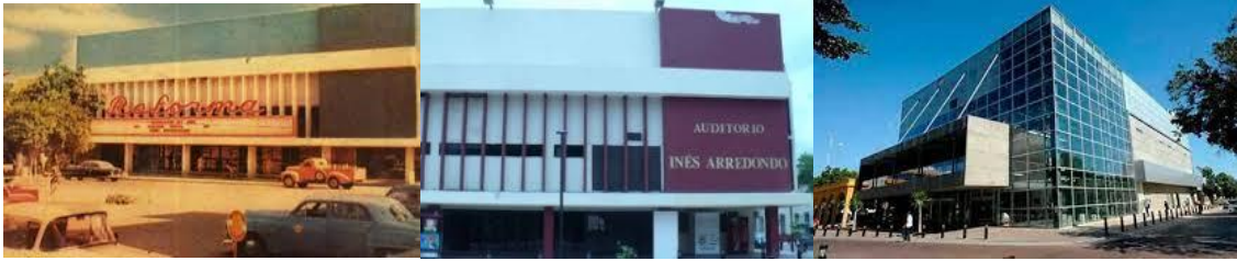
Figura 9. Transformación del edificio que aloja el Museo Interactivo de Adicciones (MIA), antes Auditorio Inés Arredondo/Cine Reforma
