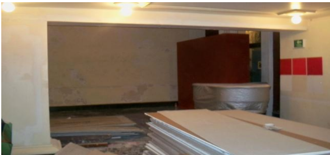
Imagen 12. Paneles de yeso almacenados en el vestíbulo principal.
