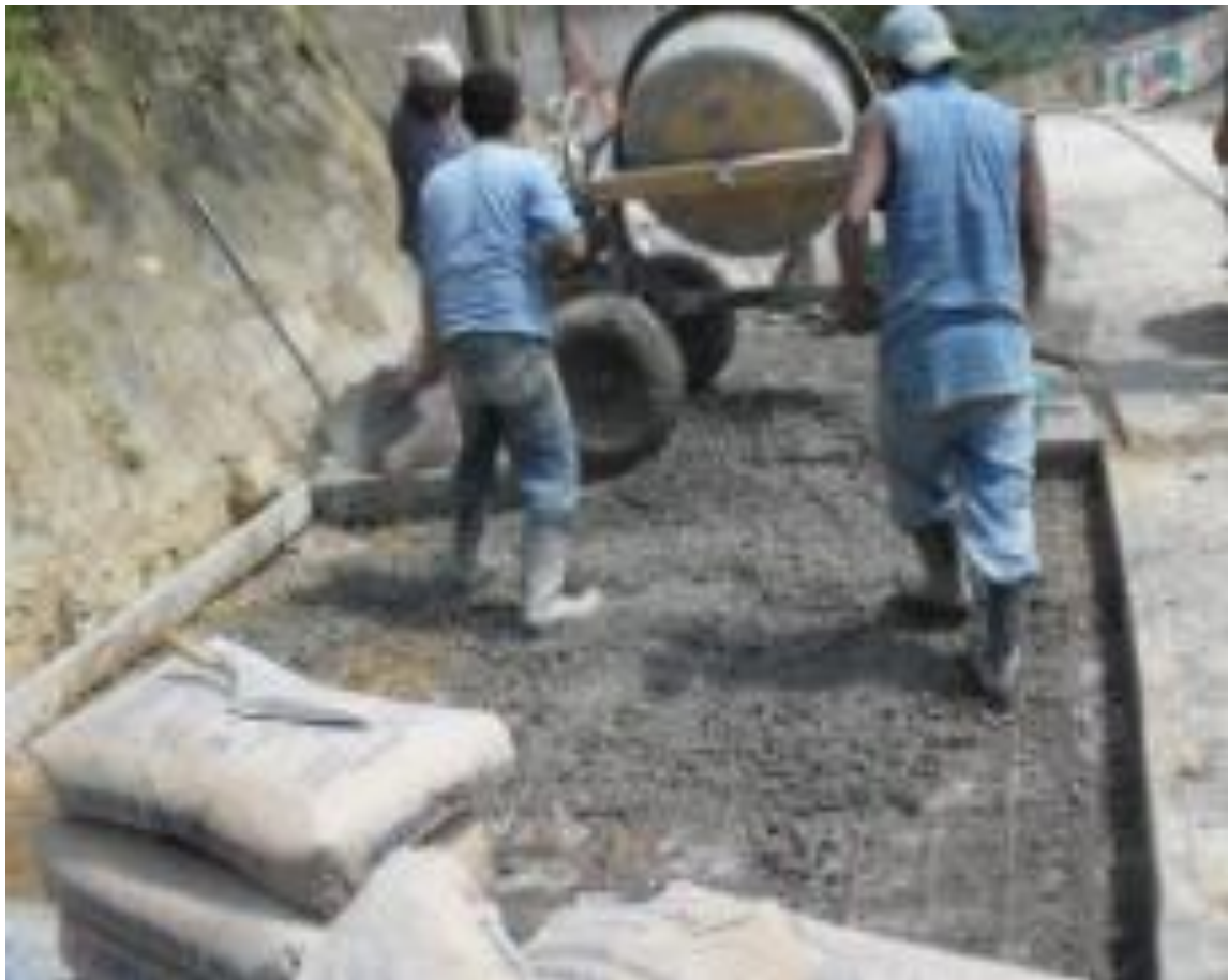
Imagen 40. Colado de concreto por medios mecánicos.
