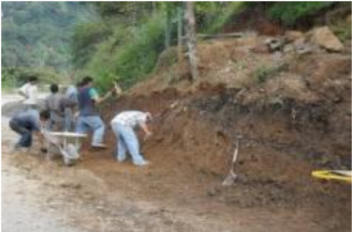
Imagen 30. Afine de talud para colar guarniciones
