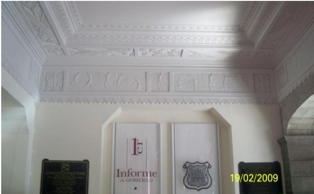
Imagen 15. Aplanado fino en muros del vestíbulo principal a base de mortero de yeso.
