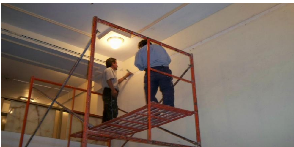
Imagen 2. Desmonte de molduras de madera en muros del vestíbulo principal.
