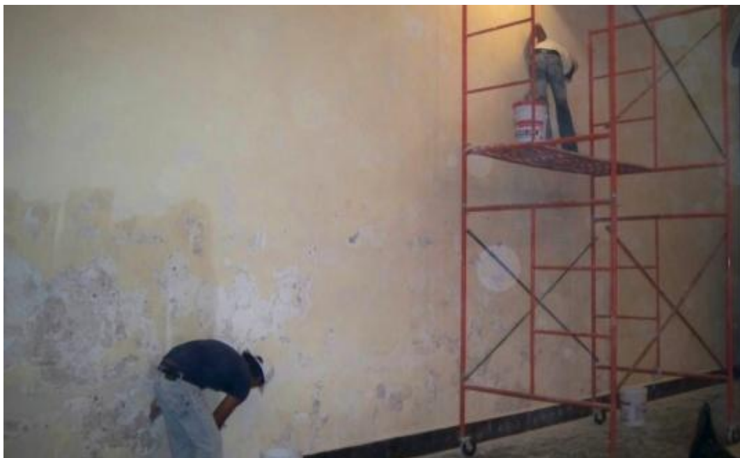
Imagen 13. Preparación de muros del vestíbulo principal para recibir acabado de yeso.
