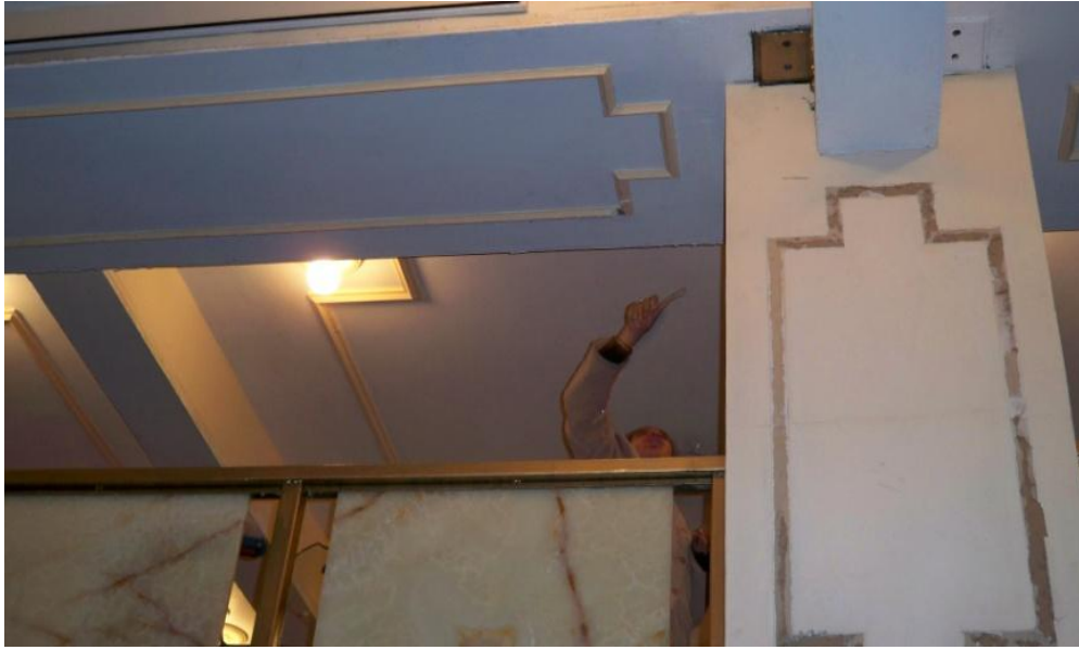
Imagen 3. Desmonte de molduras de madera en columnas del vestíbulo principal.
