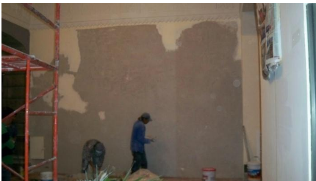
Imagen 14. Aplanado fino en muros del vestíbulo principal a base de mortero de yeso.
