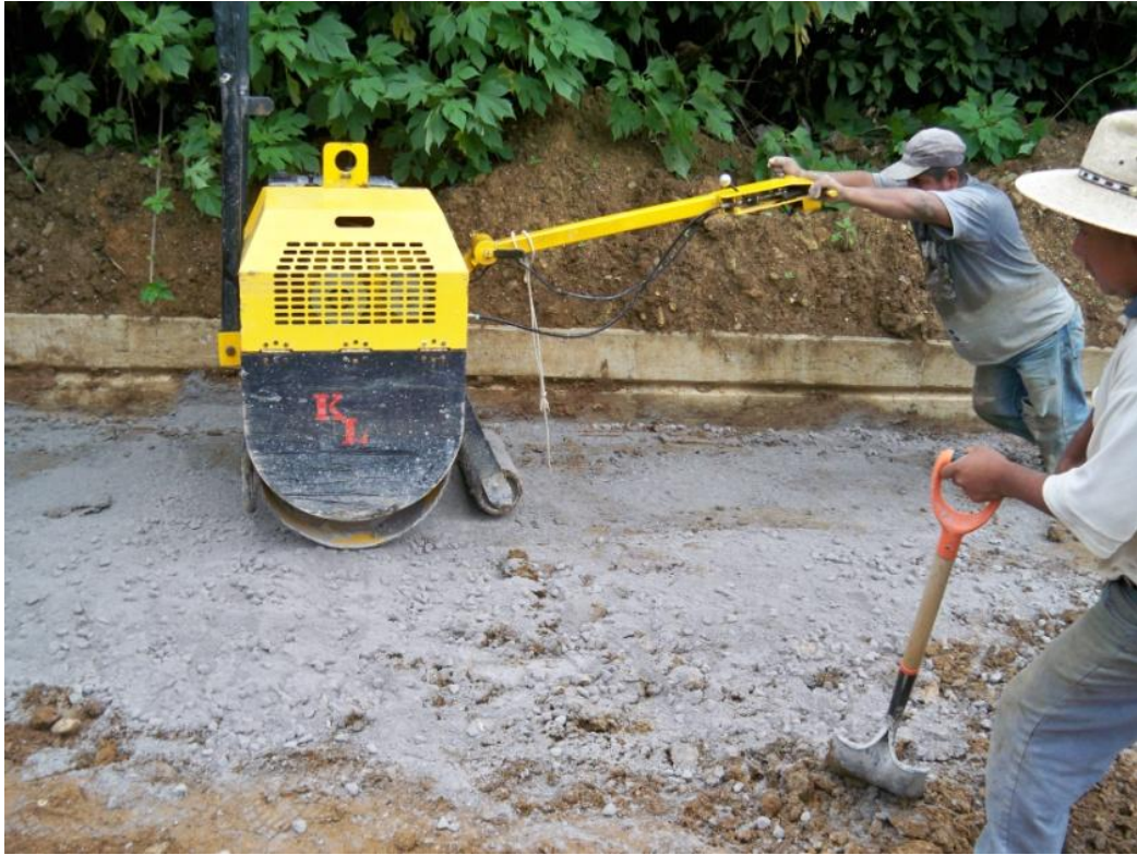
Imagen 28. Rodillo compactador vibratorio PR-8.
