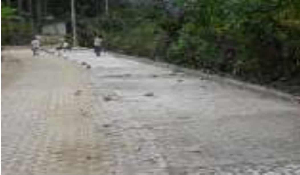
Imagen 41. Obra terminada, “Pavimentación de calle principal de concreto hidráulico” .
