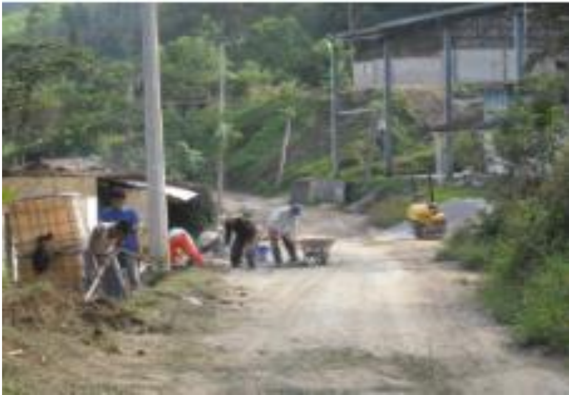
Imagen 31. Fabricación y colado de concreto en guarniciones
