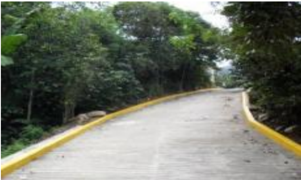
Imagen 42. Obra terminada, “Pavimentación de calle Miacaco de concreto hidráulico” .
