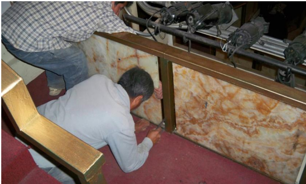
Imagen 4. Desmonte de paneles de Ónix.
