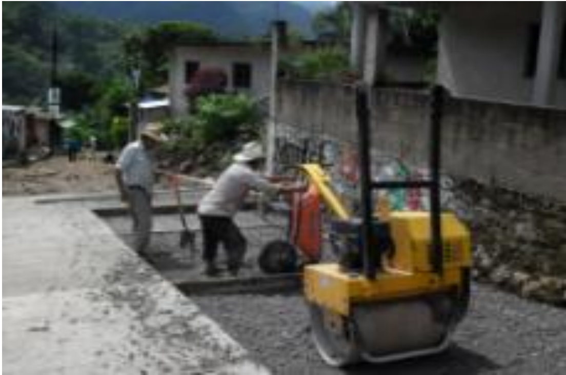
Imagen 35. Compactación de la base hidráulica.
