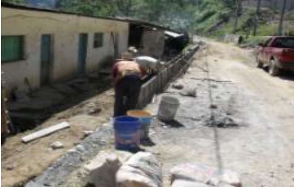
Imagen 32. Fabricación y colado de concreto en guarniciones.
