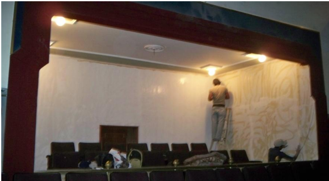
Imagen 7. Afine y preparación de muros en palco principal.
