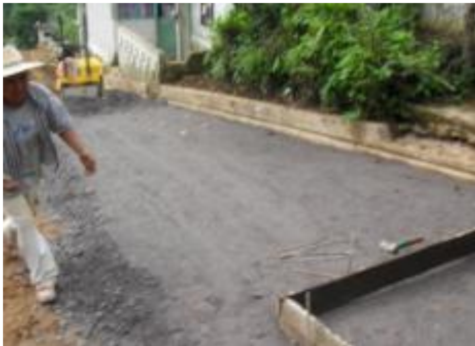
Imagen 37. Base hidráulica (espesor).
