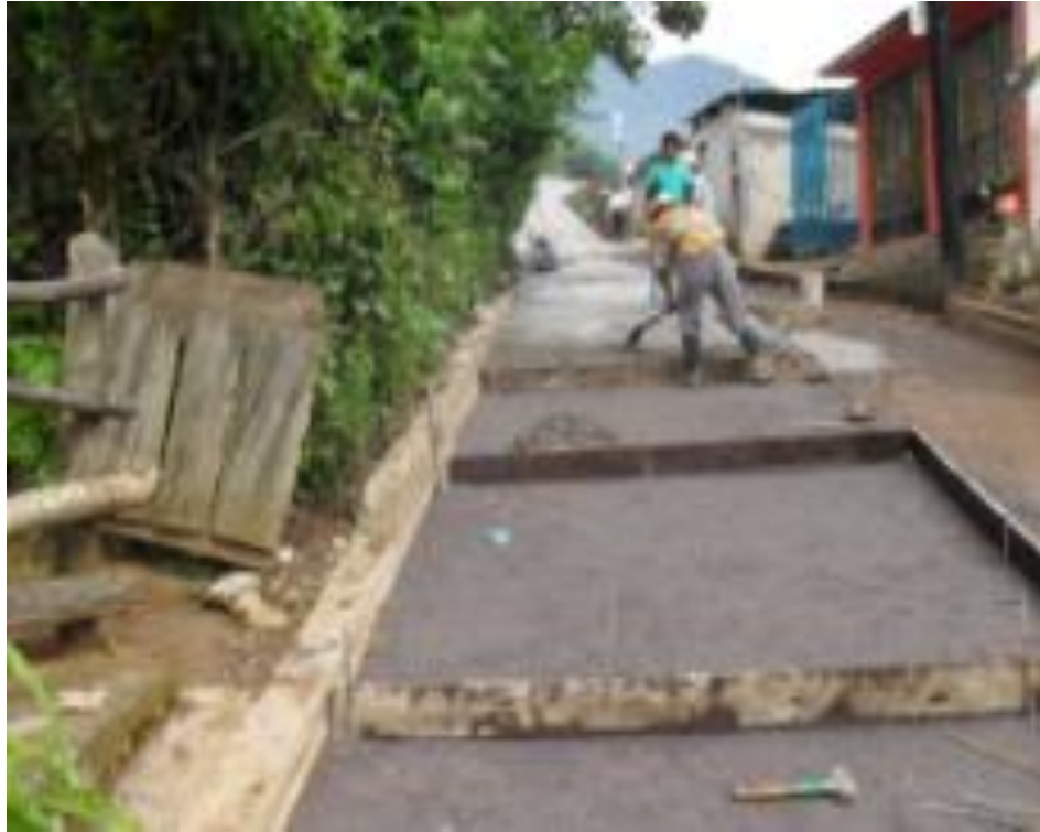
Imagen 36. Protección de la base hidráulica.
