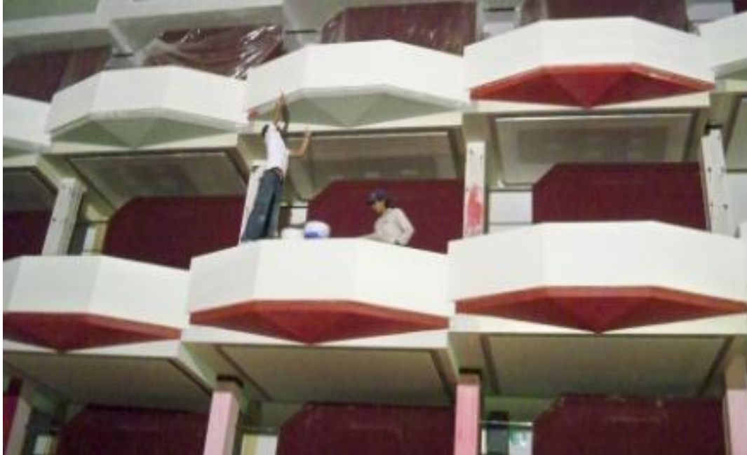
Imagen 6. Fabricación de cajillos y barandales en palcos.
