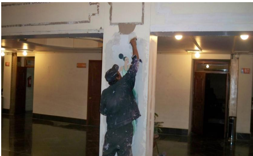
Imagen 5. Restauración de columnas, muros y plafones en el vestíbulo principal.
