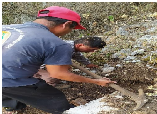
Figura 36. Proceso de excavación efectuado por los recolectores de la localidad de Jalcomulco.
