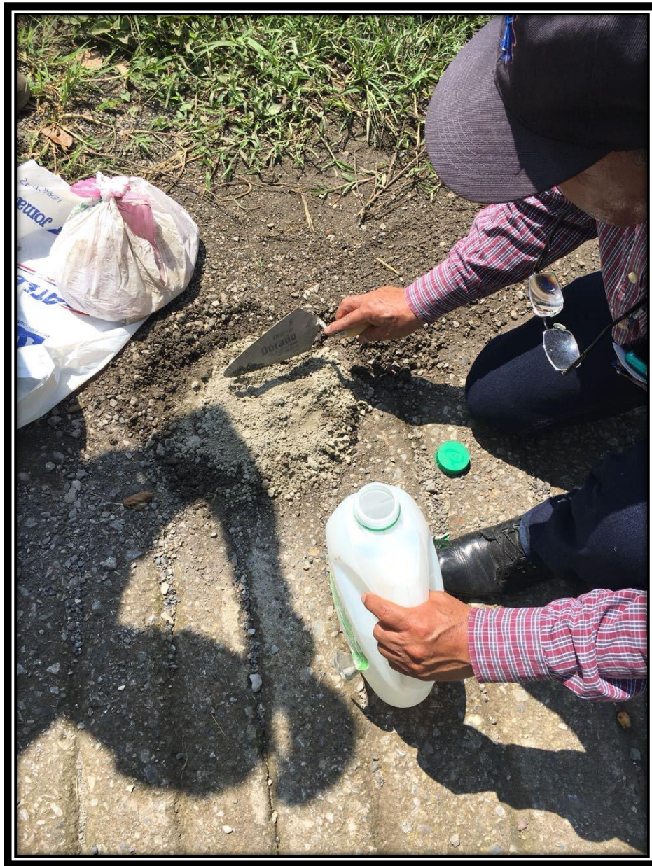
Fig. 38 Uso de concreto para garantizar la conservación de los puntos de control.
