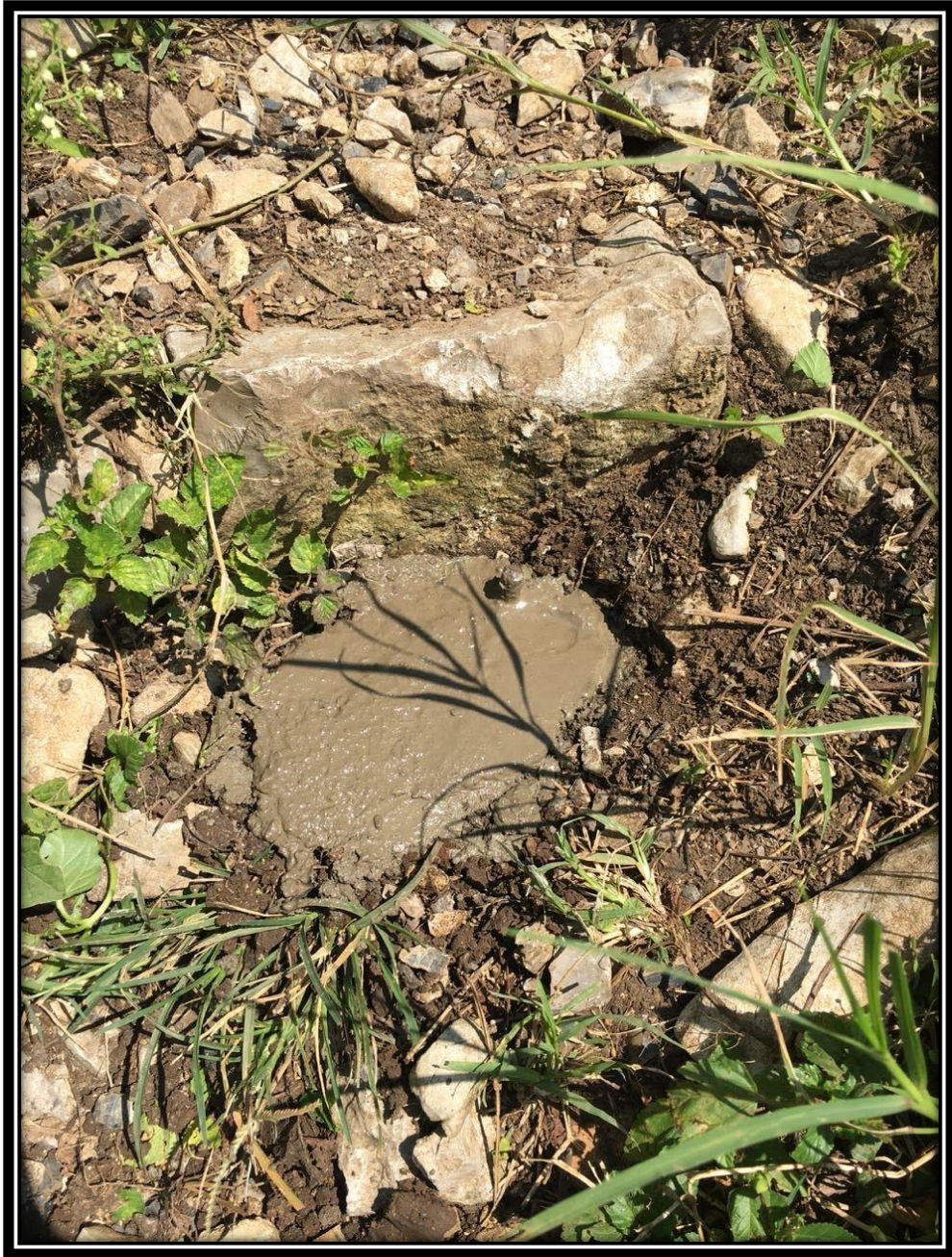
Fig. 39 Monumentación con varilla y concreto para reforzar.
