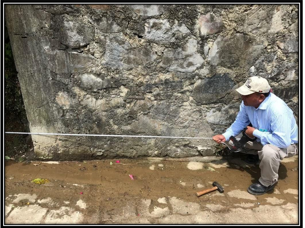
Fig. 30 Tomando la distancia LZ de la estación.
