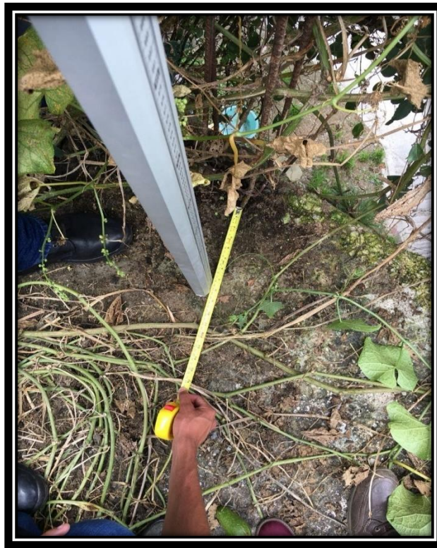
Fig. 25 colocación de una de las bases sobre varilla existente. Sitio Don Juan
