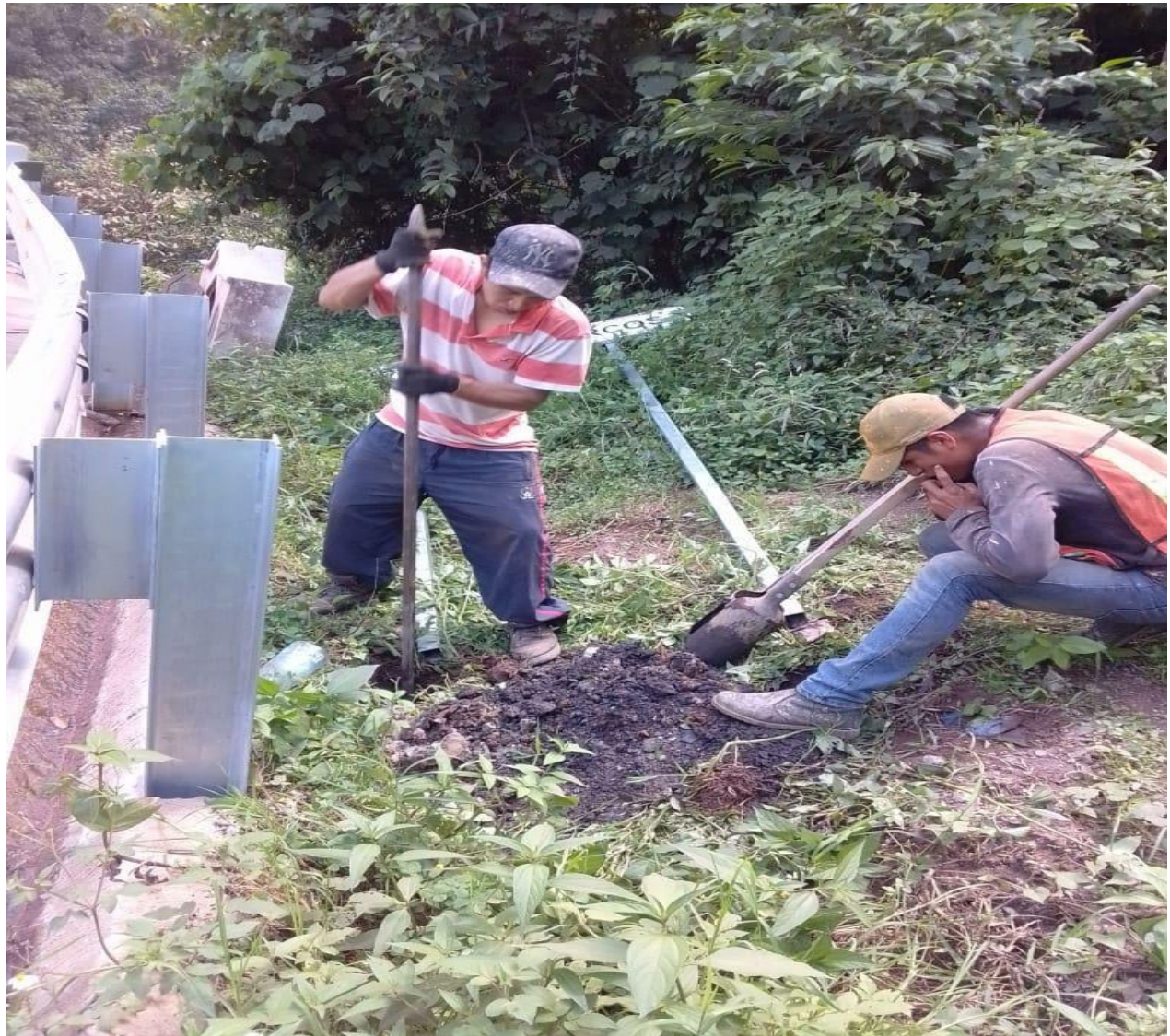
Figura LXXXV. Autoría propia. Excavación para colocación de postes para señal informativa,
