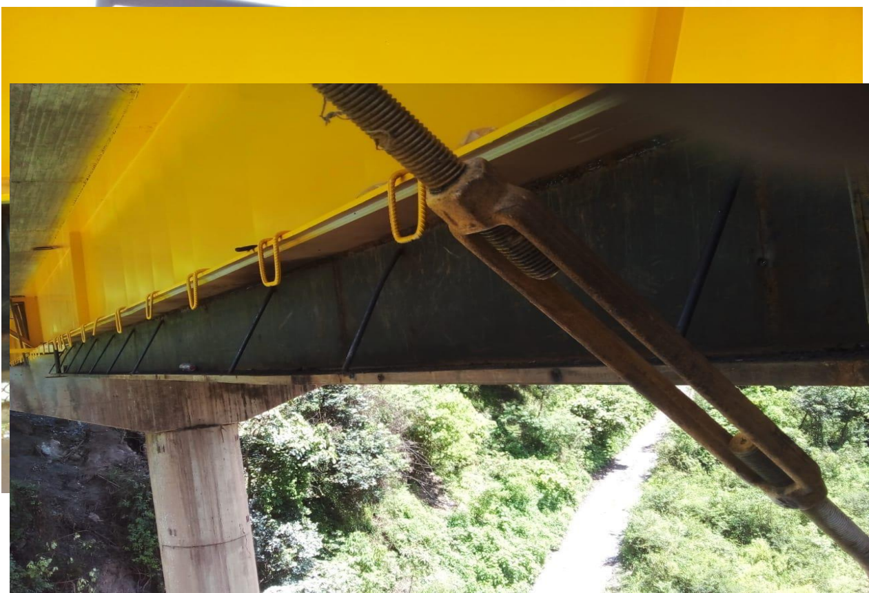
Imagen XXX. Autoría propia. Trabe de refuerzo ya soldada.
