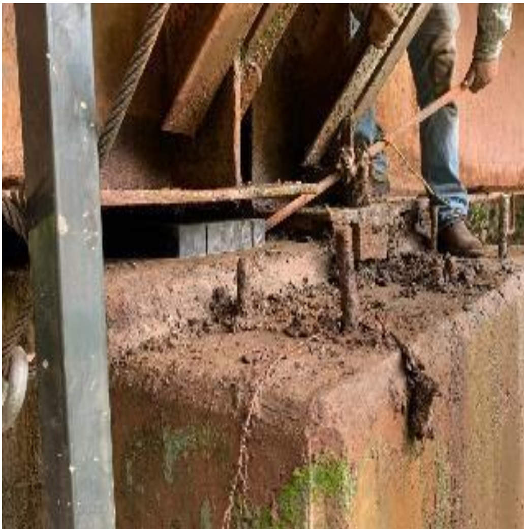
Figura LV. Autoría propia, Colocación de neoprenos nuevos.
