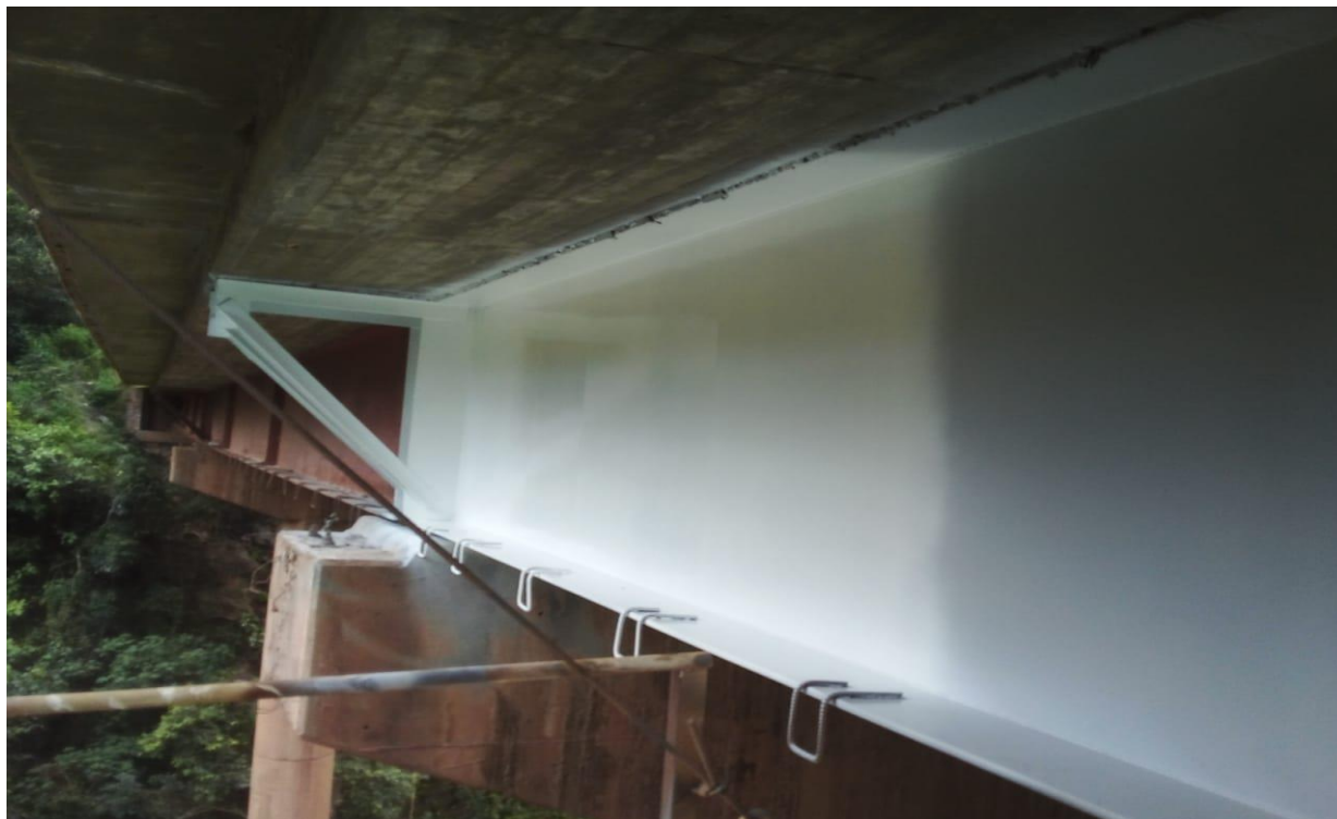
Imagen XXXVIII. Autoría propia. Aplicación de pintura blanca intermedio a trabe 2.
