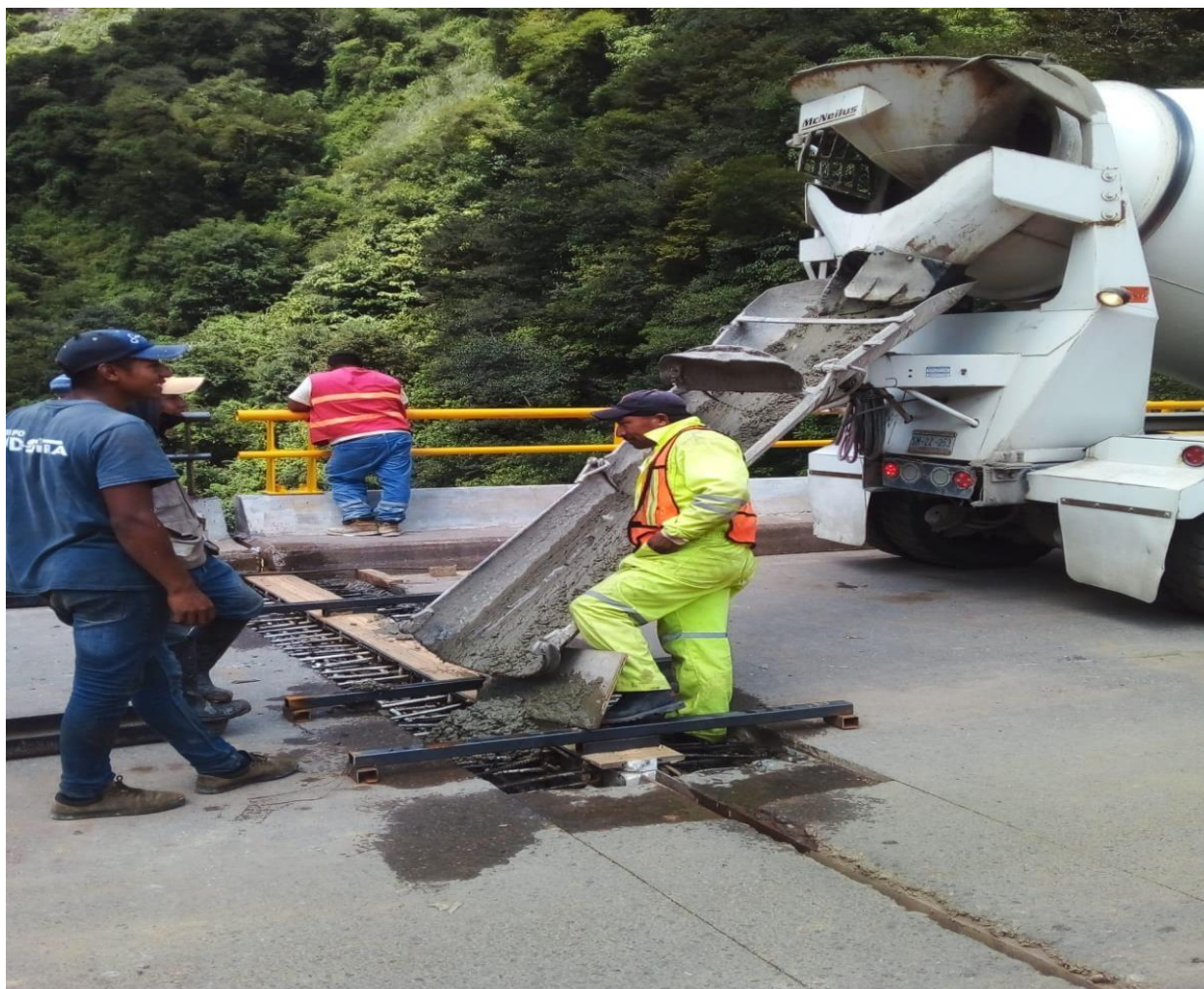
Figura LXVIII. Autoría propia. Colado con concreto premezclado F'c=300 \text{ kg/cm}^2 en juntas de dilatación.
