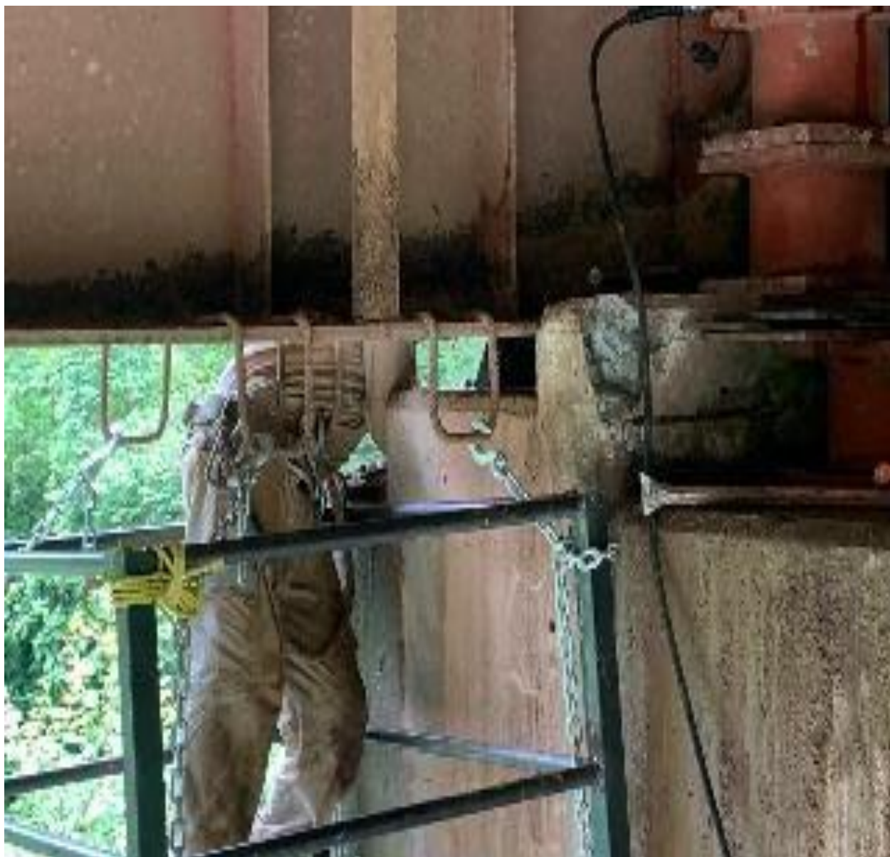
Figura LII. Autoría propia. Limpieza en área donde van los neoprenos.
