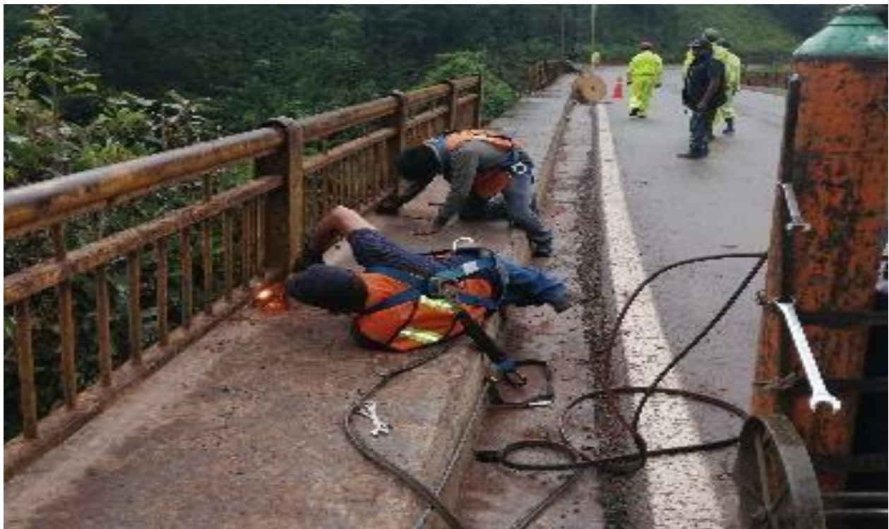
Imagen LVIII. Autoría propia. Desmantelamiento de barandal existente con equipo de oxicorte.
