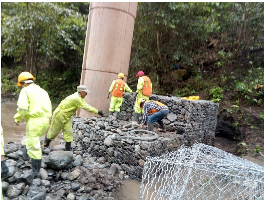
Figura XII. Autoría propia. Proceso constructivo de armado del muro gavión.
