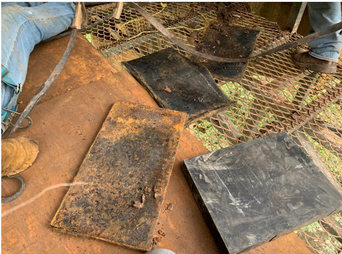
Figura LVI. Autoría propia. Placas de apoyo, neoprenos usados y neoprenos nuevos.
