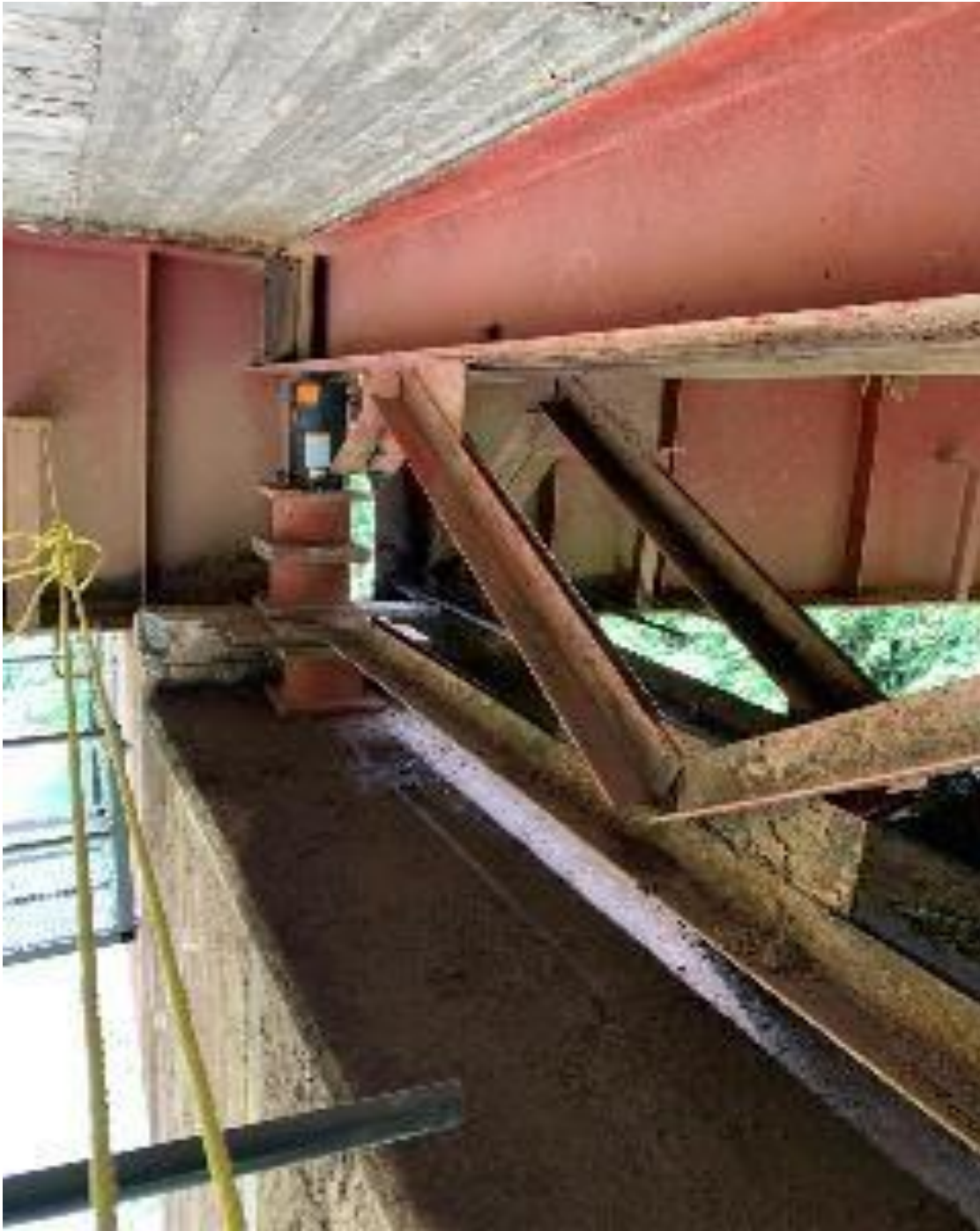
Figura L. Autoría propia. Colocación de bancos y gatos hidráulicos entre diafragma y columna.
