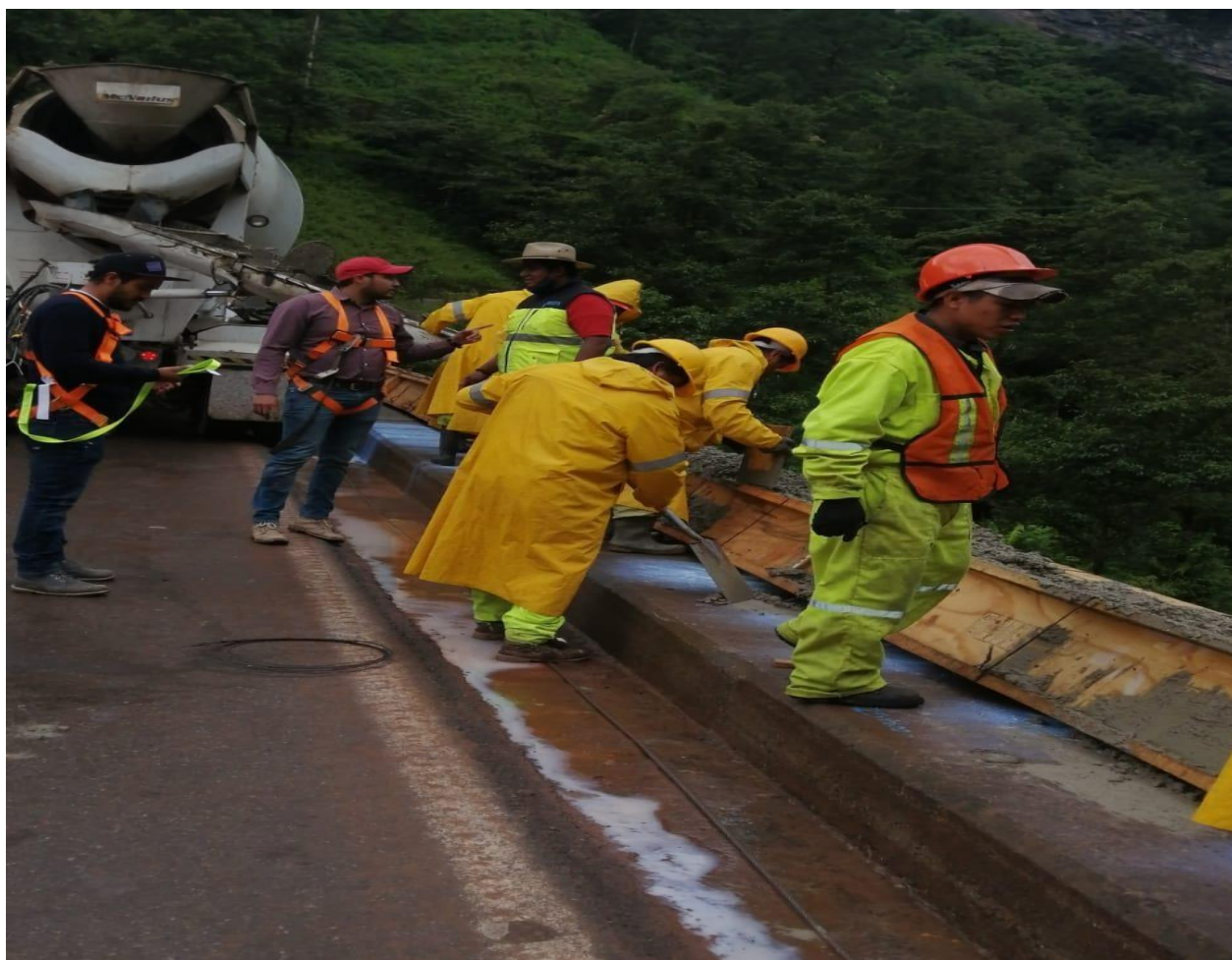
Figura LXI. Autoría propia. Colado de guarnición, con concreto premezclado F'_{\zeta}=250 \text{ kg/cm}^2 .
