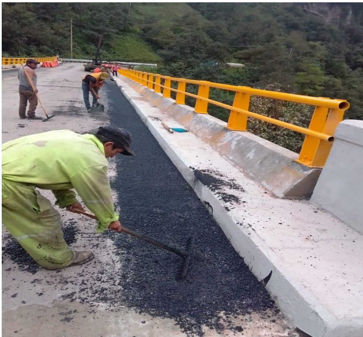
Figura LXXVIII. Autoría propia. Tendido de carpeta asfáltica para renivelar hombro derecho.
