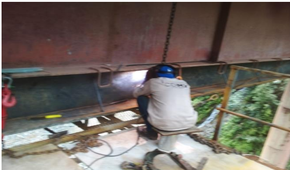
Figura XXII. Autoría propia Fabricación de traveses de refuerzo de acero A-36, transporte y soldadura en traveses existentes.
