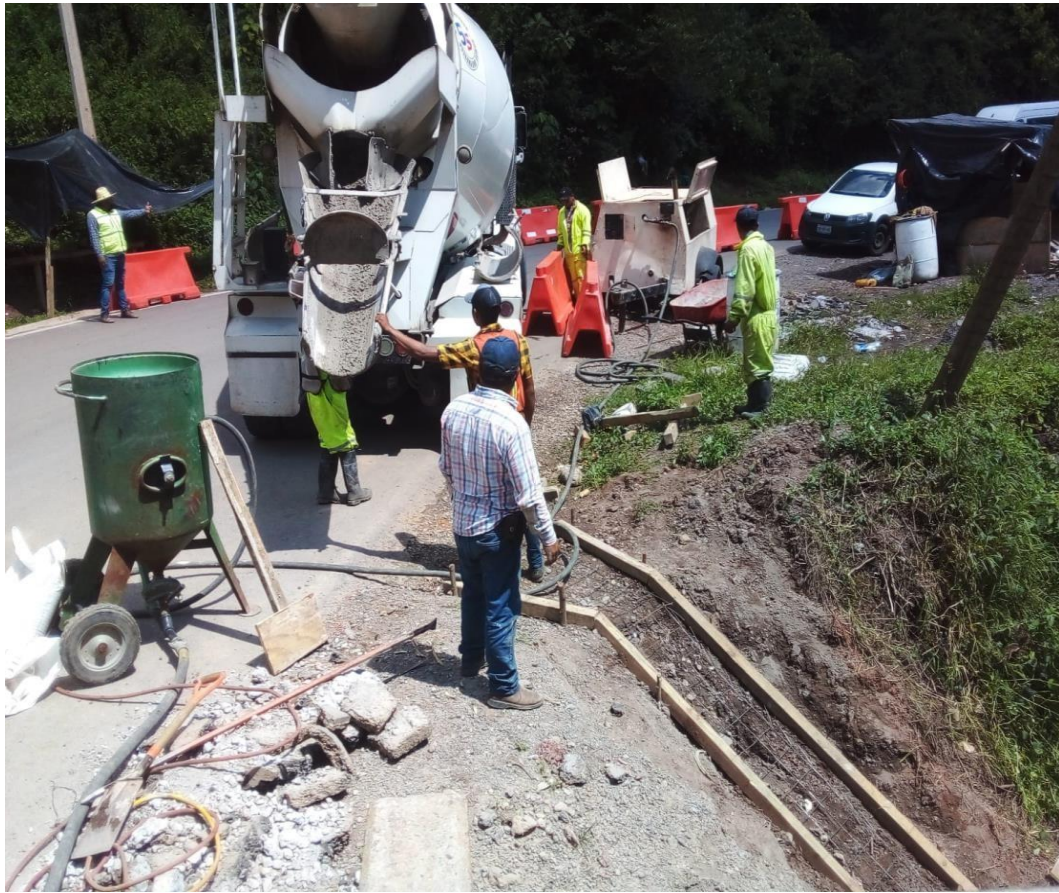
Figura XXXIII. Autoría propia. Se observa el equipo de sandblasteo y compresor instalado sobre la margen izquierda de la vialidad.
