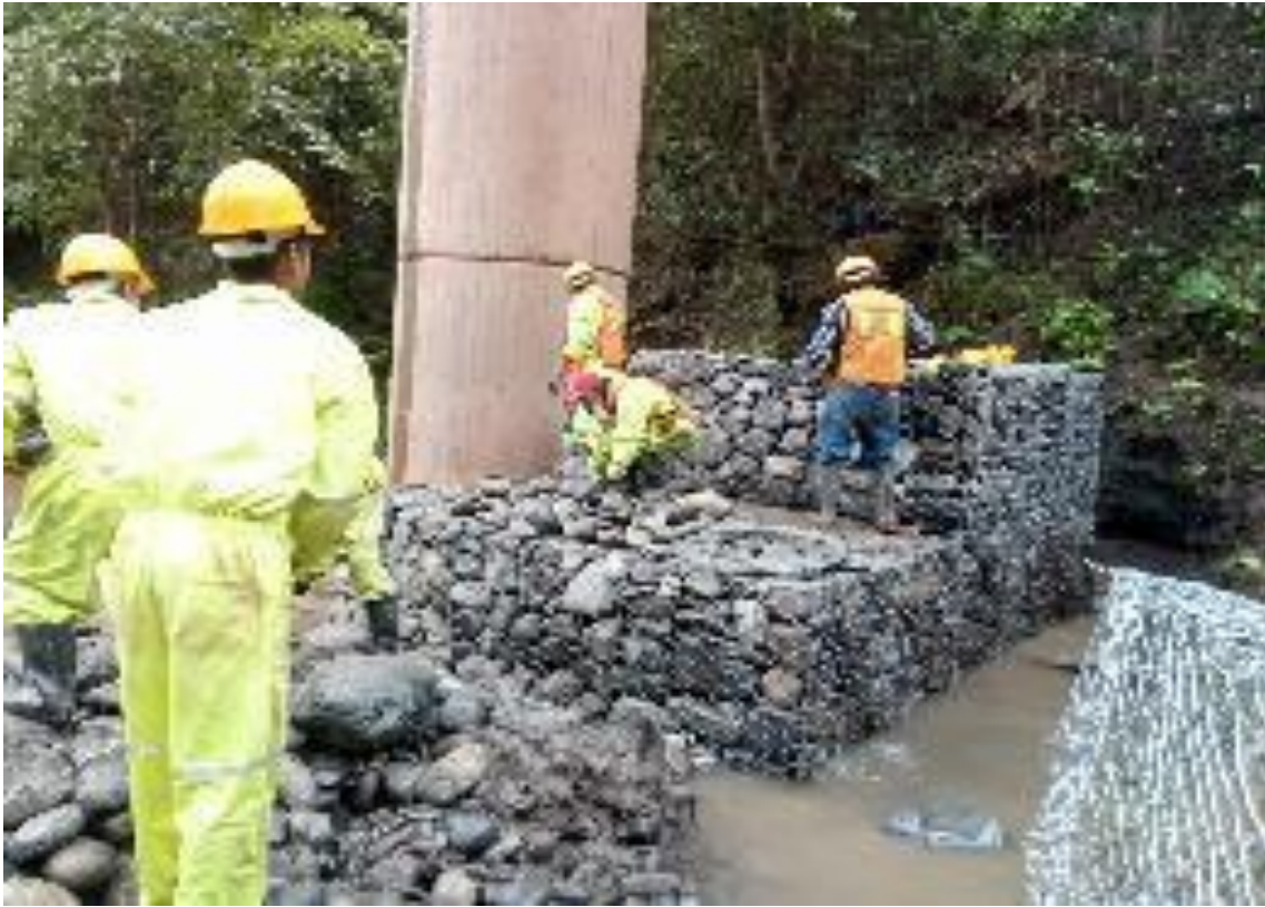
Figura XIV. Autoría propia. Proceso constructivo de armado del muro gavión.
