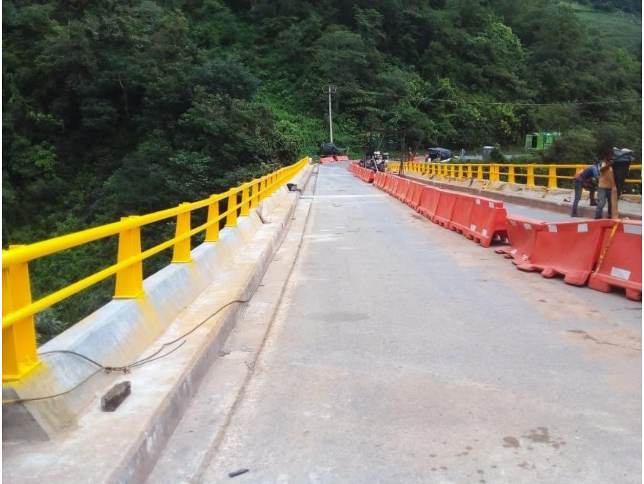
Figura LXIII. Autoría propia. Pintura de parapeto mixto de acuerdo con la normativa de la SCT.
