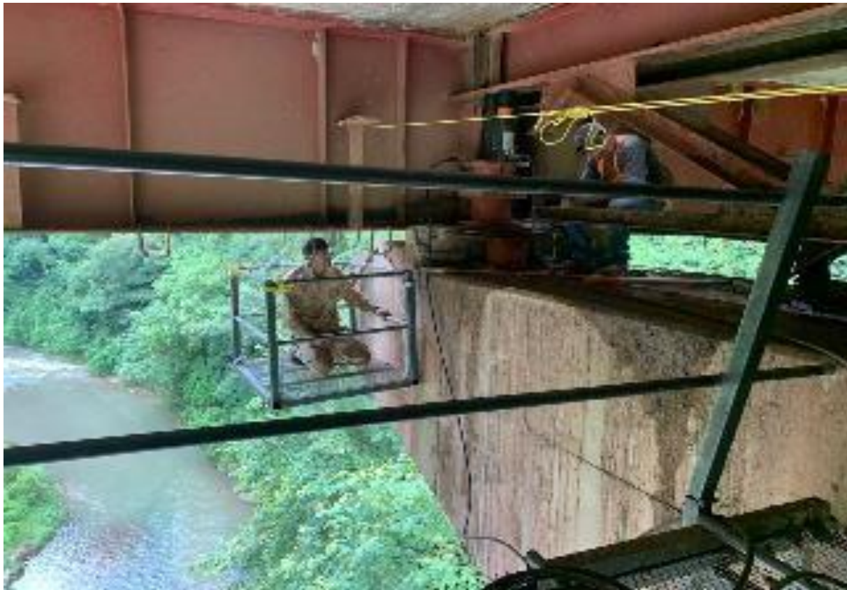
Figura VIII. Autoría propia. Checando Presiones y altura a la hora de levantar el claro 2.
