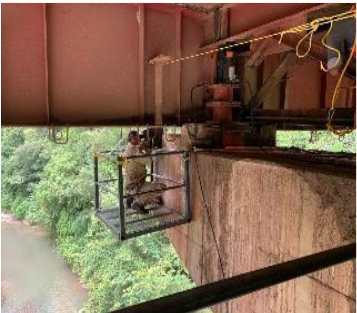
Figura LI. Autoría propia. Retiro de neoprenos existentes .
