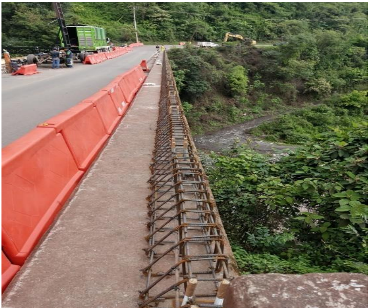
Figura LX. Autoría propia. Armado de acero con varilla de ½” para guarnición de concreto armado.
