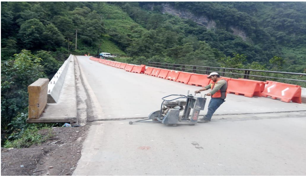
Figura XVII. Autoría propia. Corte con cortadora a la profundidad indicada para no dañar el acero.
