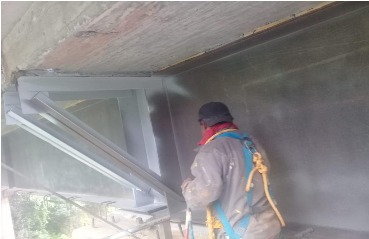
Imagen XXXV. Autoría Propia. Aplicación de primario inmediatamente después de sandlastear y limpieza de trabe.
