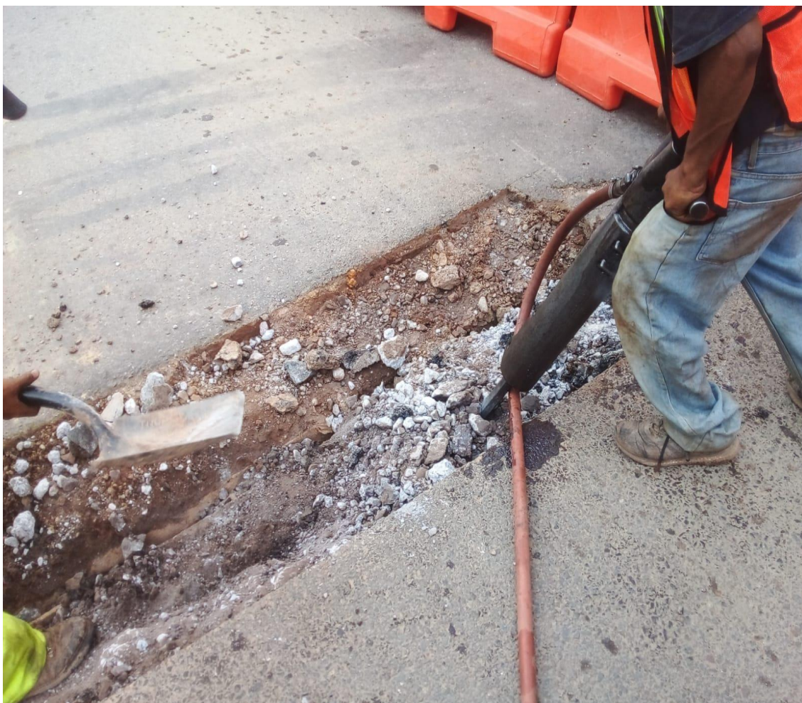
Figura XIX. Autoría propia. Demolición con equipo neumático para alojar las juntas de dilatación.
