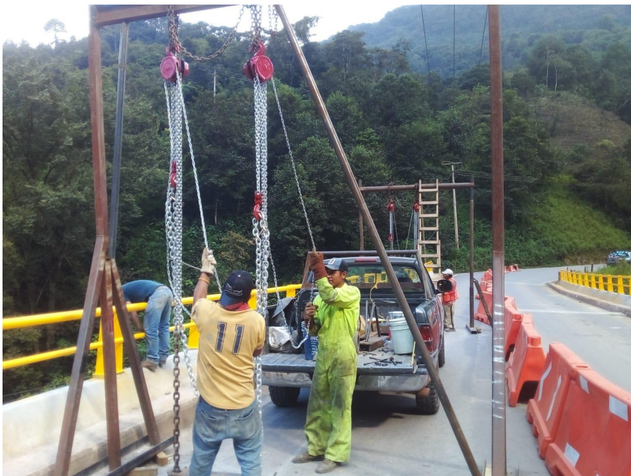
Imagen XXIX. Autoría propia. Izaje de trabe de refuerzo con sistema de polipastos de cadena con capacidad de 5 ton c/u.
