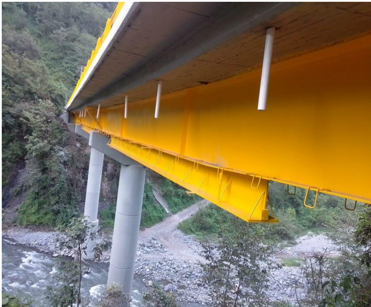
Imagen XLIII. Autoría propia. Vista panorámica de traveses existentes y traveses de refuerzo con pintura final.
