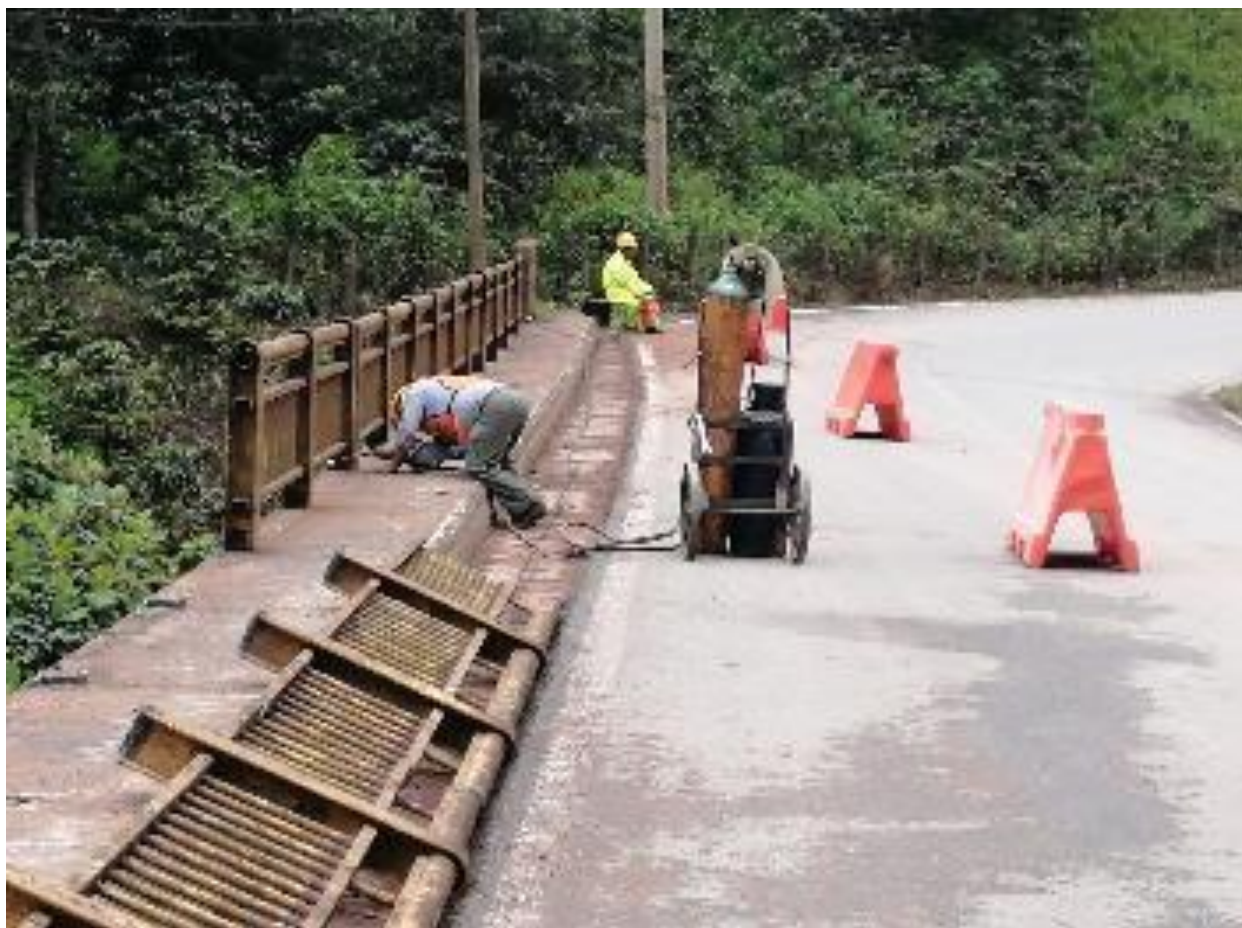
Figura LVIX. Autoría propia. Desmantelamiento de barandal existente con equipo de oxicorte.
