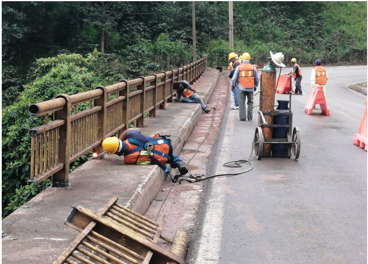
Figura XVIII. Autoría propia. Desmantelamiento del barandal existente.
