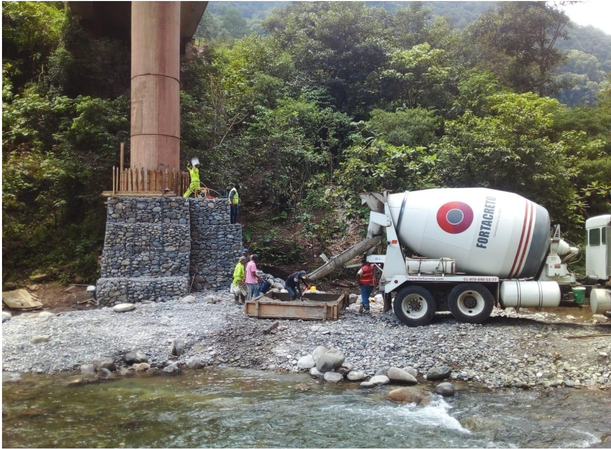
Figura XVI. Autoría propia. Colado del ensanchamiento de pila 3.
