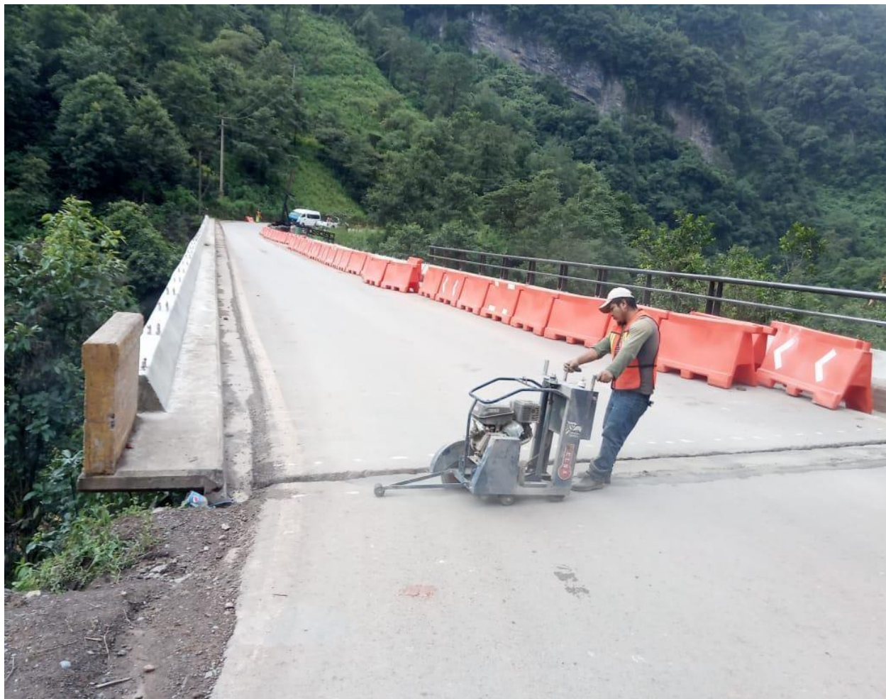
Figura LXV. Autoría propia. Corte con cortadora para retirar y demoler en el área de las juntas de dilatación.
