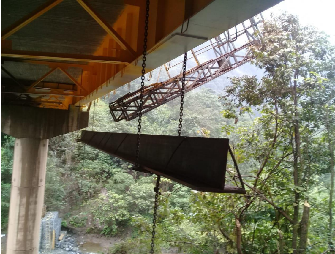
Figura XXIV. Autoría propia. Procedimiento de izaje de trabe de refuerzo en el 1er claro
