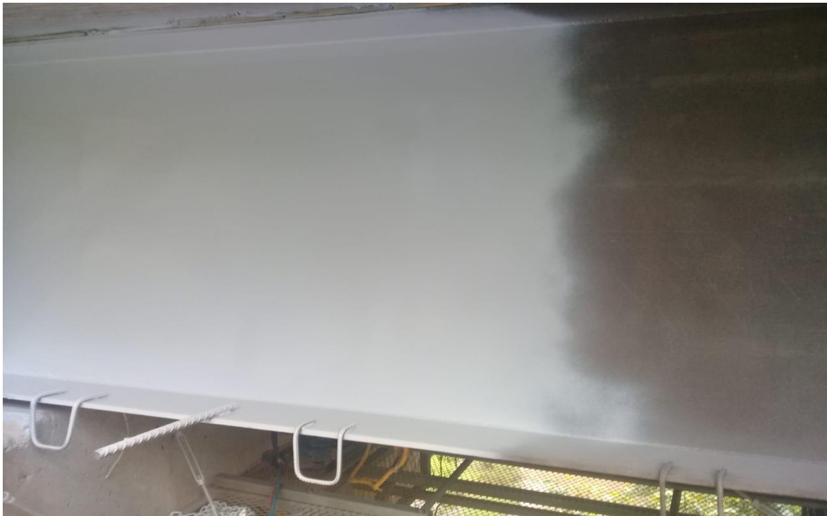
Imagen XXXVI. Autoría propia. Aplicación de Pintura primario color Gris, inmediatamente después del Sandblasteo .
