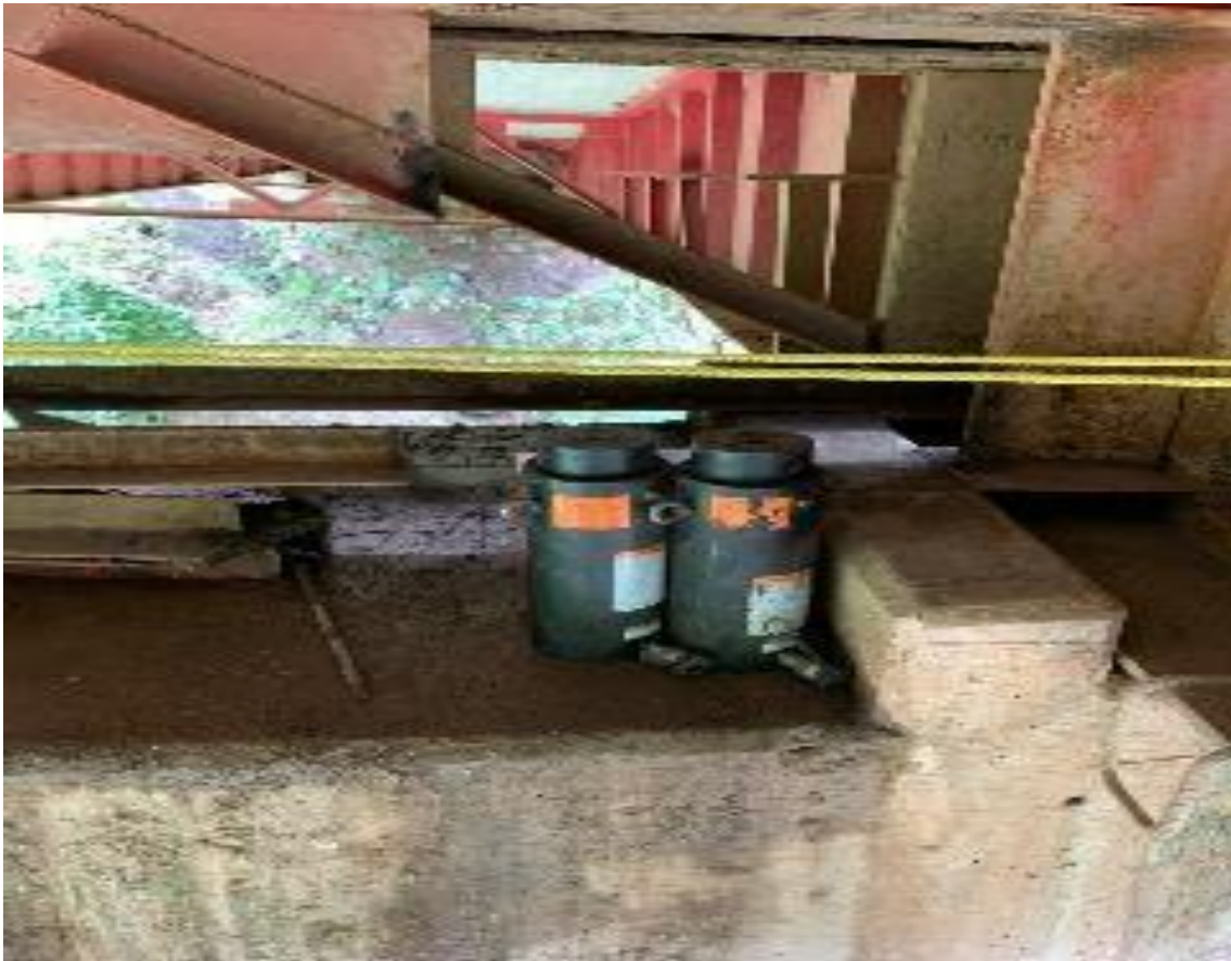
Figura XLVII. Autoría propia. Corte de diafragma y reforzamiento para alojar gatos hidráulicos.
