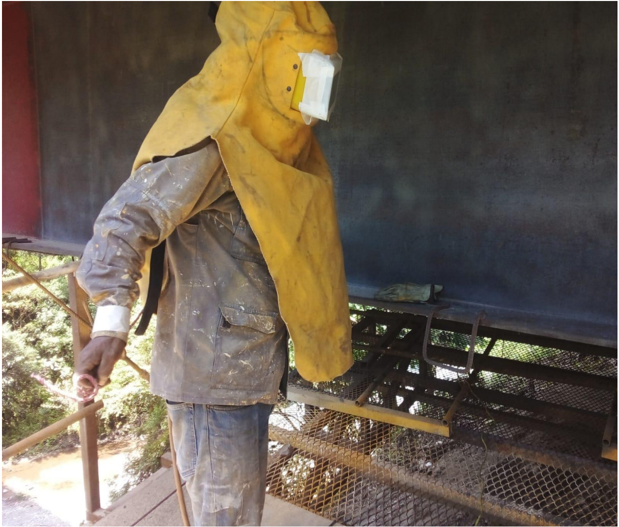
Imagen XXXI. Autoría propia. Sandblasteo de trabes existentes.
