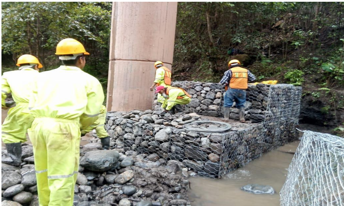
Figura XI. Autoría propia. Proceso del armado y llenado del muro gavión.
