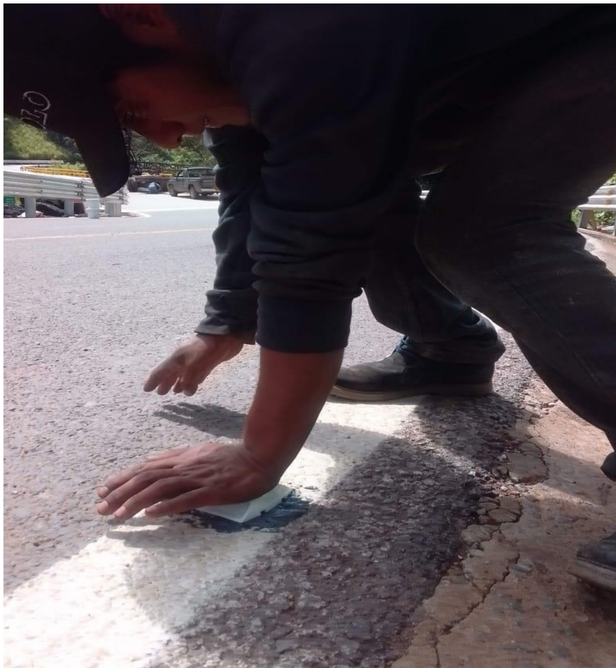
Figura LXXXIV. Autoría propia. Colocación de vialetas blancas con epóxico.
