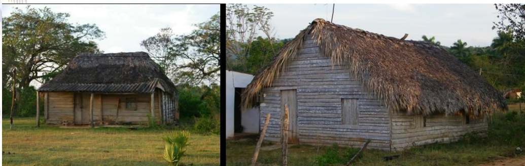
Imagen 24: Tipología constructiva tradicional predominante en el asentamiento La Cantera. Por: Tomadas por el Dr. C. Arq. Gerson Herrera Pupo
