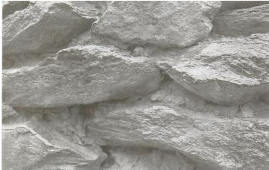
Figura 1.1 Detalle de junteo de mampostería a base de rocas no labradas y mortero de arcilla y agua. (Gallegos & Casabonne, 2005).
