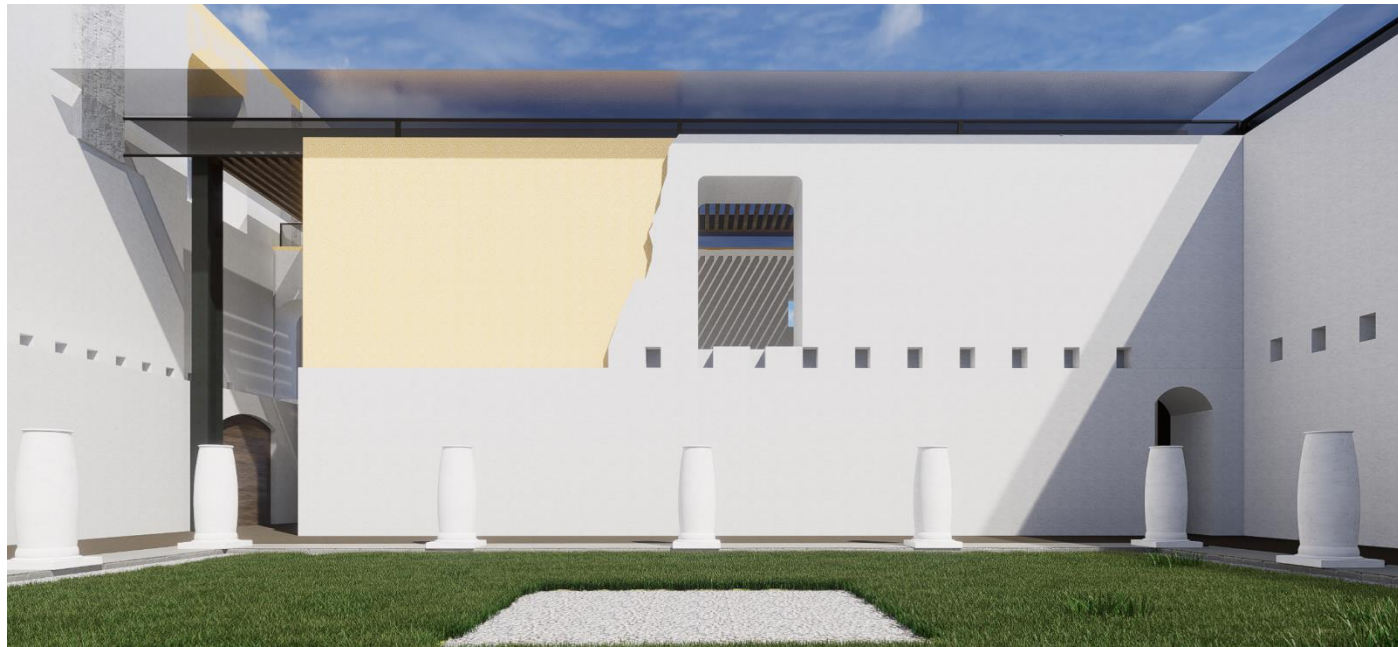
Figura 122. Panda poniente del claustro, se aprecia la estructura de la cubierta en esta área, así como el coronamiento de muros con materiales diferentes al original, para diferenciar la intervención. (Recuperado de Solana, 2024)
