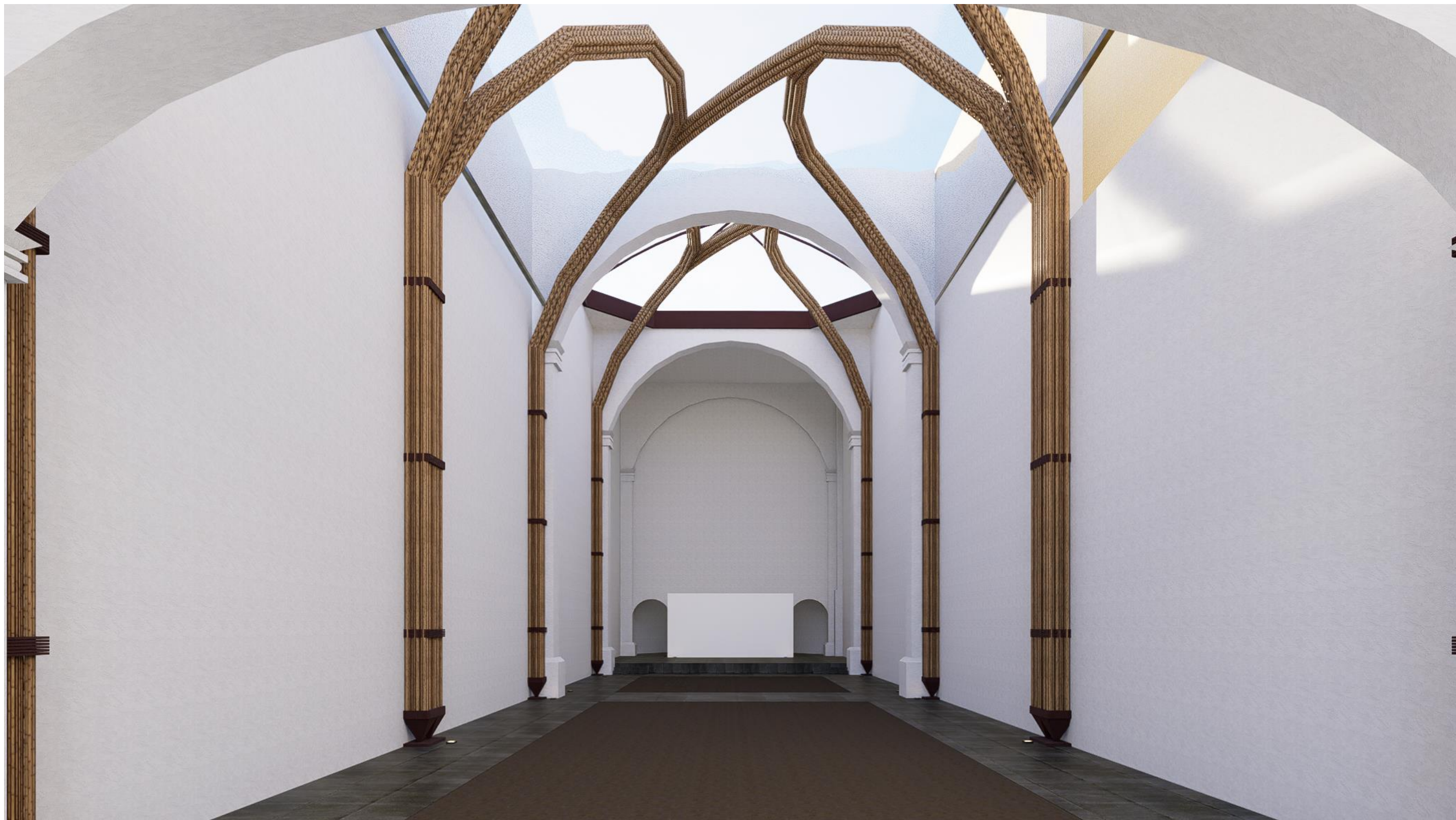
Figura 128. Vista general de la nave del templo, se aprecia la amplitud del área propuesta para gran salón de usos múltiples y auditorio, así como exposiciones temporales o de gran escala. Se aprecia una visión general de la estructura de bambú, donde sus líneas nos evocan la ligereza de una bóveda de crucería, el paso de la luz es abundante, así mismo en la parte de la cúpula se aprecia la elevación de la estructura, al fondo, el estrado o escenario, realizado con una tarima. (Recuperado de Solana, 2024).
