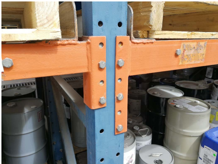
Figura 7. Conexión central asimétrica (fotografía tomada en sitio de análisis).
