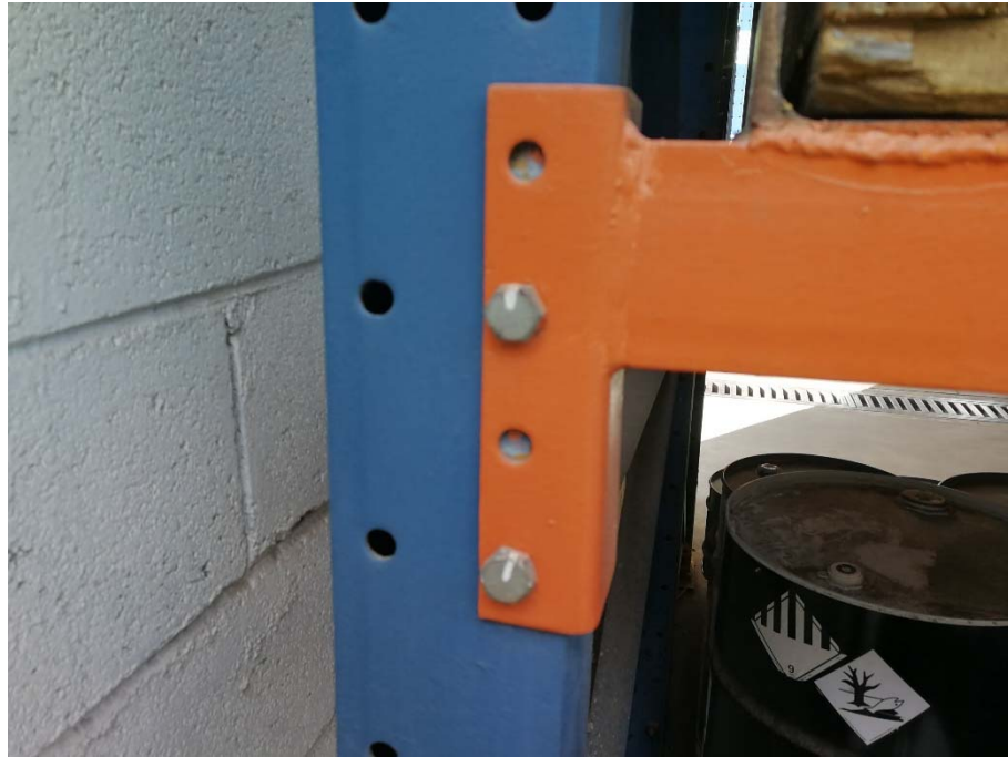
Figura 8. Conexión estándar de extremo (fotografía tomada en sitio de análisis).
