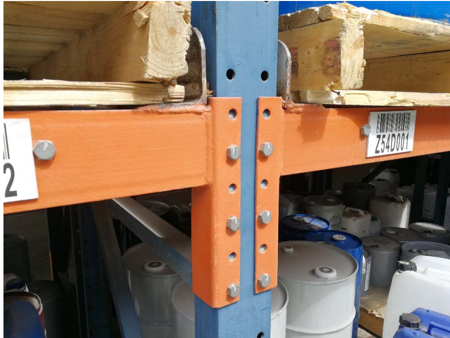
Figura 6. Conexión central simétrica (fotografía tomada en sitio de análisis)
