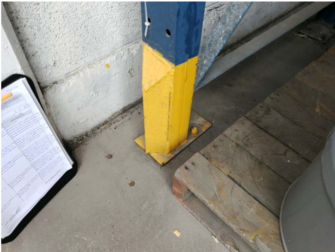
Figura 11. Conexión a piso con 2 tornillos No adosada (fotografía tomada en sitio de análisis).
