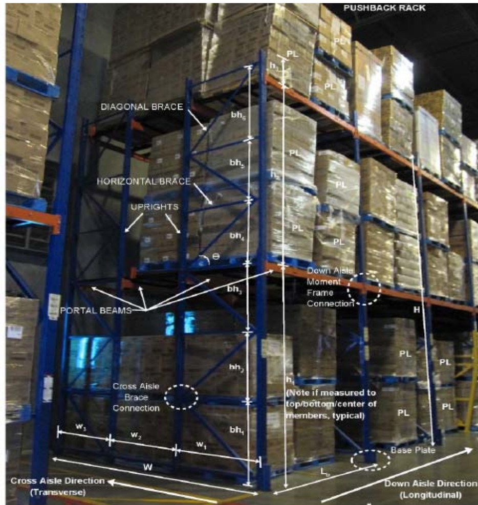
Figura 1. Rack e identificación de elementos, [fotografía P&G] (Standard Operating Procedure , 2015)
