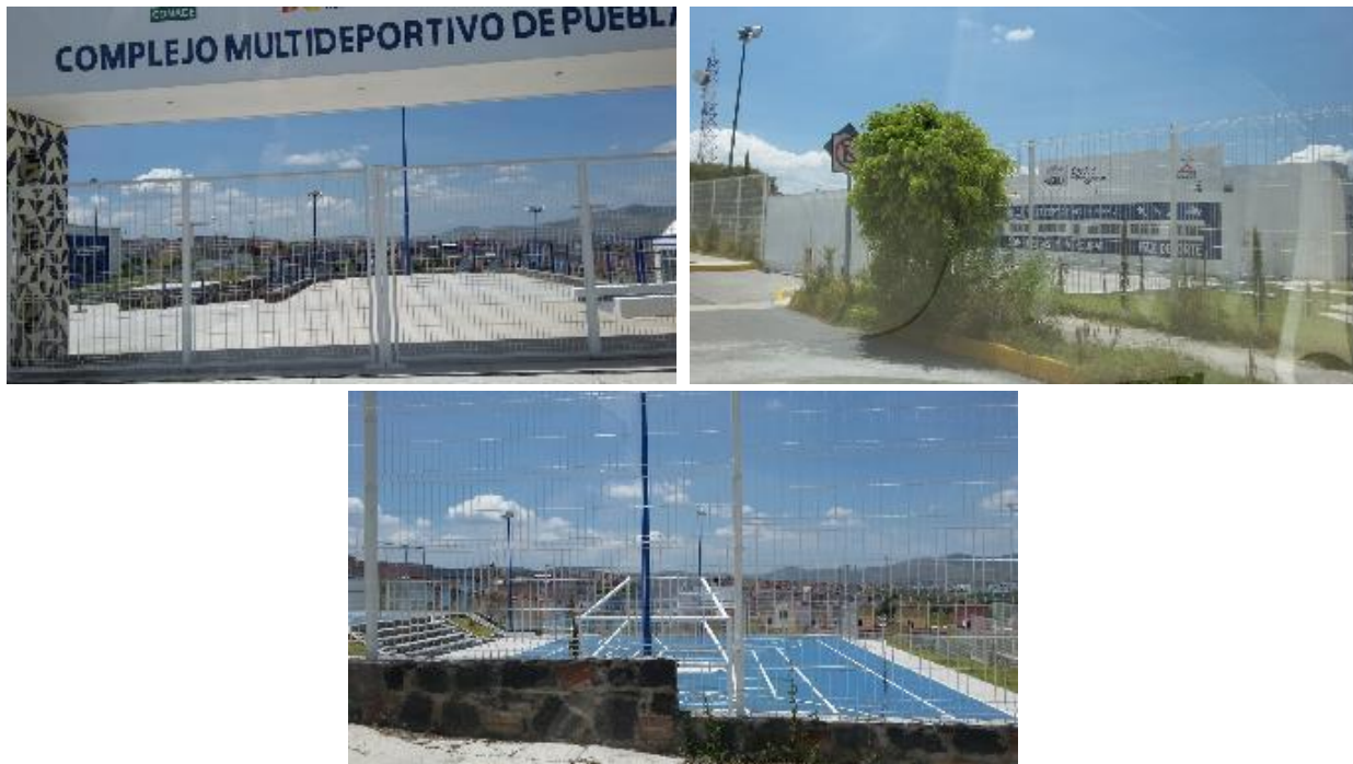
Fig. 31, 32 y 33.- Vista de las instalaciones del Complejo Multideportivo SC
