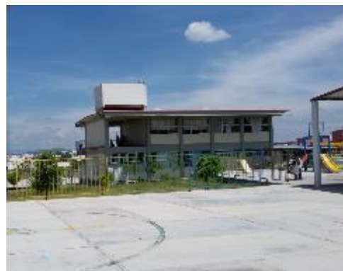
Fig. 38.- Instalaciones Primaria y Secundaria
