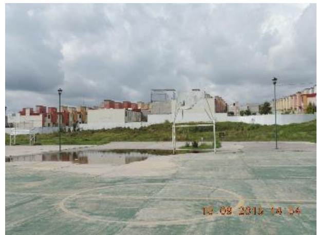
Fig.43.- Instalaciones del parque
