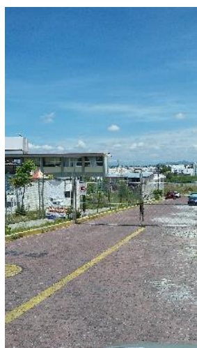
Fig. 35- Vista del cierre de la calle con malla ciclónica
