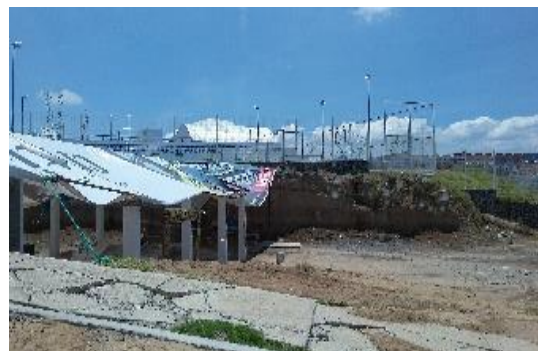
Fig. 30 Construcciones precarias para misas dominicales
