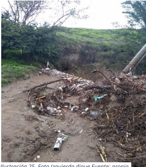
Ilustración 25. Foto Izquierda dique Fuente: propia
