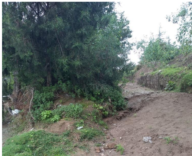
Ilustración 28. Foto Canal de derivación Fuente: propia
