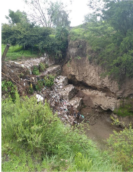
Ilustración 29. Dique y aguas abajo Fuente: propia
