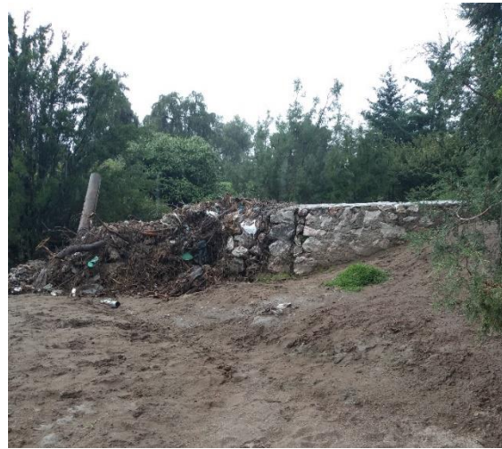
Ilustración 26. Foto Izquierda dique Fuente: propia
