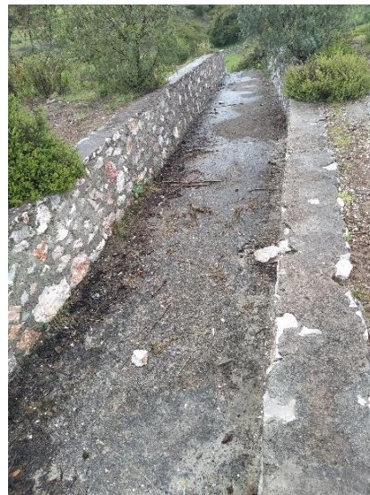
Ilustración 33. Foto 2, vertedor de excedencias
