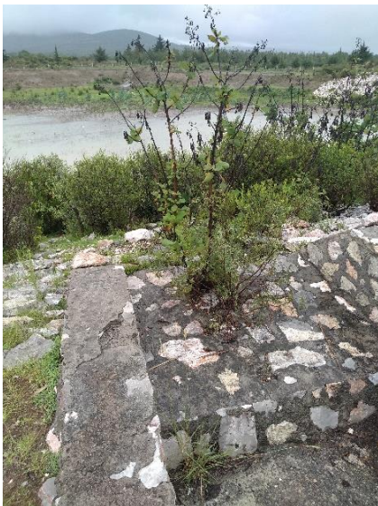
Ilustración 32. Foto1, vertedor de excedencias
