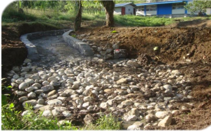
Ilustración 3. Vertedor de excedencias Fuente: Diseño y construcción de jagüeyes SAGARPA
