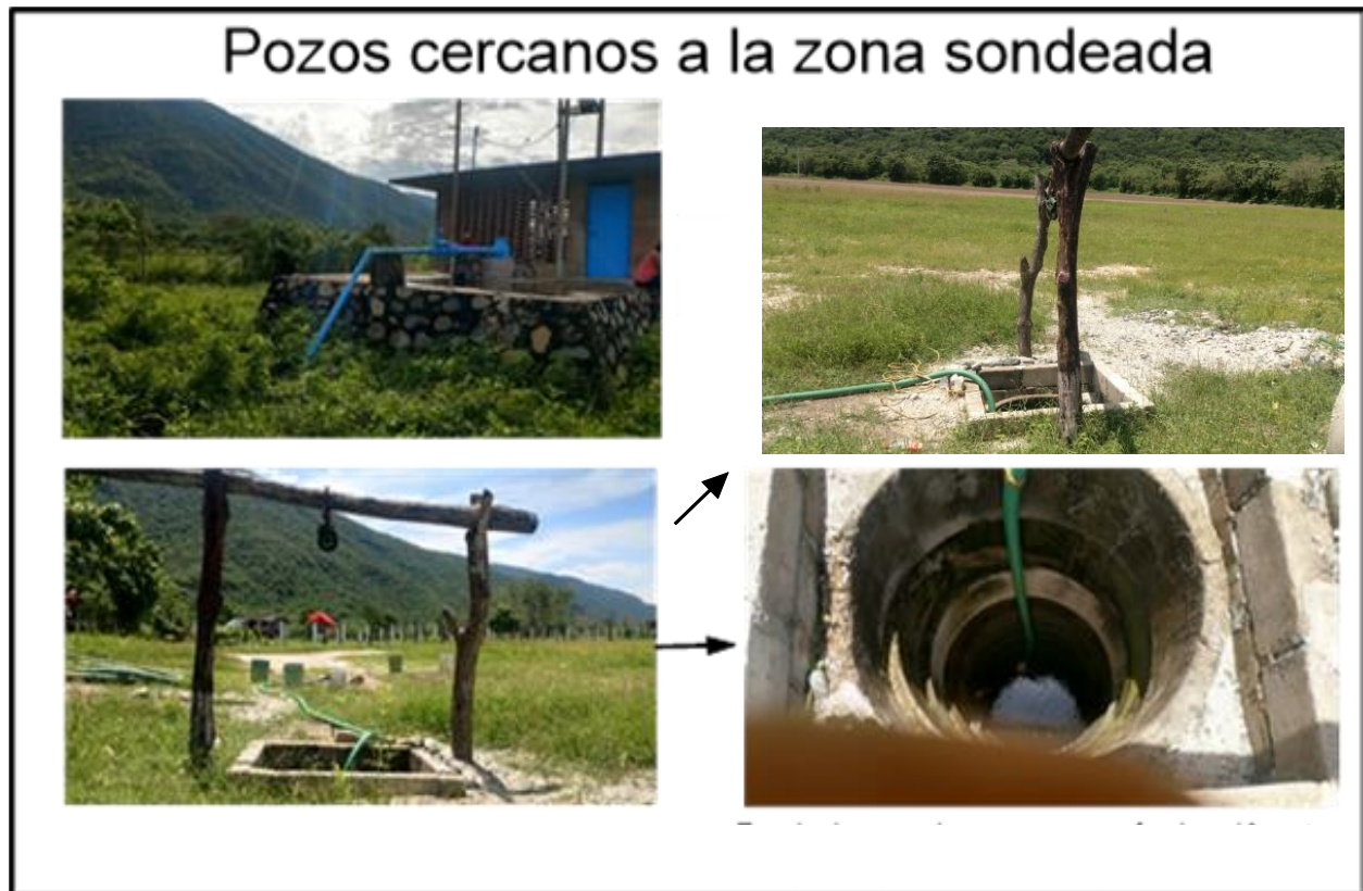
Figura 1.- Imágenes de los pozos cercanos a los puntos donde se realizaron los SEV's, El superior tiene una profundidad de 35 metros, y se observa un espejo de agua a 6 metros).
