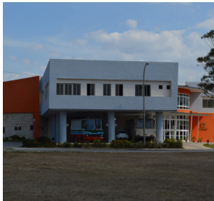
Figura 64. Televisión Camagüey, telecentro de la provincia de igual nombre. Fotografía de María de la Luz Carmona Romero, Ciudad de Camagüey (2017).
