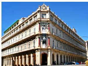
Figura 55. Hotel Plaza, ubicado en la Habana Vieja Cuba. Recuperado de: https://www.cubanos.guru/cosas-no-sabias-del-historico-hotel-plaza/
