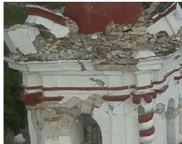
Imagen 1: Detalle del estado actual del tercer cuerpo de torre fachada poniente
