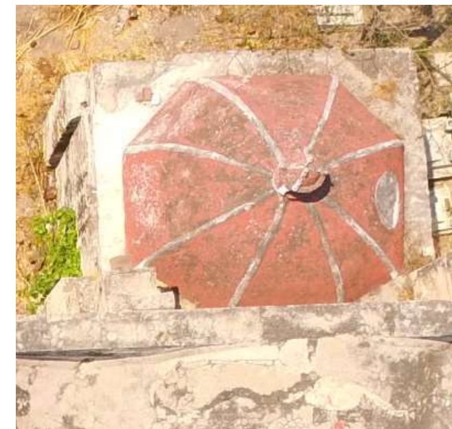
Imagen 2. Vista de azotea de cúpula de baptisterio
