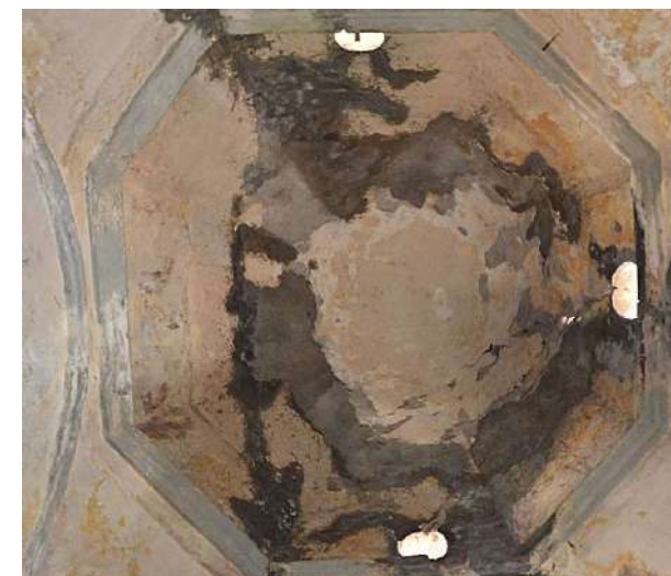
Imagen 3. Vista interior de cúpula de baptisterio
