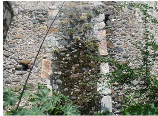
Imagen 1: Vista frontal del primer cuerpo de contrafuerte de Eje 5
