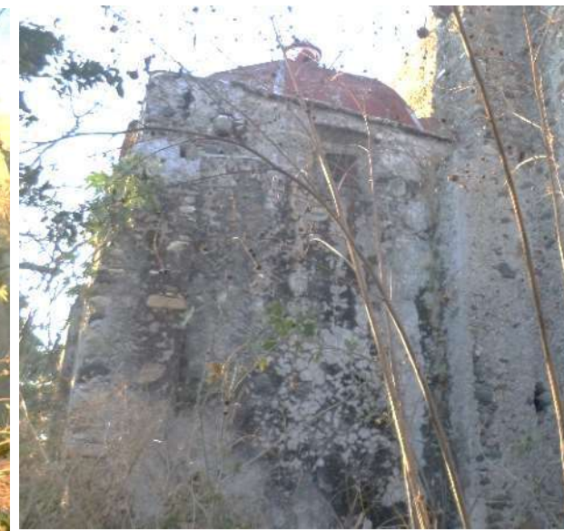
Imagen 4: Muro exterior oriente de Baptisterio
