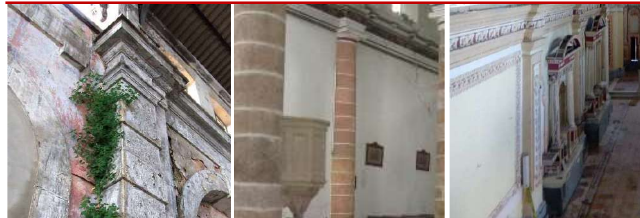
Columnas compuestas por diferente fábrica
