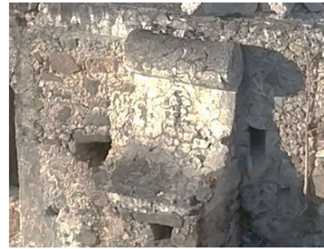
Imagen 2: Detalle de remate de contrafuerte de Eje 4
