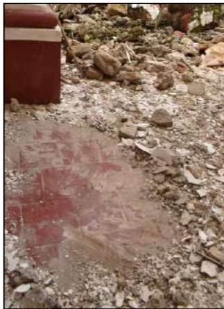
F01. Acabado del piso en Presbiterio
