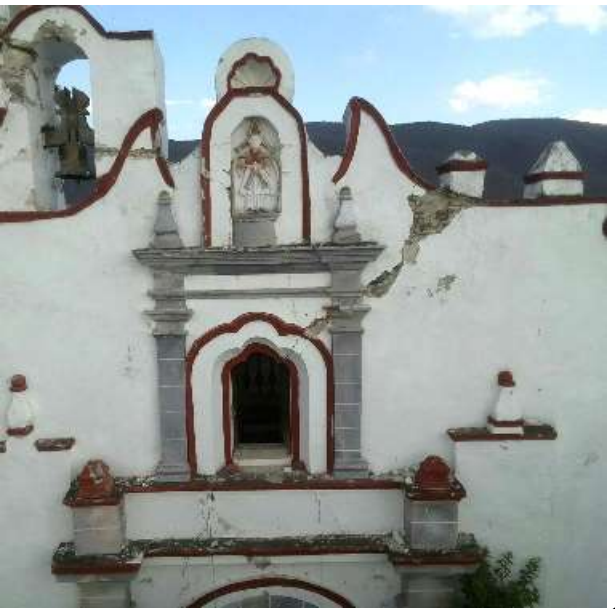
Imagen 4: Muro de fachada Poniente
