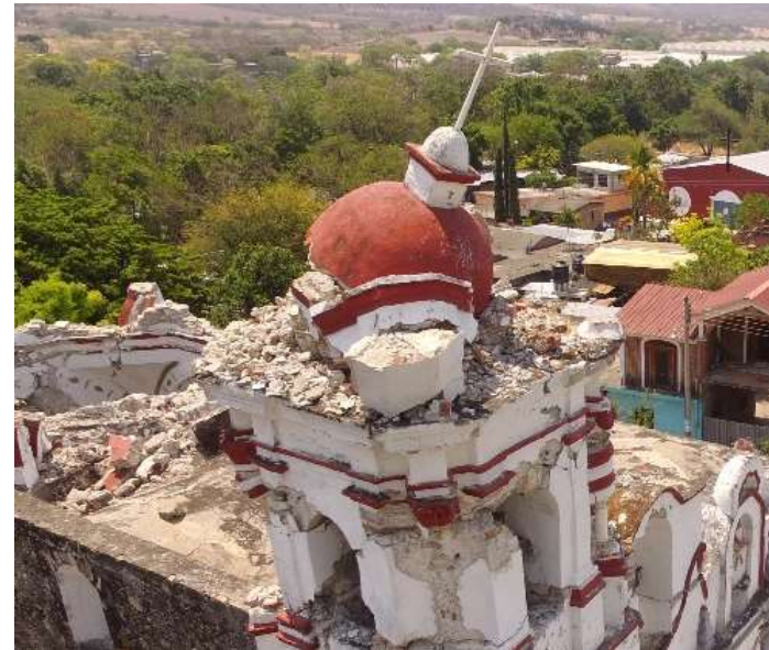
Imagen 1. Vista exterior norponiente de cúpula de torre campanario
