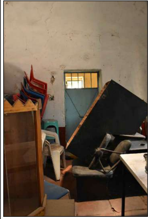
F01. Vista de muro interior norte de Bodega 1
