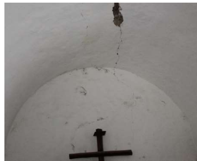
Imagen 2. Vista interior de la bóveda de sacristía
