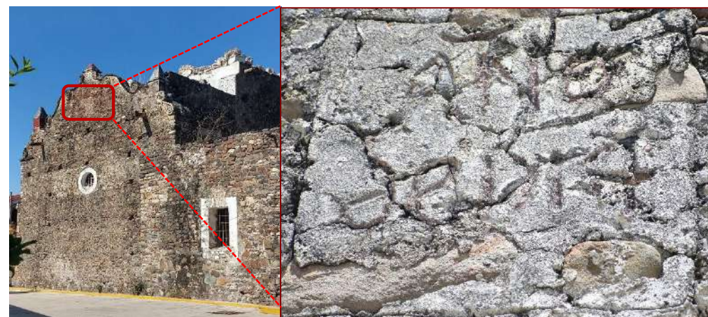
Imagen. 26. Inscripción hecha en una capa de mortero sobre la parte alta del muro de la fachada oriente, se encuentra en mal estado y es algo confusa la interpretación.
