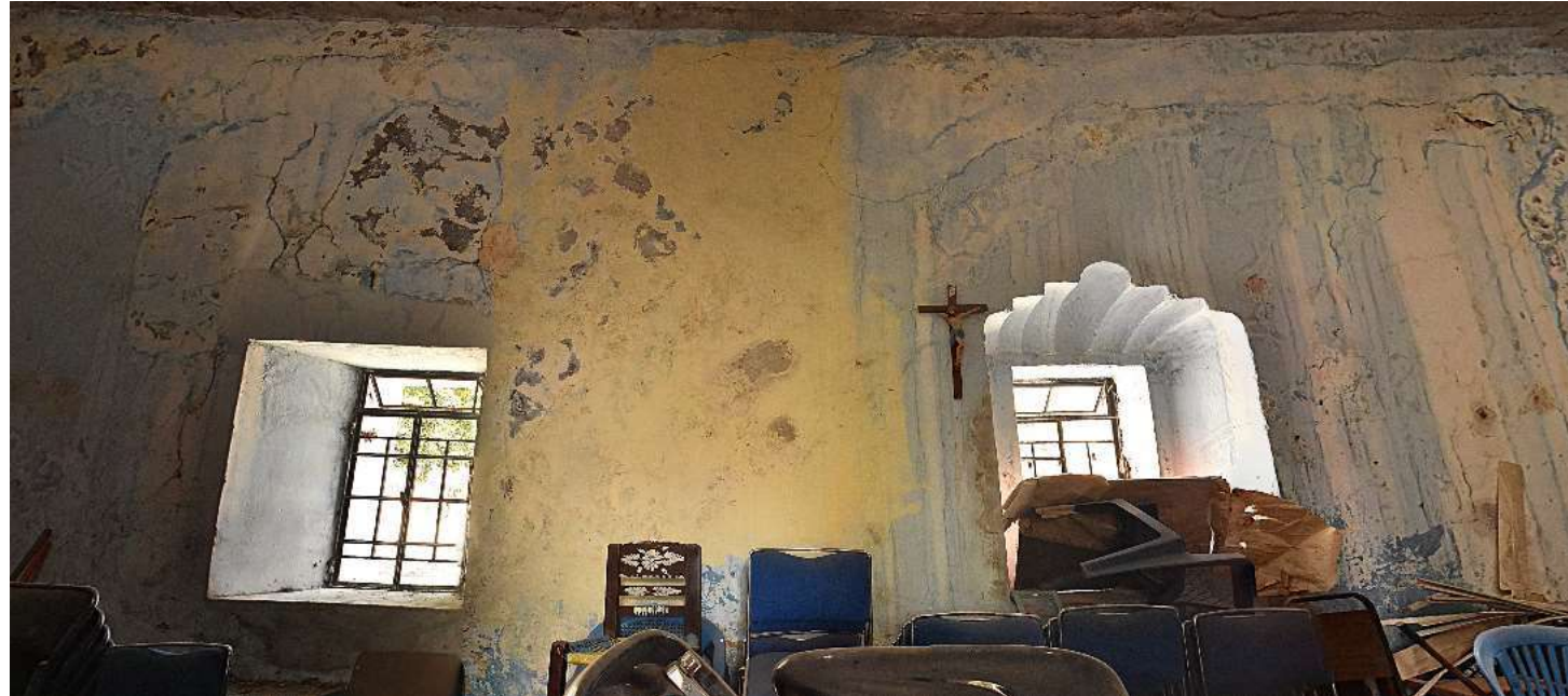
Imagen 1: Vista general del muro interior oriente
