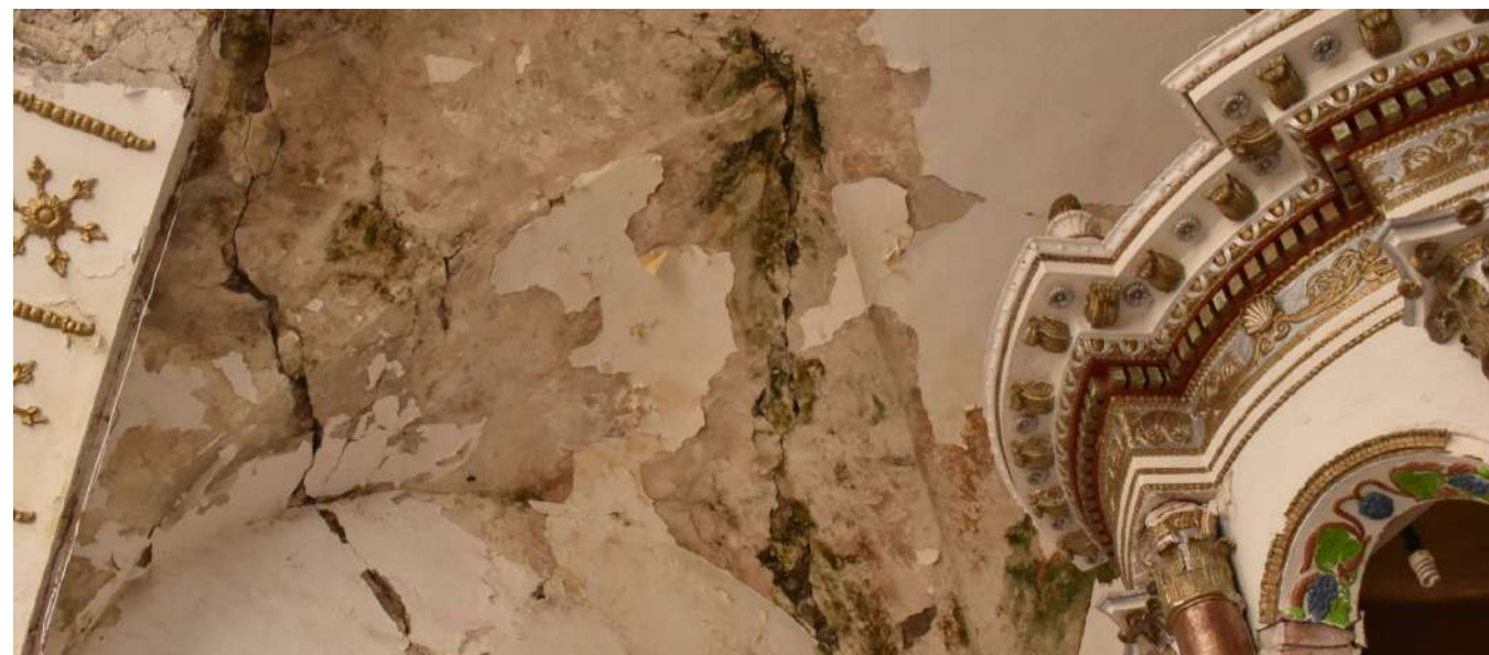
Imagen 1: Vista del intradós de cubierta
