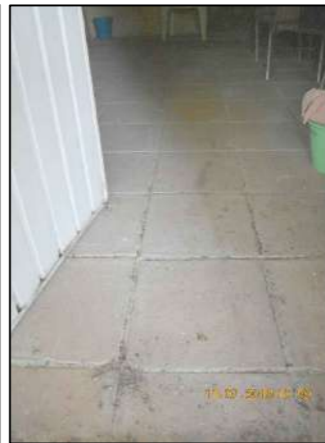
F04. Acabado de piso en Anexo 2
