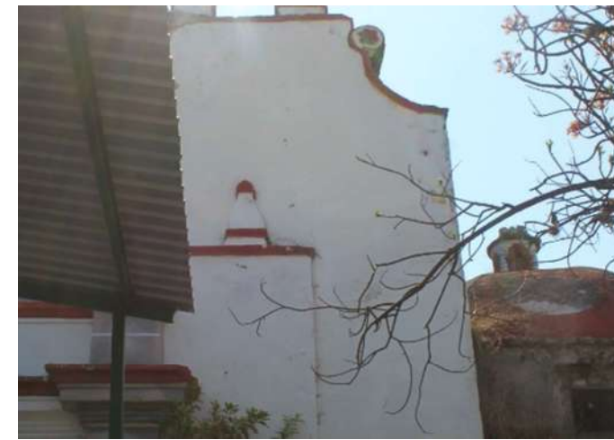
Imagen 2: Fachada Poniente de contrafuerte de Eje 1
