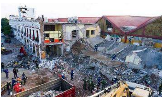
Imagen 5. Daños del Sismo de México (2017) Fuente: espanol.images.search.yahoo.com/
