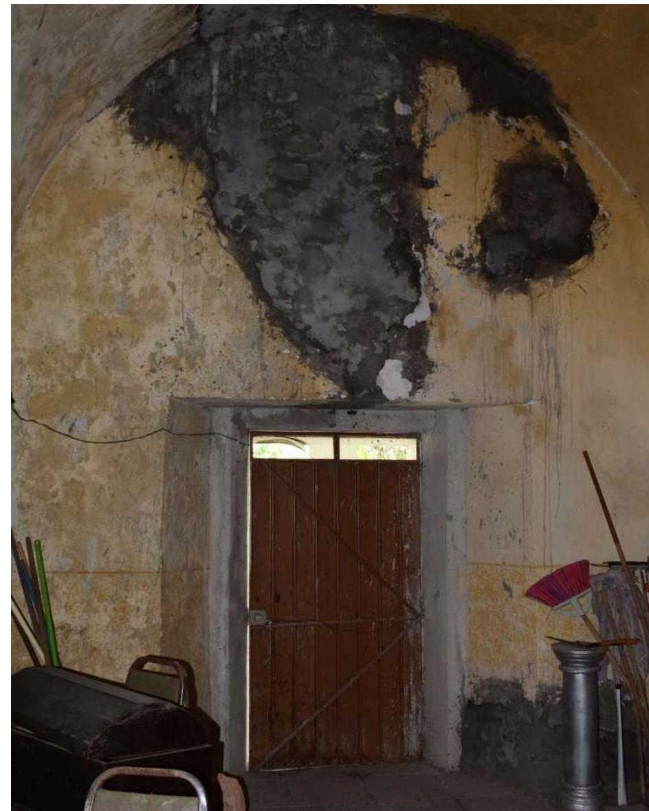
Imagen 1: Vista general del muro interior norte
