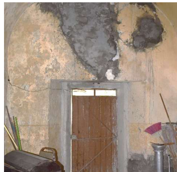
Imagen 3: Muro interior Norte de Anexo 2
