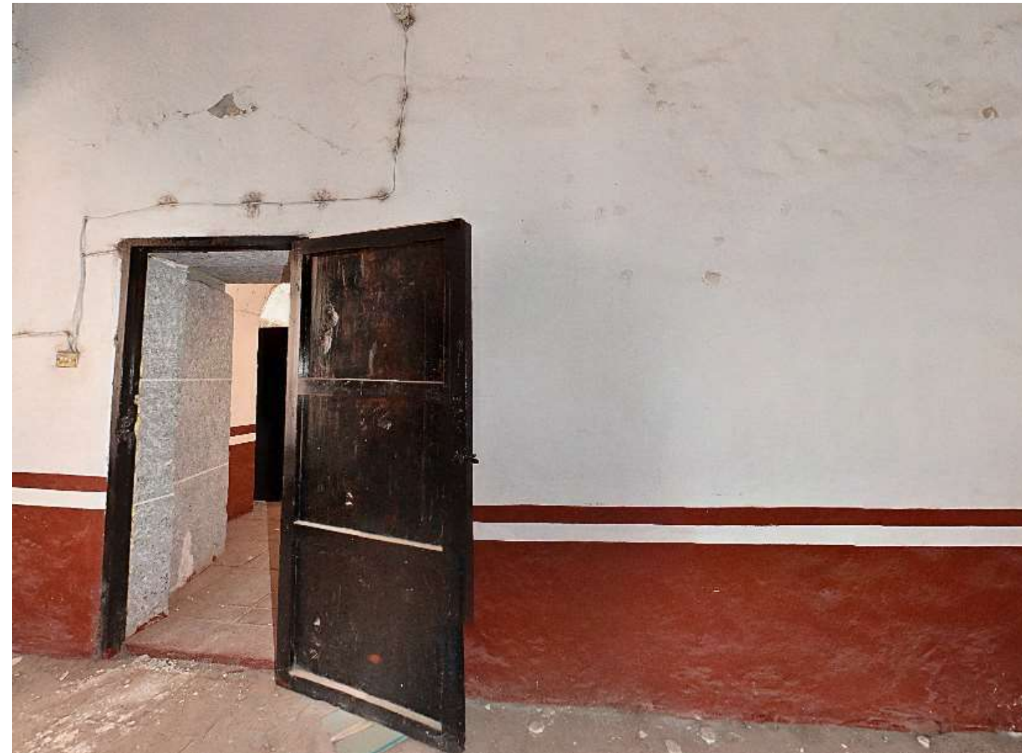
Imagen 1: Vista general del muro interior poniente
