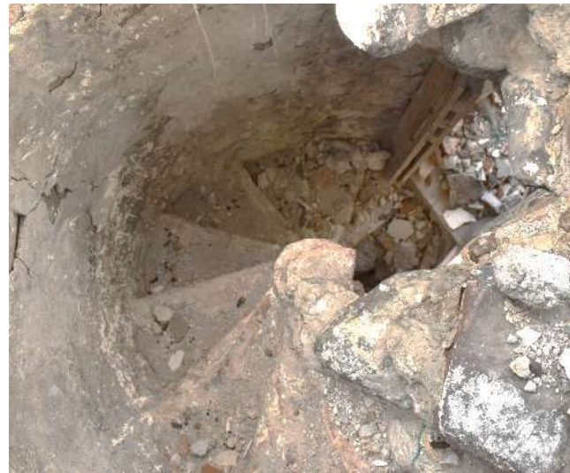
Imagen 3: Vista de desembarque de escalera helicoidal interior de torre
