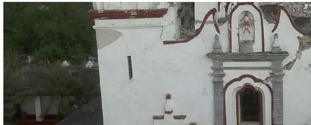
Imagen 2: Detalle del estado actual del primer cuerpo parte alta de torre campanario exterior poniente
