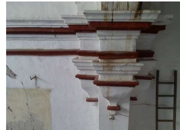
Imagen 2: Vista frontal de capitel de pilastra surponiente
