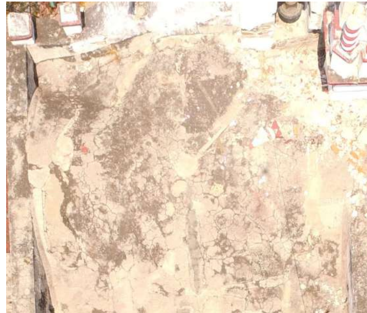
Imagen 1: Vista general área del extradós de Coro
