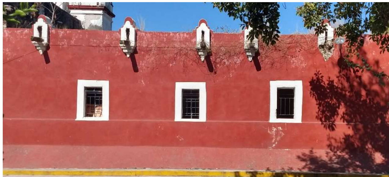
Imagen 2: Muro exterior oriente de bodega 1 y 2
