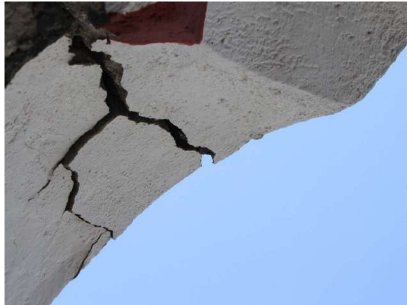
Imagen 3: Vista de intradós de arco de vano en ventana coral
