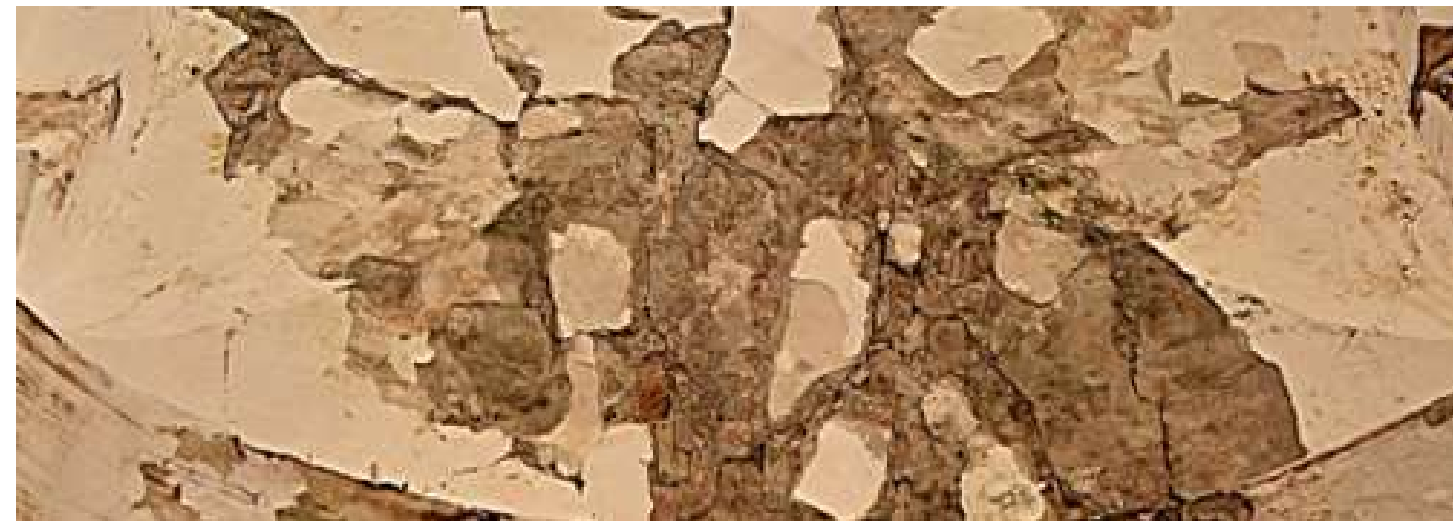
Imagen 1: Vista de intradós de cubierta
