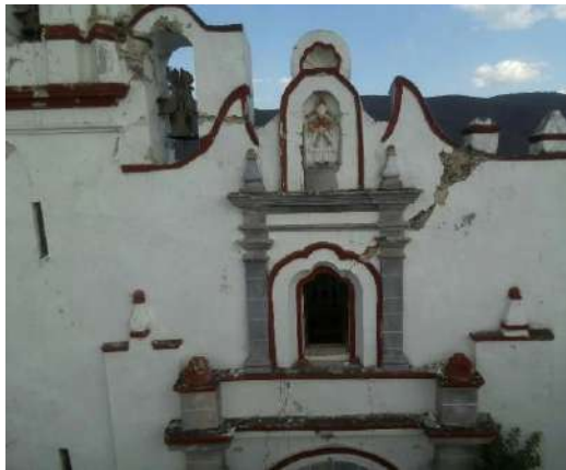
Imagen 17. Vista parcial de la fachada principal del templo de San Agustín Obispo Fuente: Sánchez Paulino
