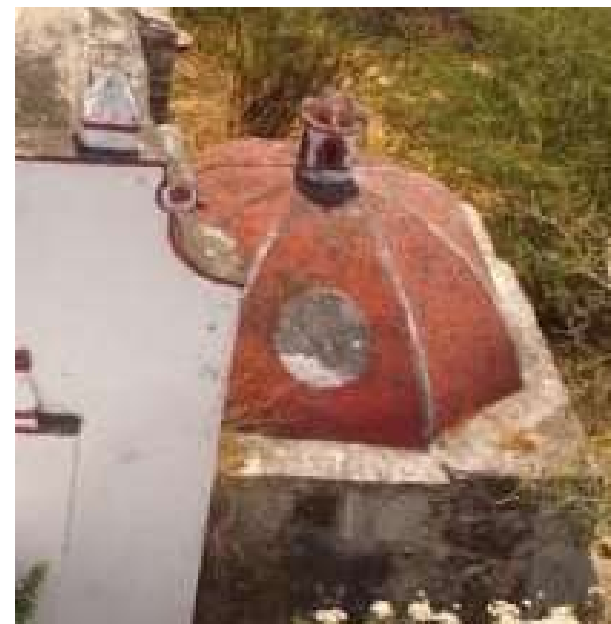
Imagen 1. Vista exterior poniente de cúpula de baptisterio
