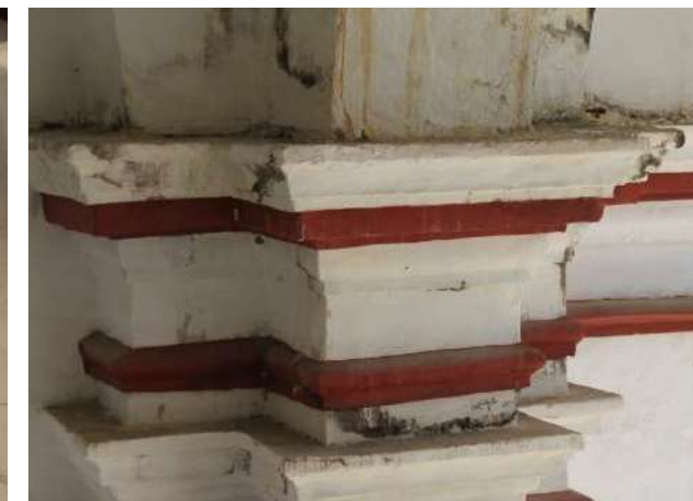
Imagen 3: Vista frontal de capitel de pilastra nororiente
