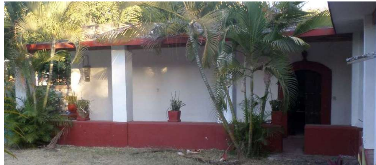
Imagen 1: Muro exterior poniente de bodega 1 y bodega 2
