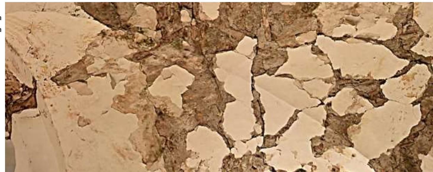
Imagen 2: Vista general del estado actual de intradós de cubierta
