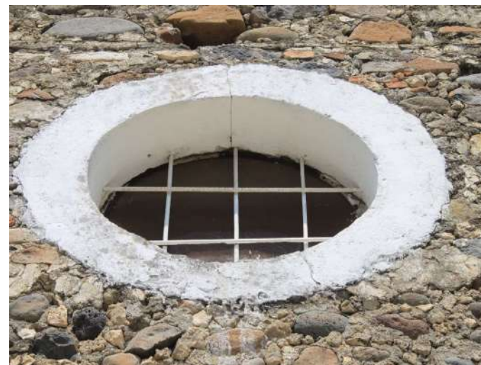
Imagen 3: Vista de ventana oval en muro exterior oriente
