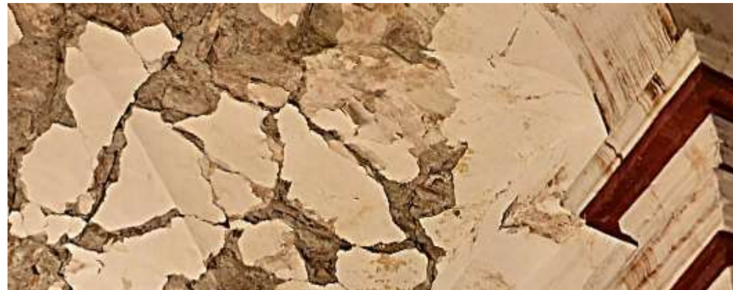
Imagen 1: Vista del estado actual del intradós de cubierta parte sur
