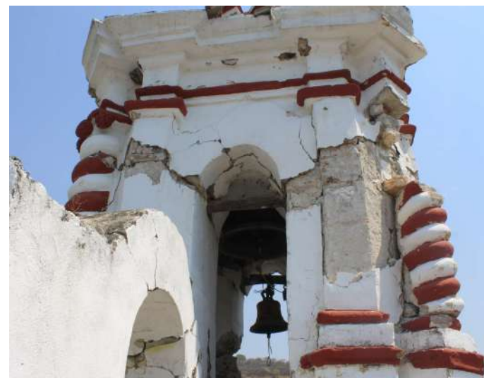
Imagen 2: Vista general del segundo cuerpo de torre campanario fachada sur
