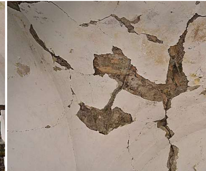
Imagen 2: Vista de intradós de parte norporiente de bóveda de Coro
