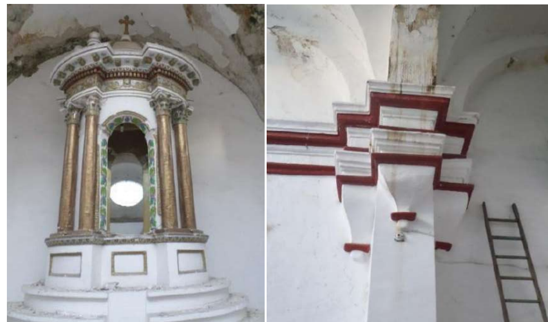
Imagen. 19. Detalle del altar y ciprés ubicado en el presbiterio (izquierda), detalle de cornisamento y pilastras ubicadas en la nave (derecha).
