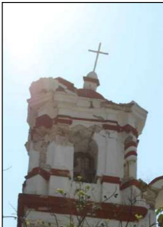
F03. Detalle del estado actual de fachada poniente de Torre Campanario
