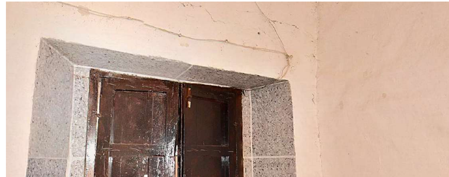
Imagen 2: Detalle de parte del muro interior norte
