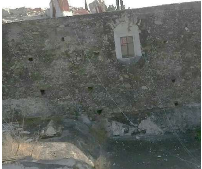
Imagen 1: Muro de fachada Norte
