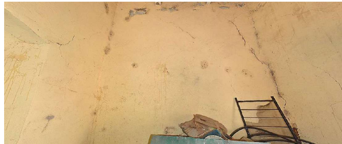
Imagen 1: Vista del muro interior poniente
