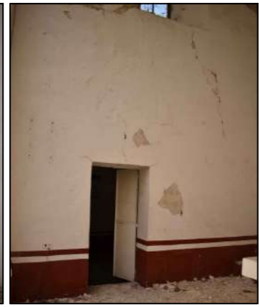
F02. Vista de muro interior norte de Presbiterio
