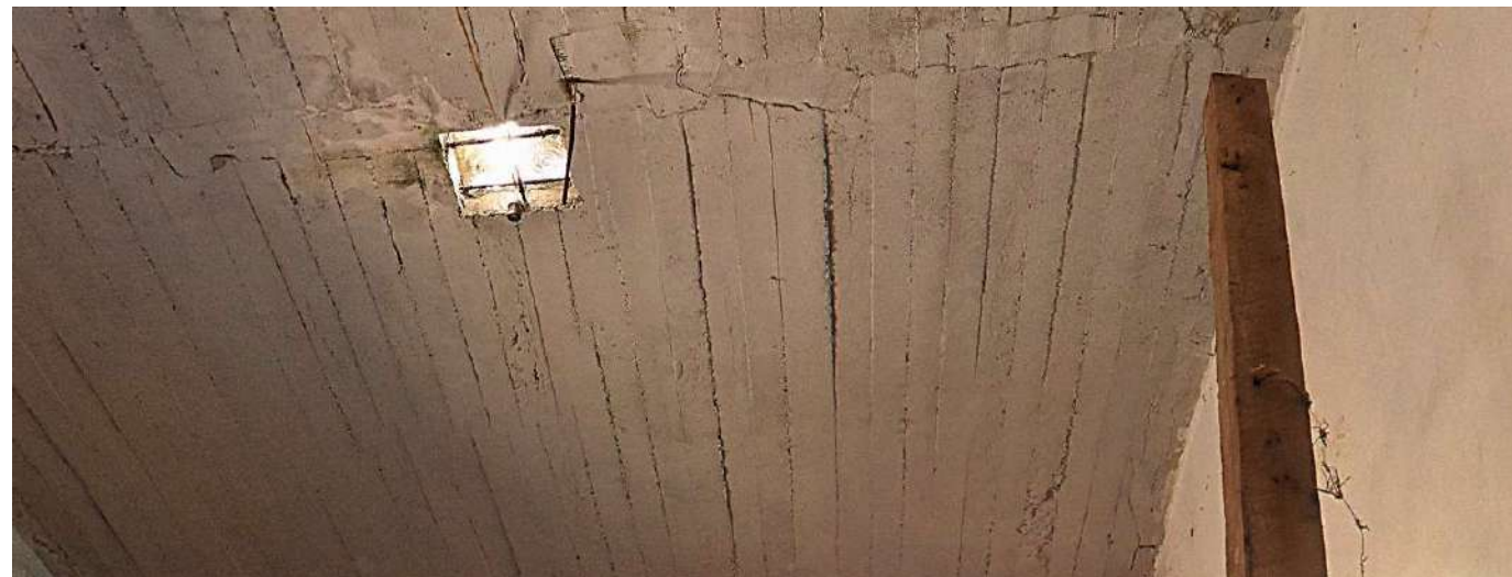
Imagen 2: Vista por intradós de cubierta
