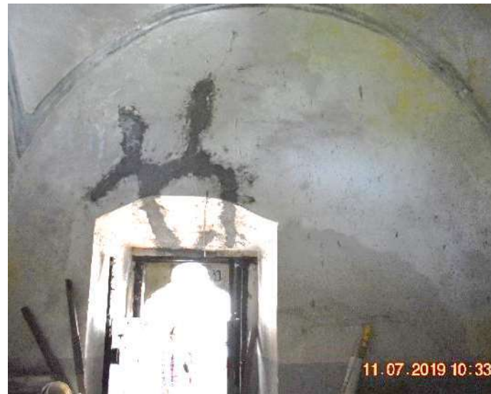
Imagen 1: Muro interior norte de Baptisterio
