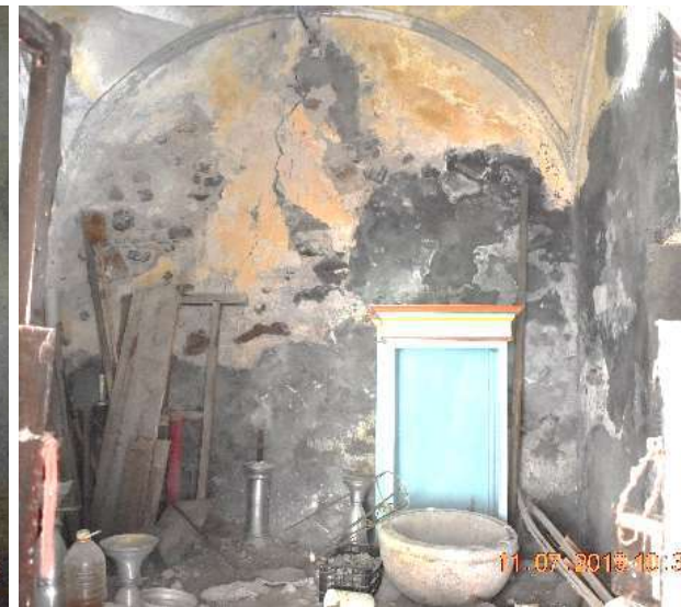
Imagen 2: Muro interior sur de Baptisterio
