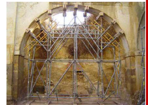
Fig. 3: Ejemplo de apuntalamiento con acero en arco
