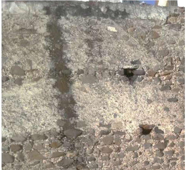
Imagen 2: Muro de fachada Sur
