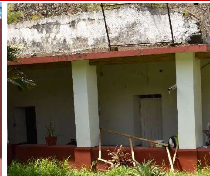
Imagen 2: Fachada Norte de Anexo a Sacristía y Anexo 2
