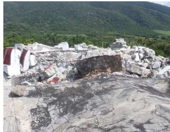
Imagen 3: Vista por el exterior, se aprecia el escombros resultante del colapso de cúpula
