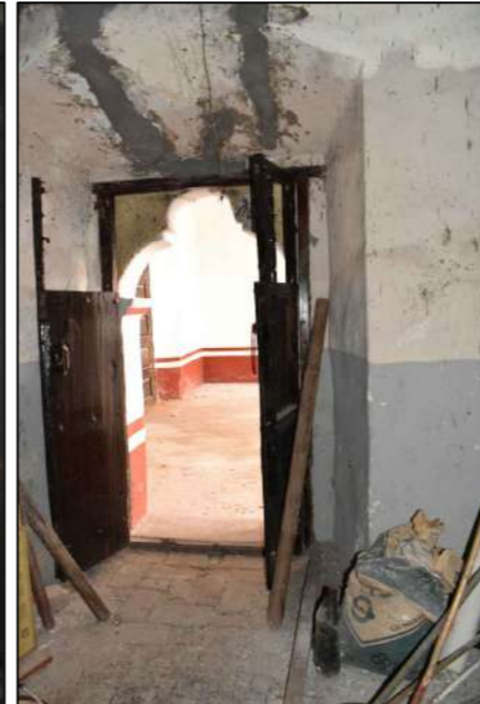
F03. Vista de muro interior norte de Baptisterio
