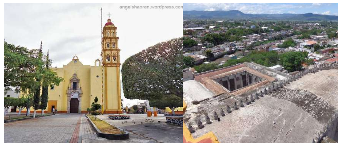
Imagen. 6. Fachada principal del templo del Ex Convento de Santo Domingo de Guzmán en Izúcar de Matamoros (izquierda), Vista de azotea del claustro del mismo Ex Convento (derecha). Fuente: Sánchez Paulino, 2017.
