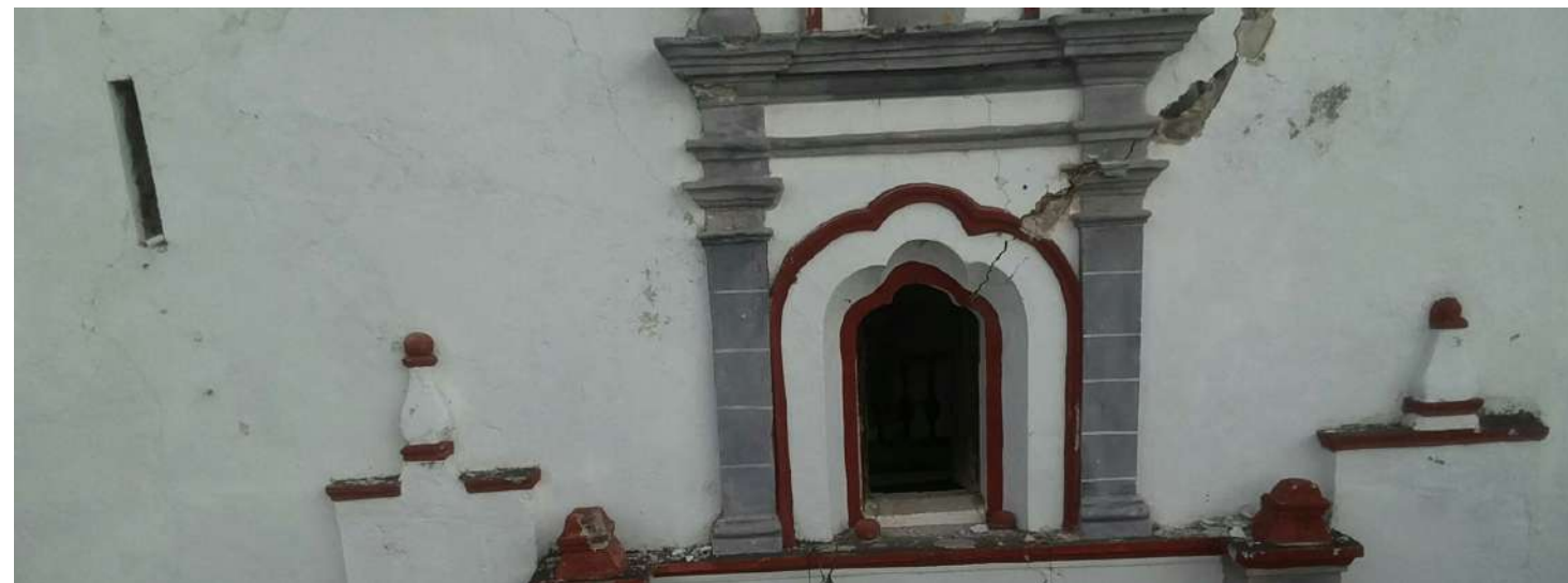
Imagen 1: Vista general del segundo cuerpo de fachada poniente
