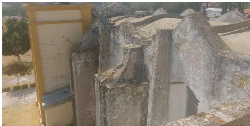
Imagen. 15. El concreto armado como solución en la restauración de monumentos históricos ha sido utilizado en numerosos ejemplos, en la imagen superior traveses y contrafuertes de concreto armado “abrazando” a modo de marcos rígidos la bóveda del templo de San Miguel Arcángel, Ixitlán, Puebla.
