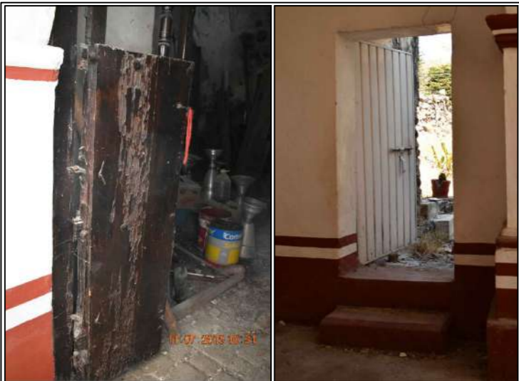
F01. Puerta de madera de acceso a baptisterio vista exterior F02. Puerta metálica de acceso a templo por jardín
