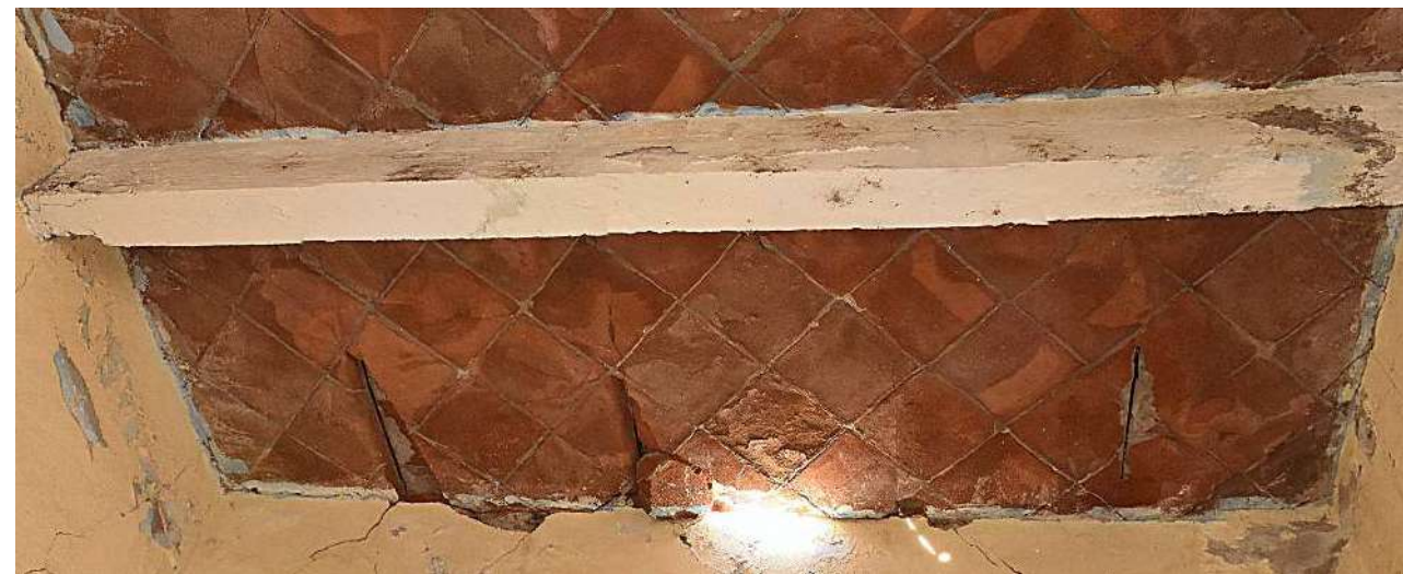
Imagen 1: Sección del intradós de cubierta
