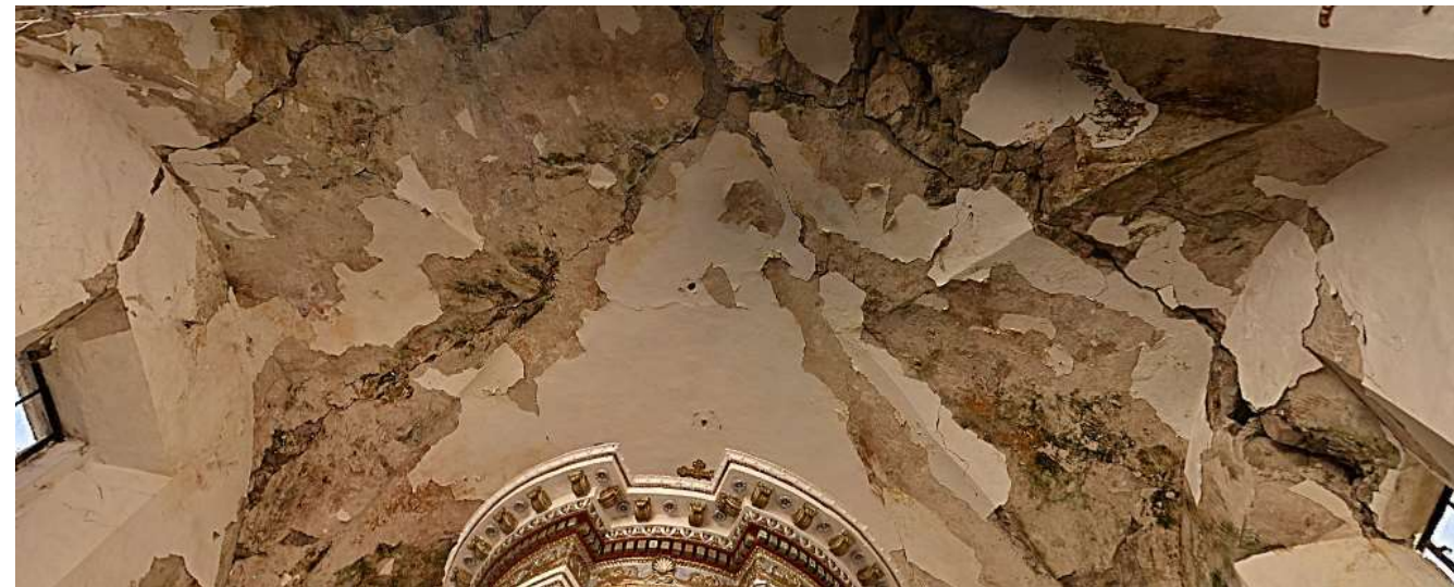
Imagen 1: Vista general del intradós de cubierta
