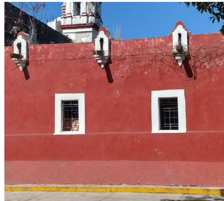
Imagen 1: Vista frontal del muro exterior oriente
