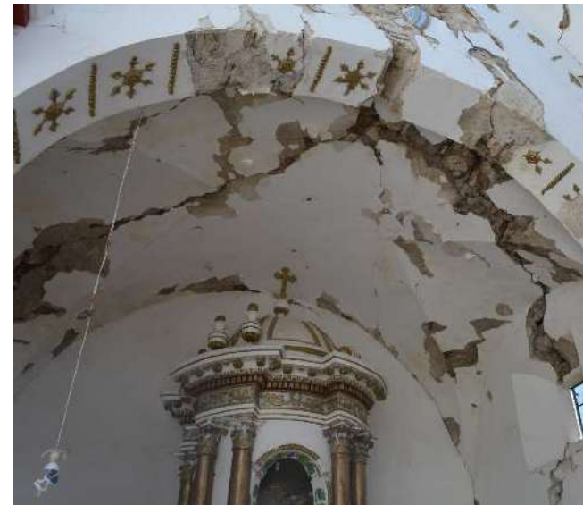
Imagen 1: Vista interior de bóveda de presbiterio
