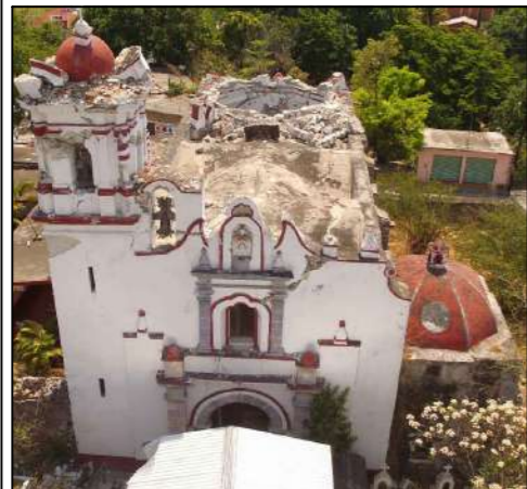
F01. Vista general aérea de fachada principal
