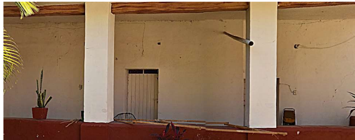
Imagen 1: Vista general de muro exterior norte
