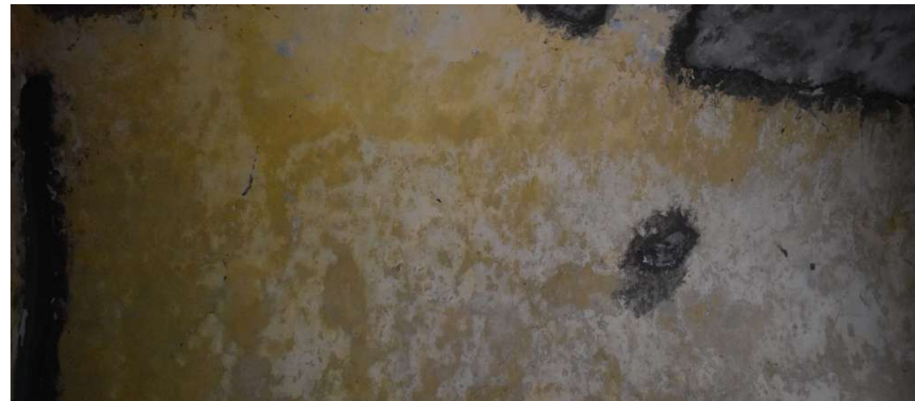
Imagen 1: Vista general de parte alta del muro interior poniente
