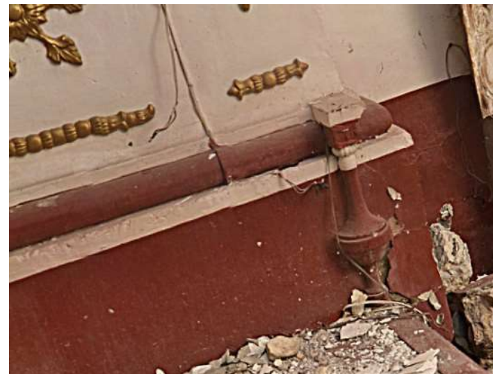
Imagen 3: Vista frontal de basa de pilastra suroriente en Nave tramo 2
