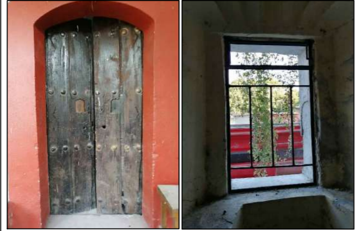
F05. Puerta de madera de acceso a bodega 1 F06. Ventana de herrería de bodega, vista interior
