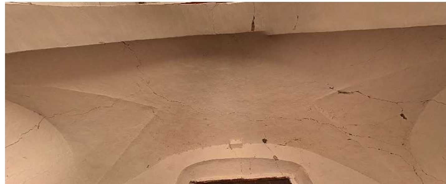
Imagen 1: Vista general del intradós de cubierta
