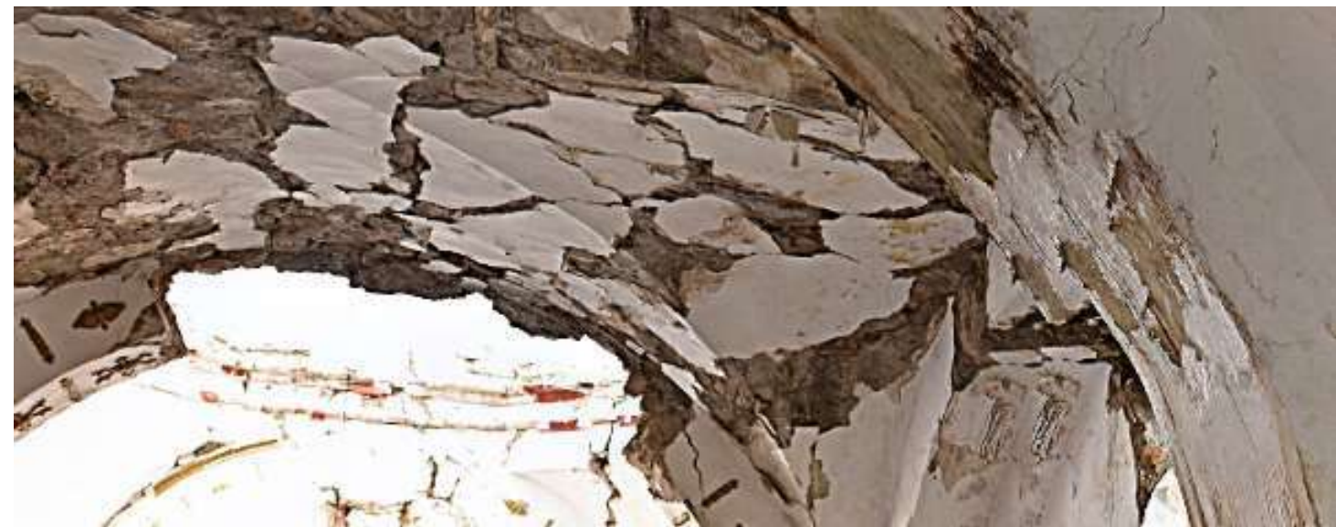
Imagen 2: Vista poniente-orient de intradós de cubierta
