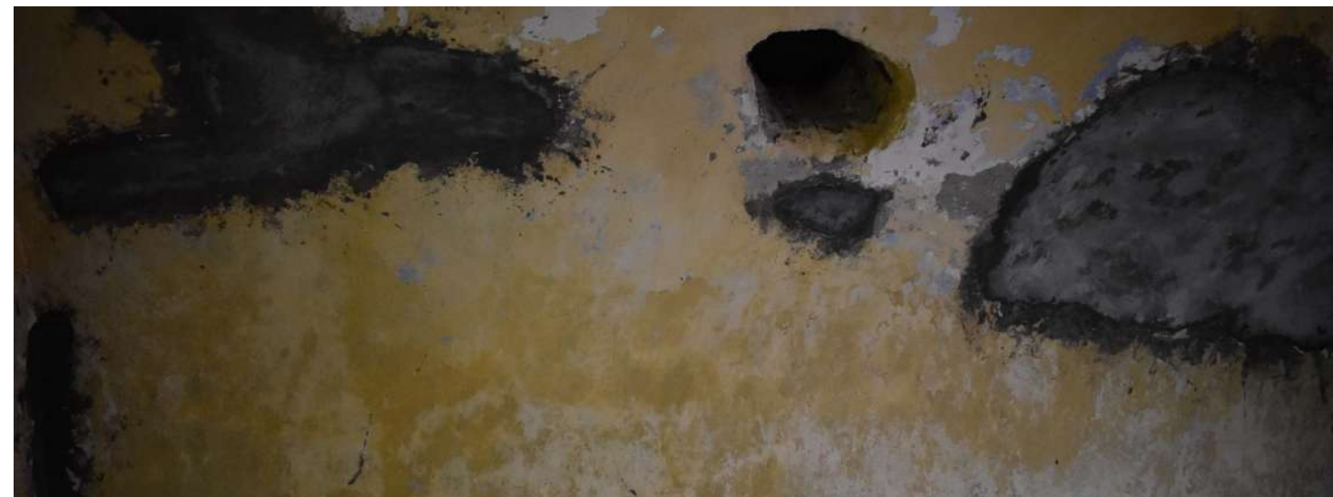
Imagen 2: Vista del intradós de la cubierta
