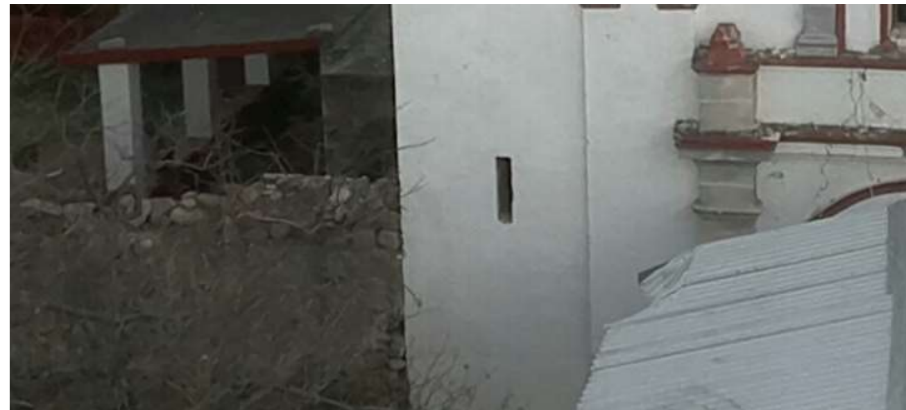
Imagen 1: Vista general de primer cuerpo de torre exterior poniente
