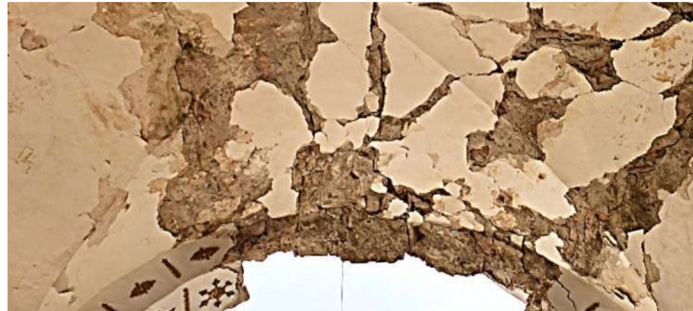
Imagen 1: Vista general poniente-oriente de intradós de cubierta
