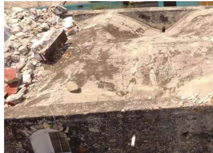
Imagen 2: Vista general norte-sur de extradós de cubierta
