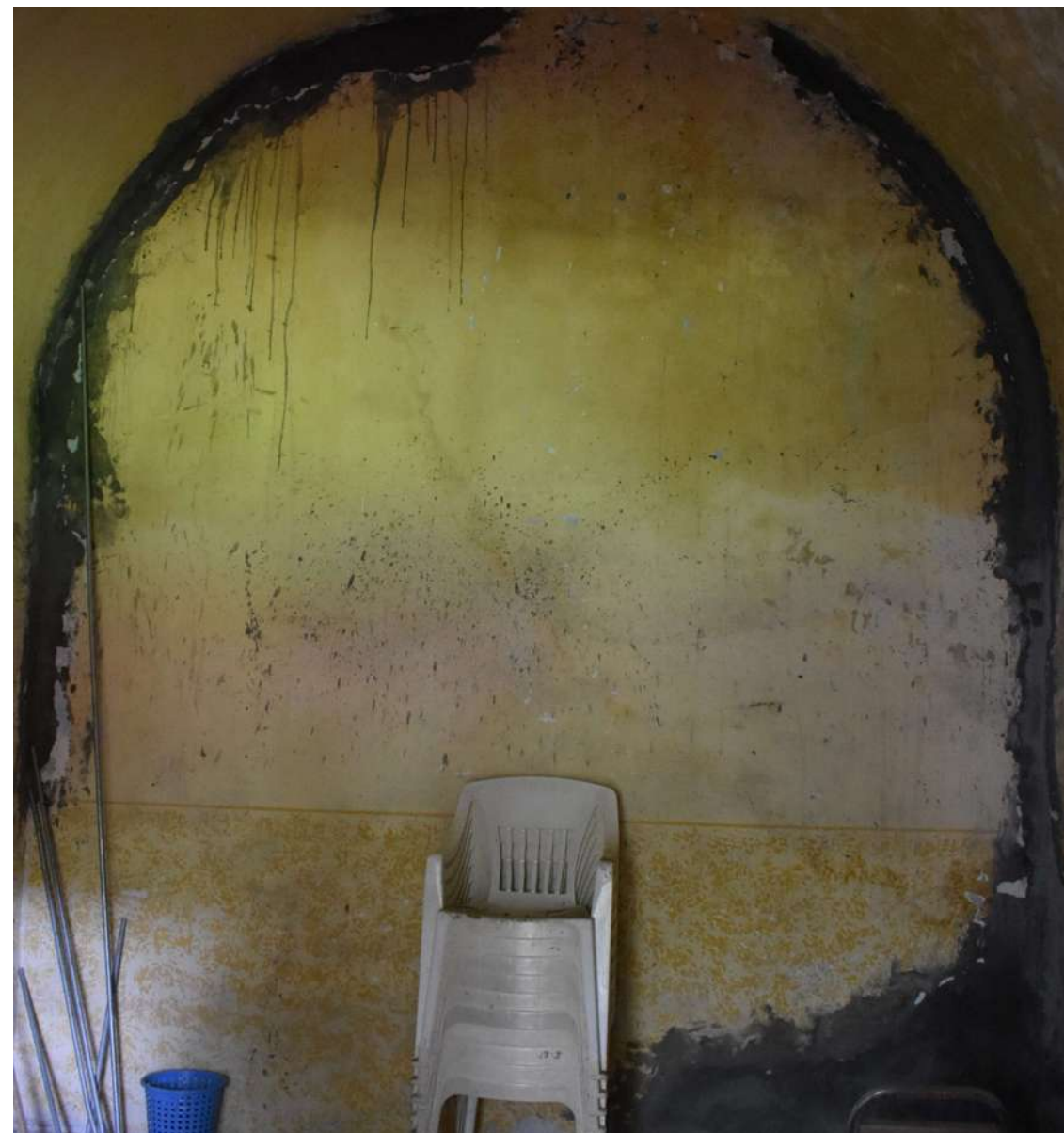
Imagen 1: Vista general de muro interior sur
