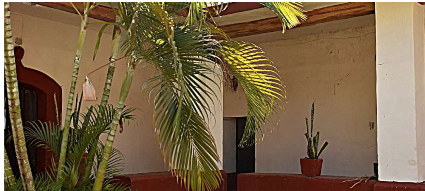
Imagen 1: Vista general del muro exterior norte
