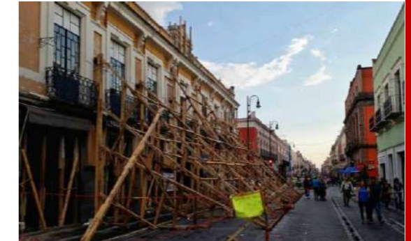
Fig. 2: Ejemplo de apuntalamiento con madera en muros
