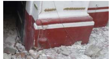
Imagen 4. Detalle de basa de pilastra
