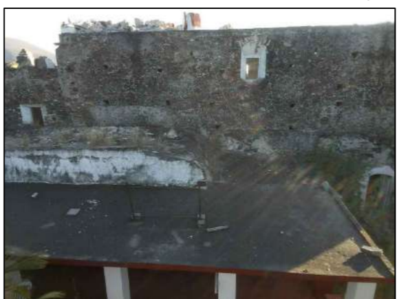
F02. Vista general de fachada norte
