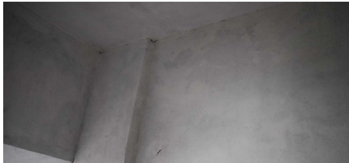
Imagen 1: Vista general del muro interior oriente
