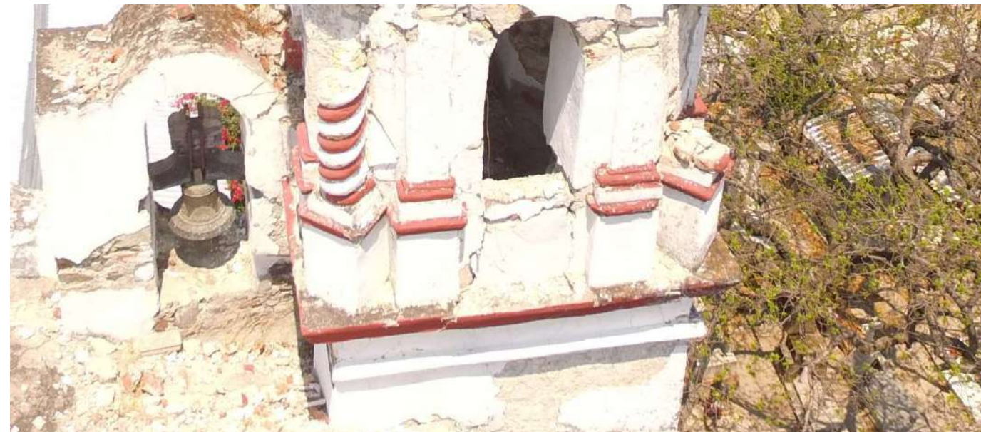
Imagen 1: Vista aérea de fachada oriente
