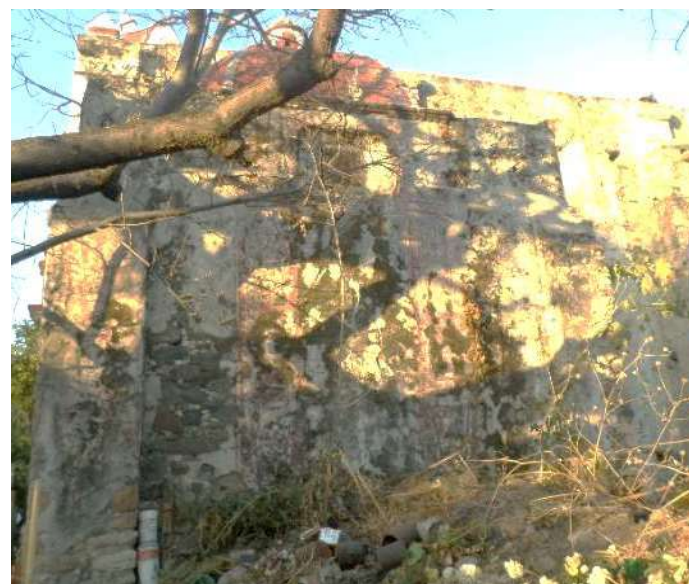
Imagen 3: Muro exterior sur de Baptisterio
