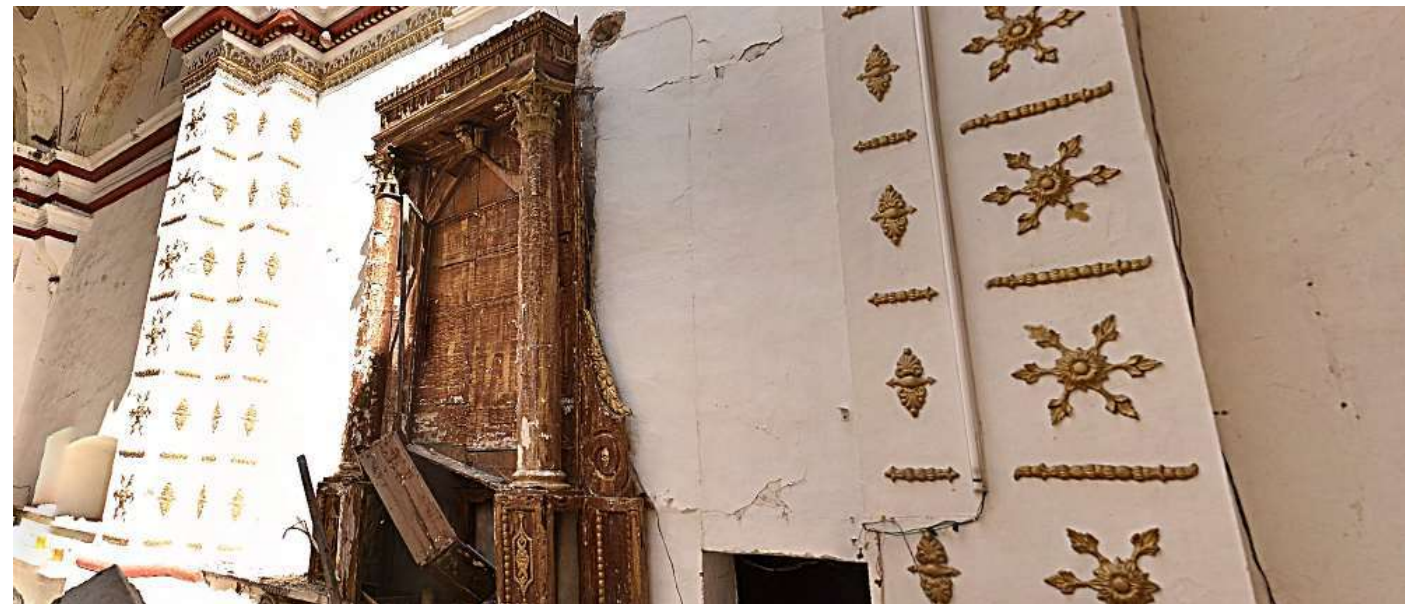
Imagen 1: Vista general de parte baja de muro interior norte en Nave tramo 2
