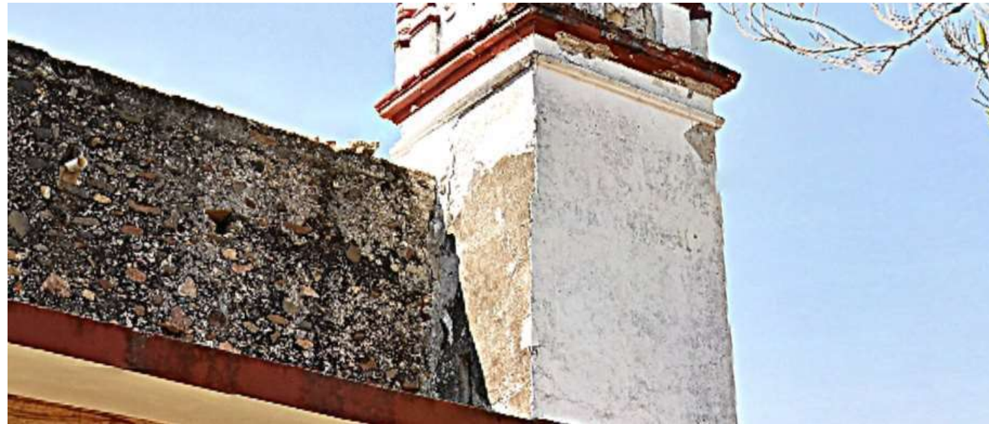
Imagen 1: Vista parcial de primer cuerpo de torre fachada oriente y norte
