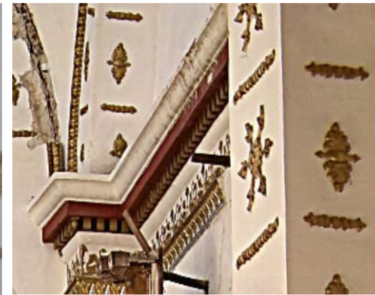
Imagen 2: Vista de molduras en muro interior sur de Nave tramo 2
