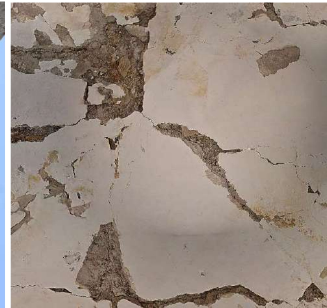
Imagen 3: Vista de intradós de arco de vano en ventana coral
