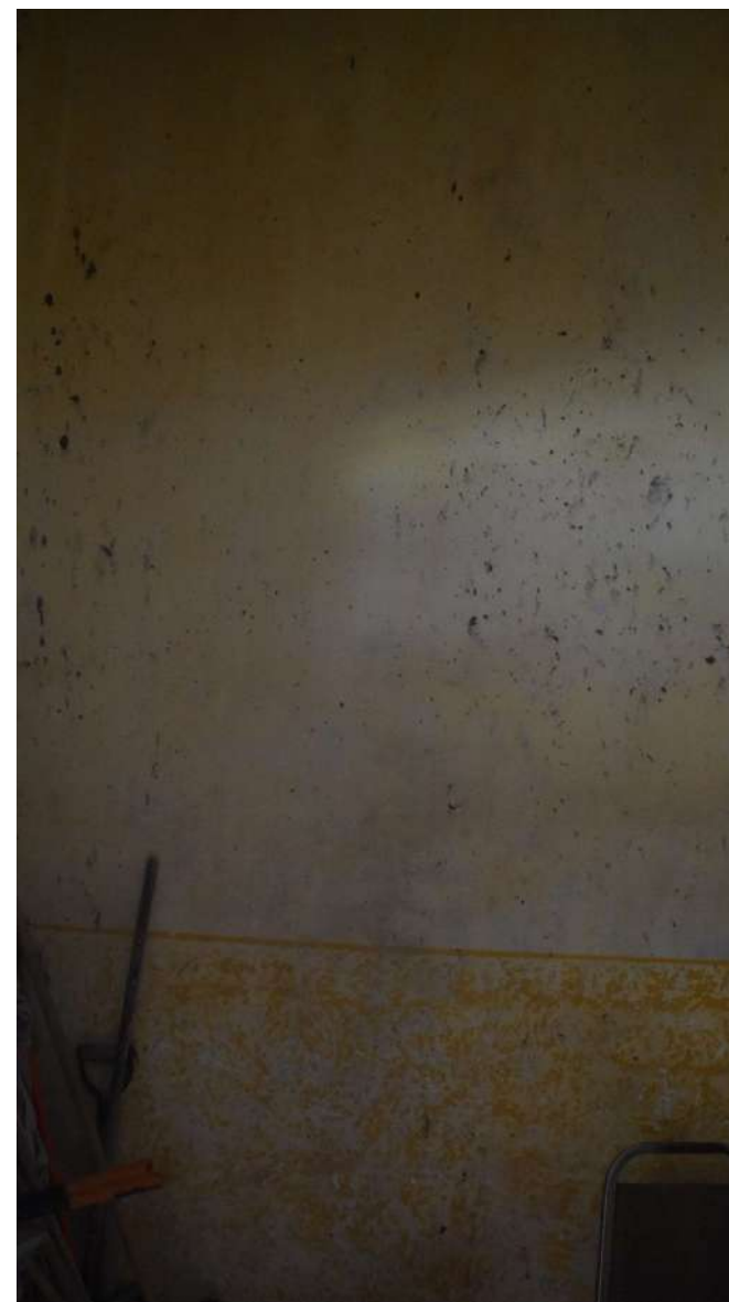
Imagen 1: Vista del muro interior oriente
