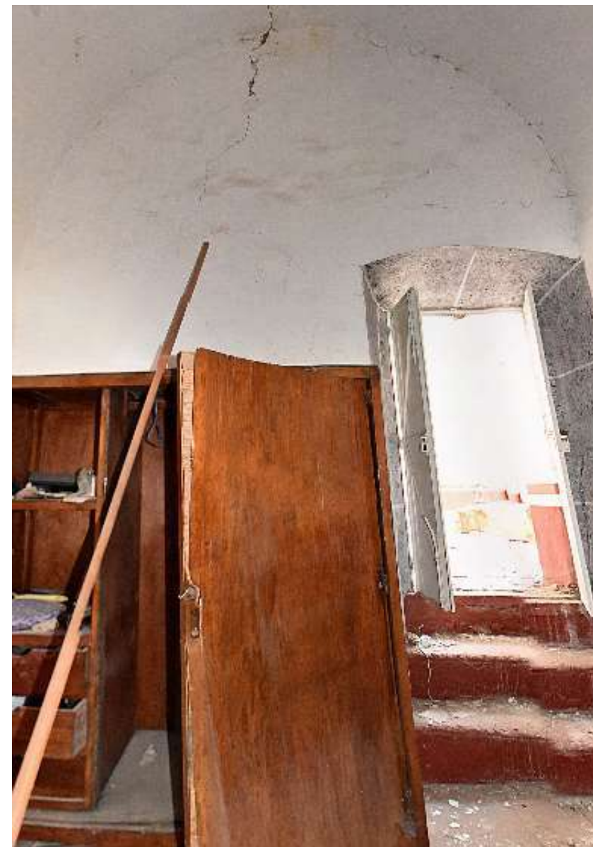
Imagen 1: Vista general del muro interior sur
