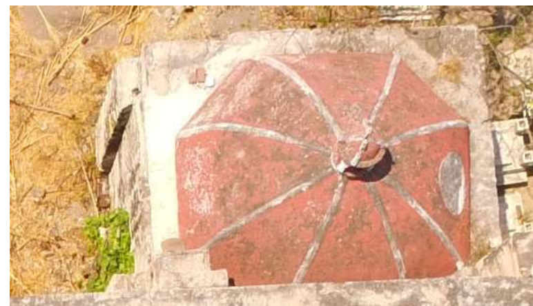
Imagen 2: Vista aérea de azotea de cúpula
