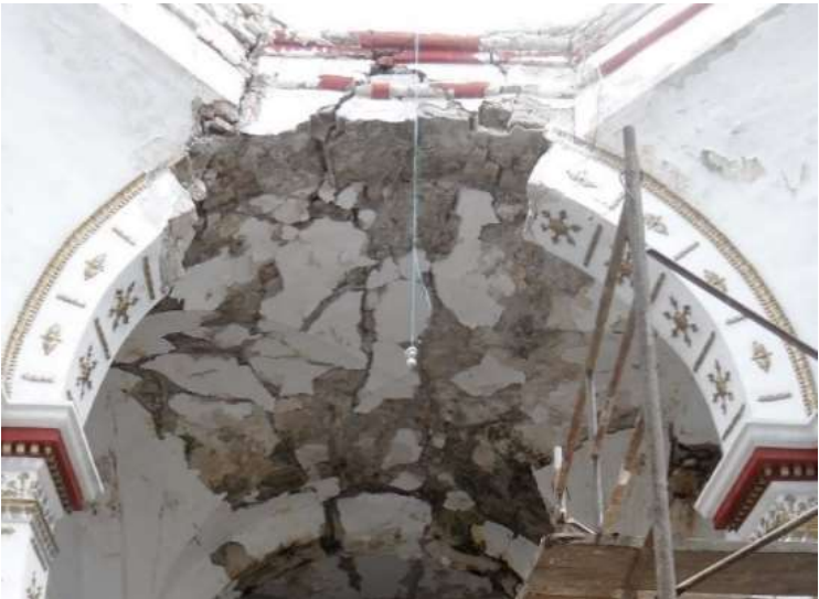
Imagen 3: Arco fajón Tramo 1-Tramo 2
