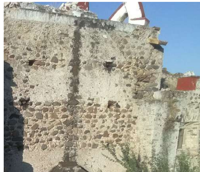
Imagen 1: Vista general de muro exterior sur
