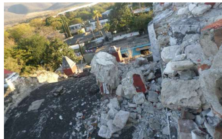
Imagen 2: Vista norte-sur del estado actual del extradós de cubierta
