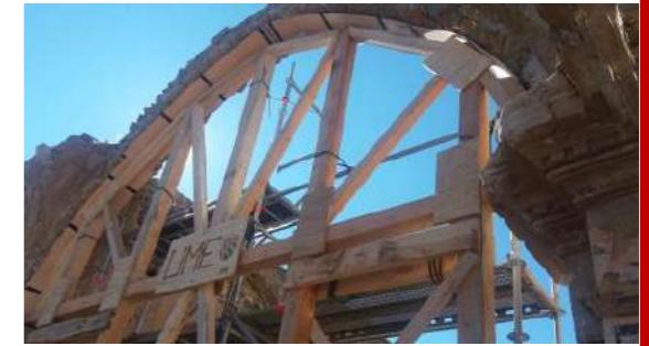
Fig. 1: Ejemplo de apuntalamiento con madera y acero en arco
