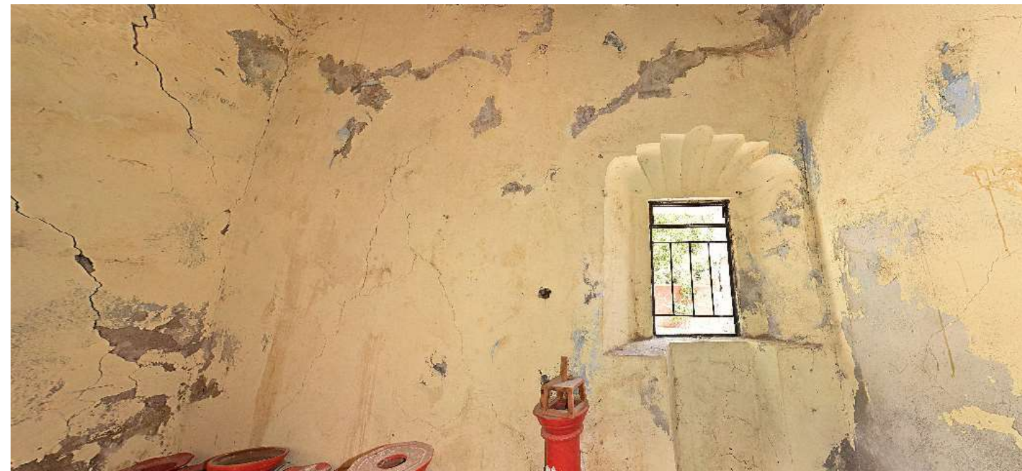
Imagen 1: Vista general del muro interior norte
