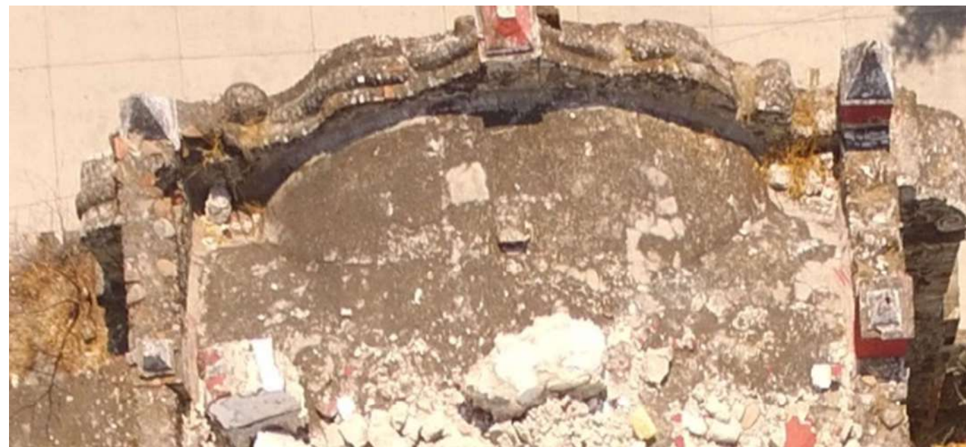
Imagen 1: Vista general del extradós de cubierta
