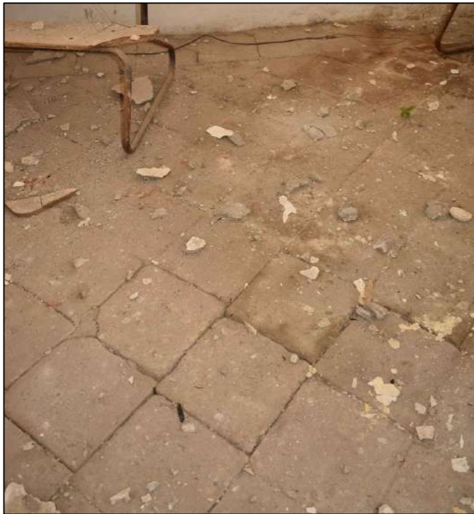
F01. Piso existente en Coro
