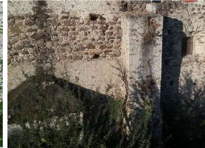
Imagen 2: Vista frontal del segundo cuerpo de contrafuerte de Eje 5
