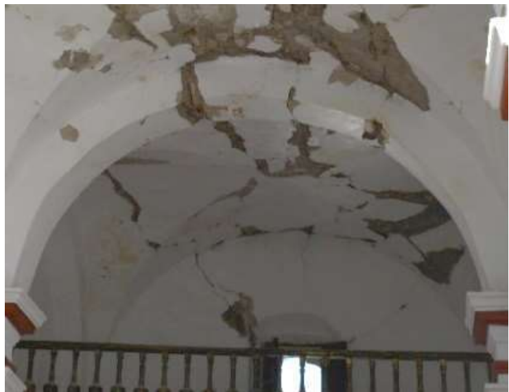
Imagen 1: Arco fajón de Coro-Tramo 1
