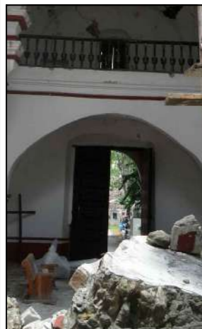
F01. Vista de muro interior poniente de Coro y Sotocoro
