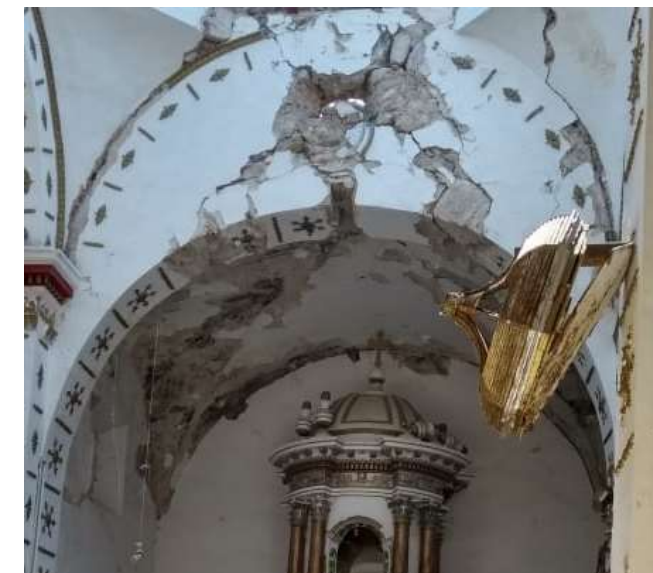
Imagen 4: Vista de arco poniente que da soporte a la bóveda de presbiterio
