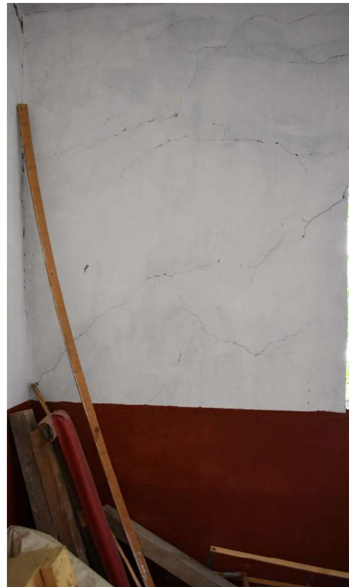
Imagen 1: Vista del muro interior poniente
