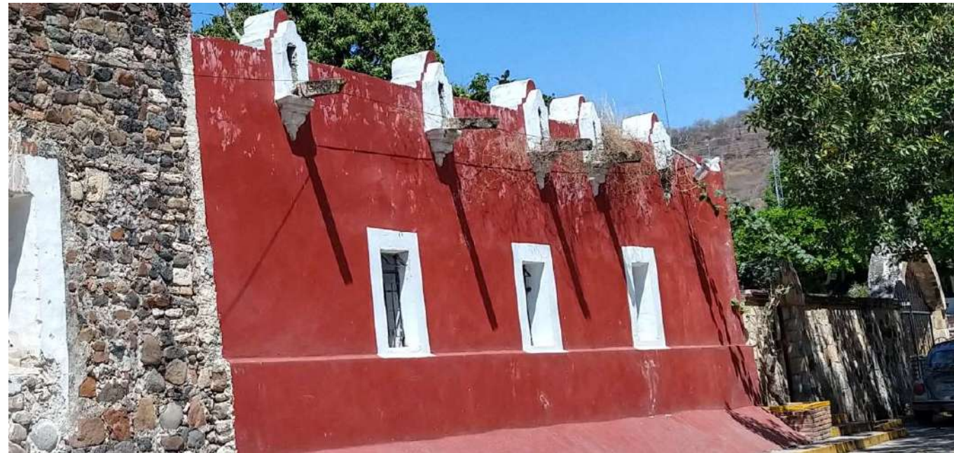
Imagen 1: Vista en perspectiva del muro exterior oriente
