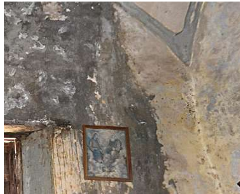
Imagen 1: Detalle del aplanado existente en muro interior poniente
