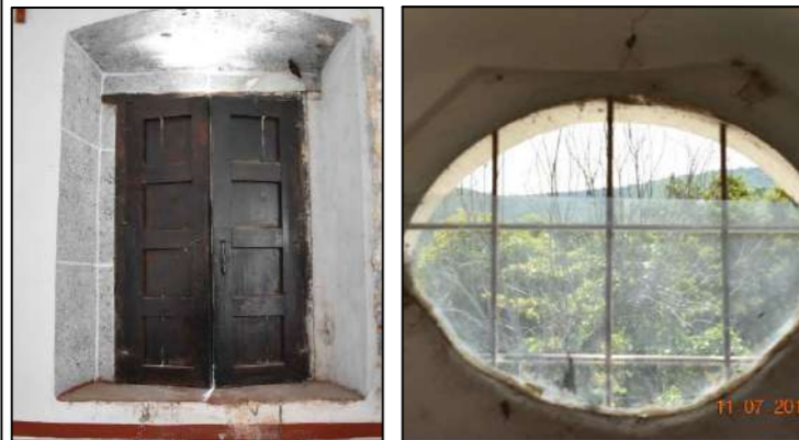
F03. Ventana de madera de sacristía vista interior F04. Ventana de cristal y herrería de presbiterio, vista interior
