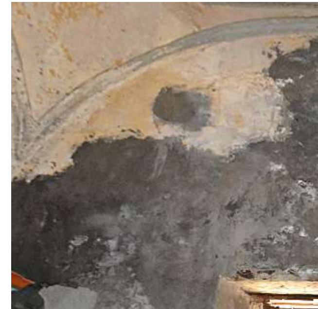
Imagen 2: Estado actual de muro interior poniente
