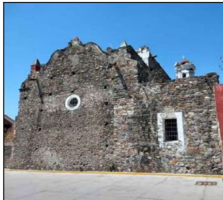
F01. Vista general de fachada oriente
