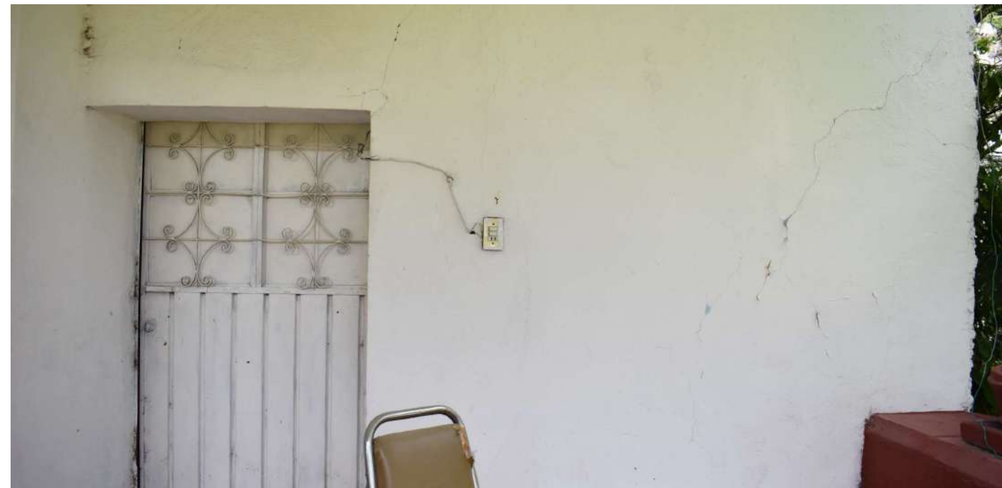
Imagen 1: Vista general de muro exterior norte
