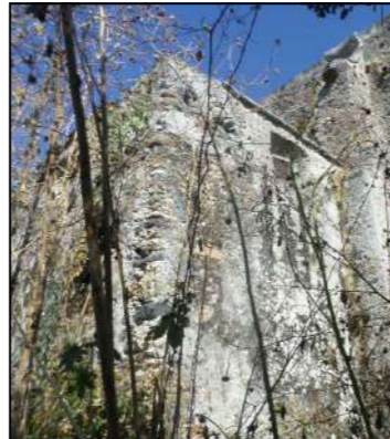
F02. Vista de fachada oriente de presbiterio
