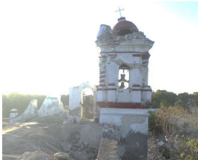
Imagen 2: Vista oriente de la torre campanario
