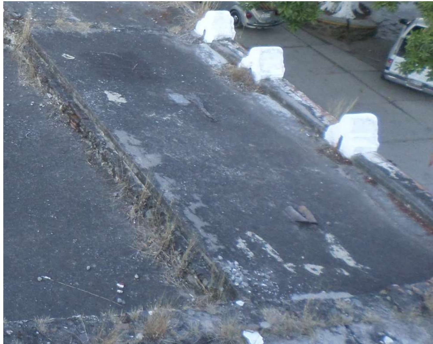
Imagen 1: Vista del extradós de cubierta
