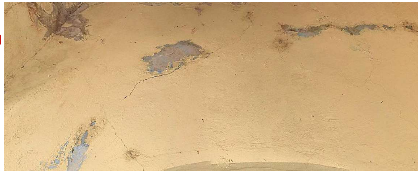
Imagen 1: Vista general del muro interior sur
