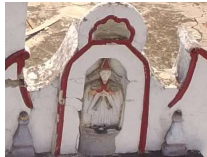
Imagen 3: Vista de deterioros en nicho
