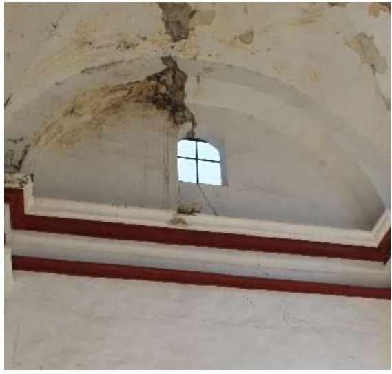
Imagen 4: Arco formero en Tramo 1
