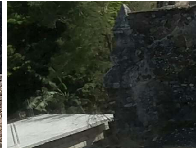
Imagen 2: Vista norte del contrafuerte del Eje 6 fachada norte
