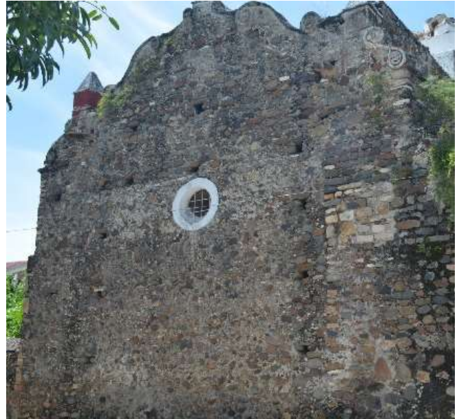
Imagen 3: Muro de fachada Oriente
