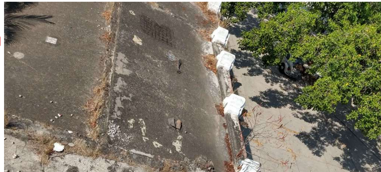
Imagen 1. Vista de azotea de cubierta de bodega 1
