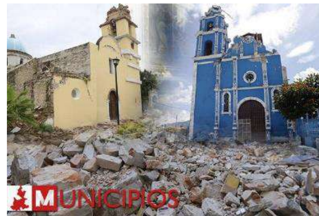
Imagen 11. Daños del Sismo de México (2017) Fuente: https://admin.municipiospuebla.mx/sites/
