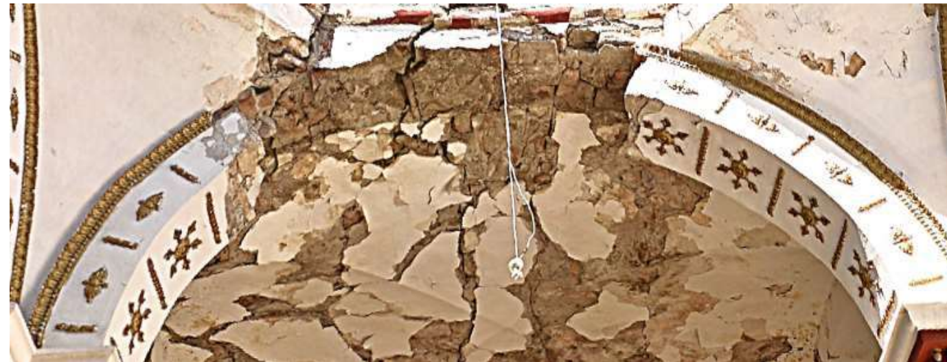
Imagen 2: Vista general oriente-poniente de intradós de cubierta
