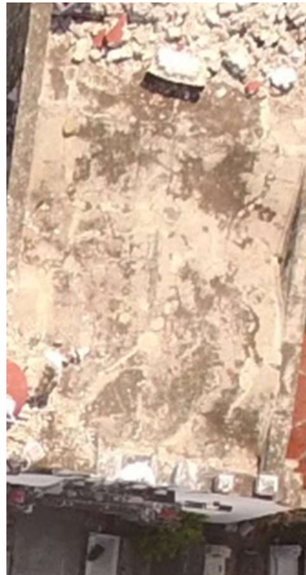
Imagen 1: Vista exterior de cubierta de coro y nave tramo 1
