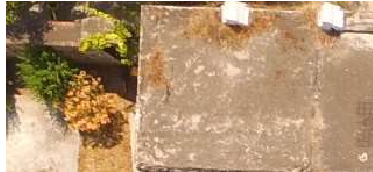
Imagen 3. Vista de azotea de cubierta de bodega 2
