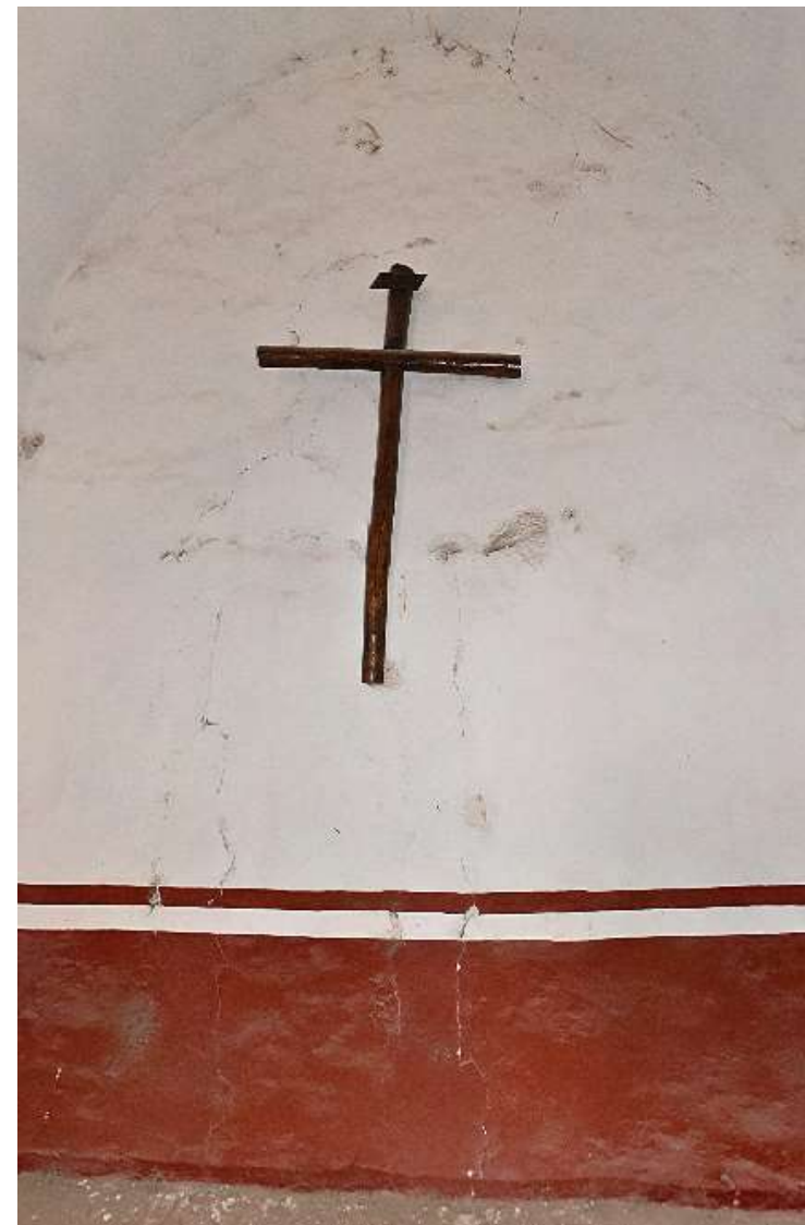
Imagen 1: Vista general del muro interior norte
