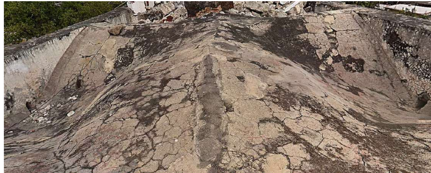
Imagen 1: Vista general poniente-orienté de extradós de cubierta
