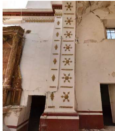
Imagen 2. Pilastra Norte de Presbiterio Vista Frontal
