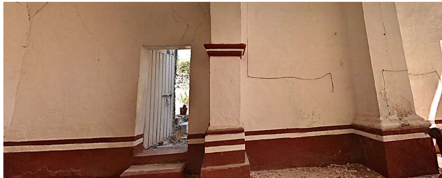
Imagen 1: Vista general de muro interior norte
