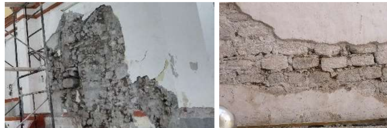
Muros conformados por diferentes materiales
