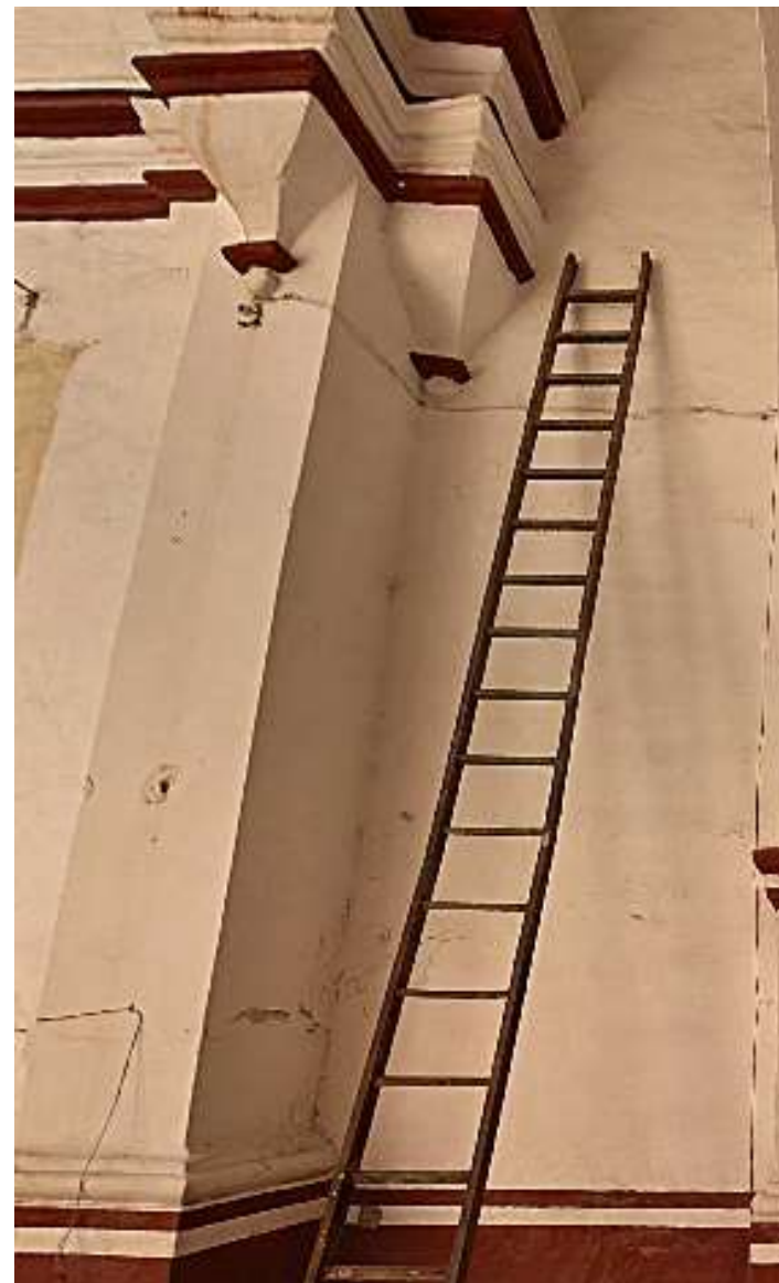
Imagen 1: Vista general de muro interior sur
