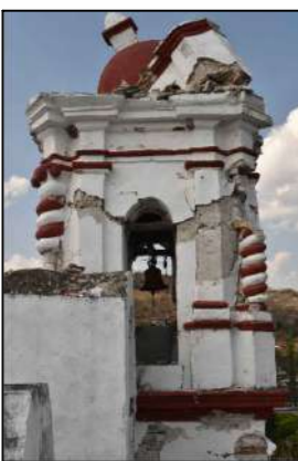
F01. Detalle del estado actual de Torre Campanario, fachada sur
