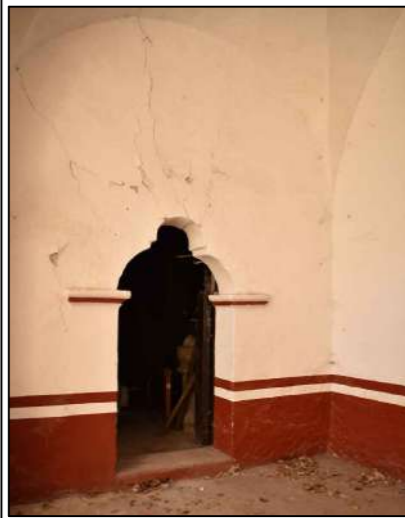
F01. Vista de muro interior sur de Sotocoro
