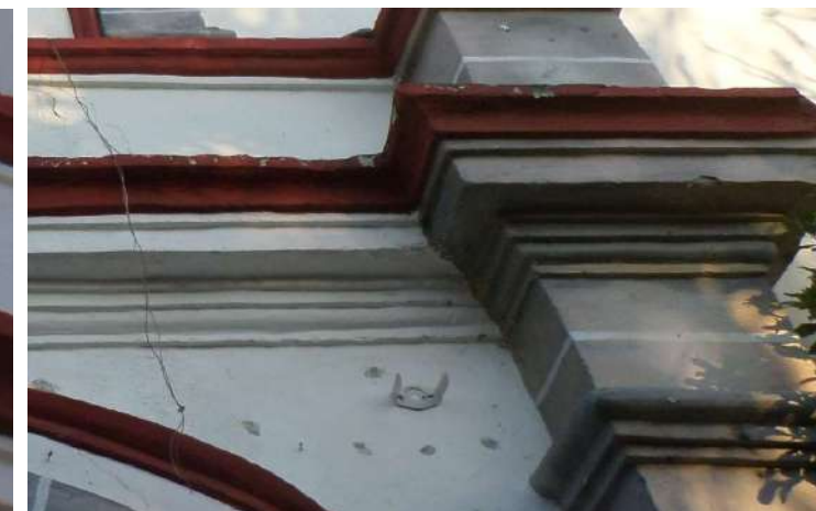
Imagen 3: Detalle del estado actual de cornisas
