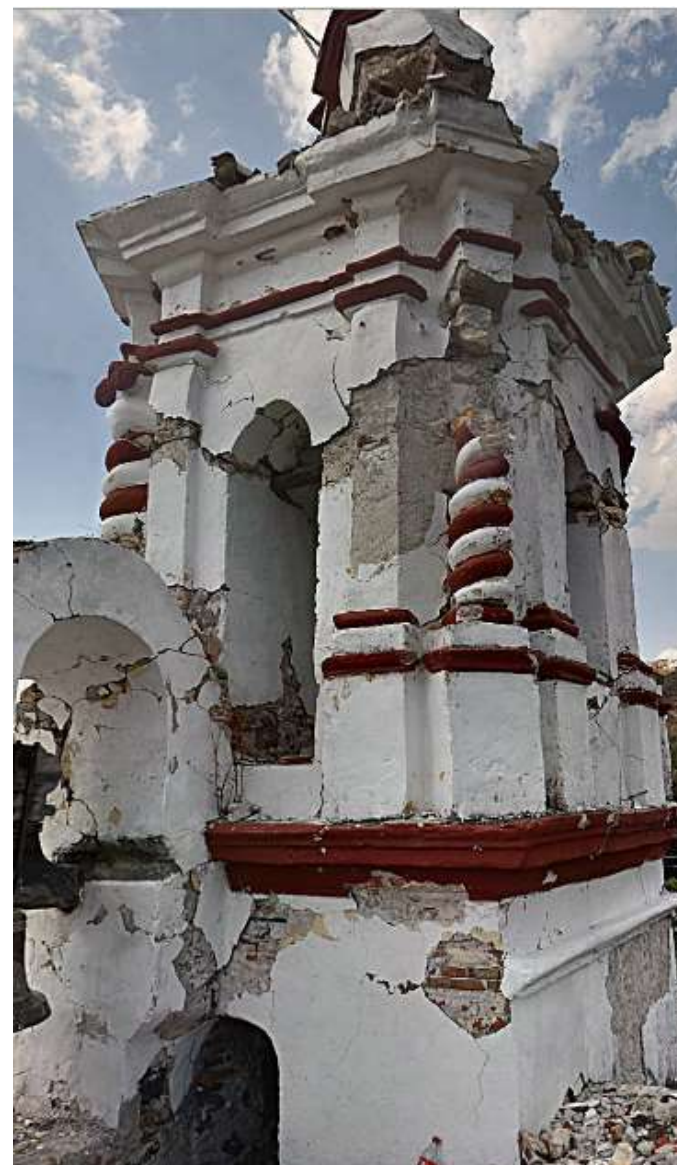
Imagen 1: Vista general de torre campanario segundo cuerpo fachada sur
