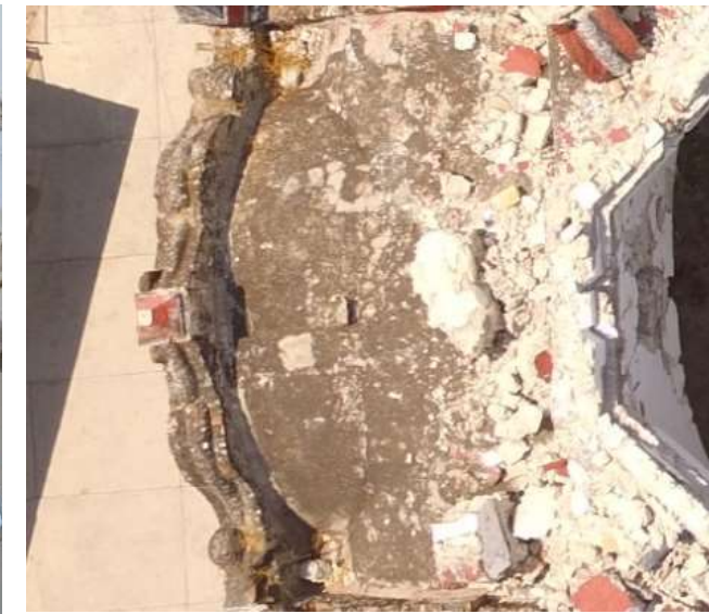
Imagen 2: Vista exterior de bóveda de presbiterio
