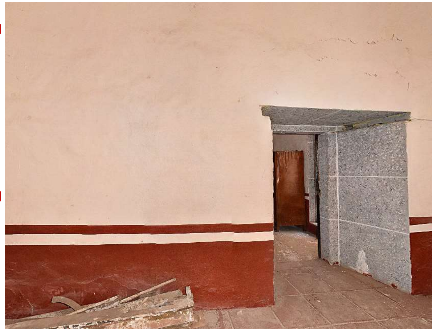
Imagen 1: Vista general de muro interior oriente
