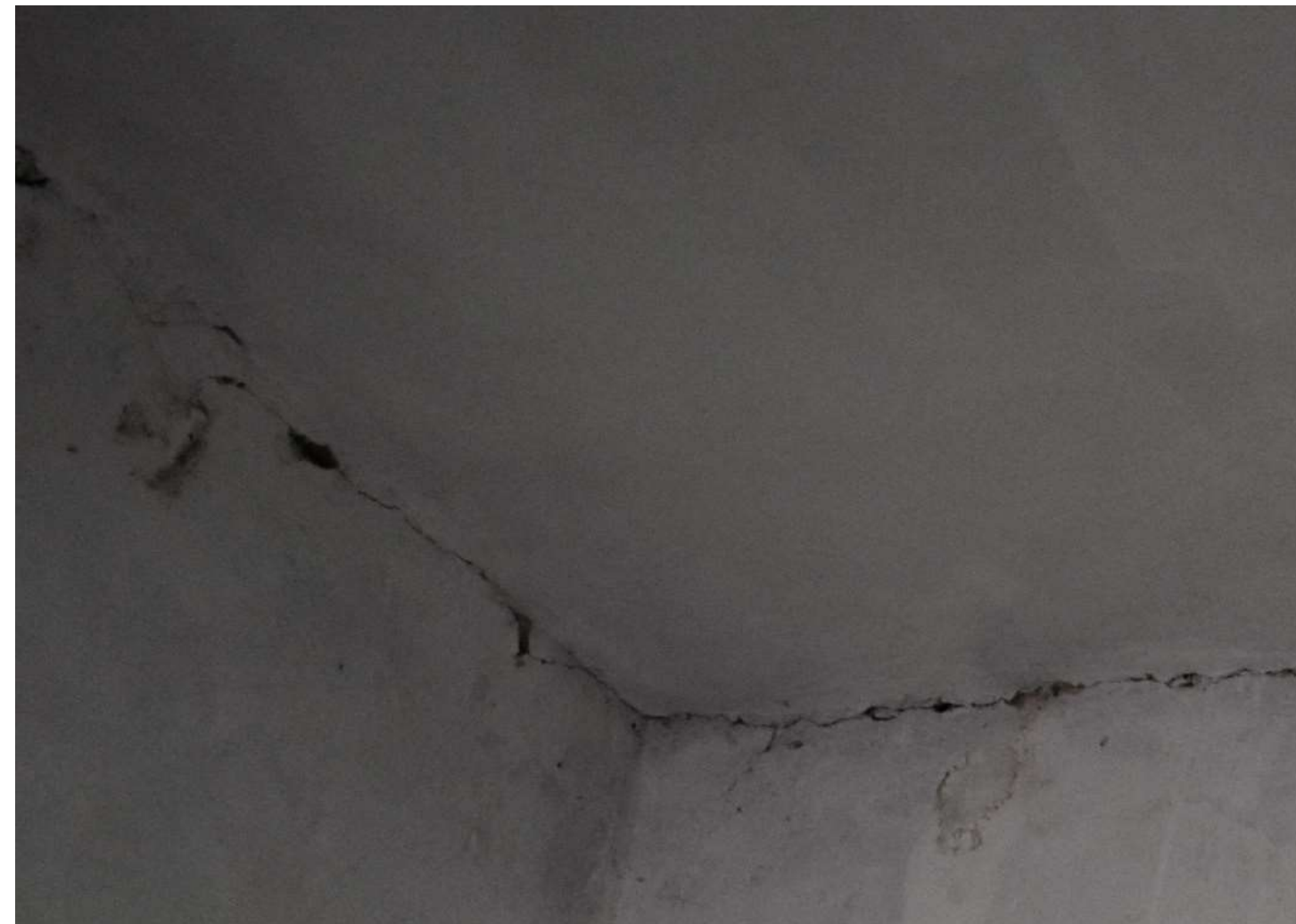
Imagen 1: Vista general del intradós de cubierta
