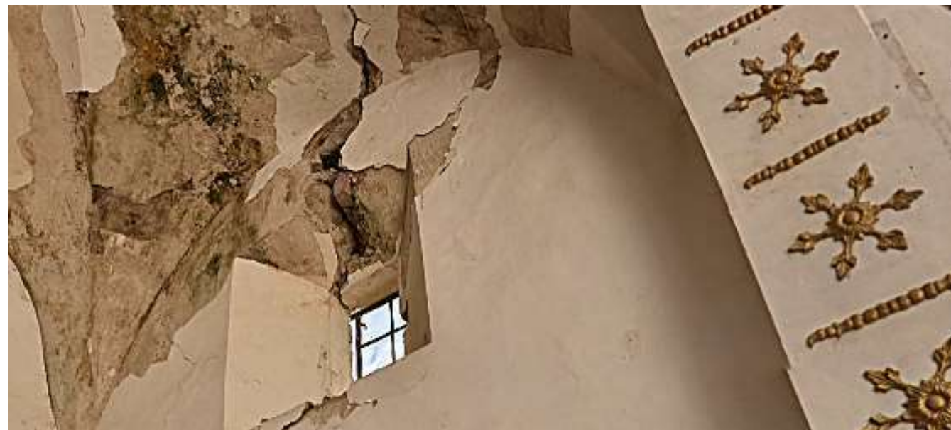
Imagen 1: Vista general del muro interior norte
