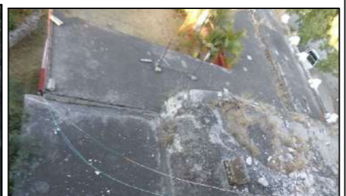
F02. Vista de azotea, cubierta de Anexo 3 y Bodega 1 y 2
