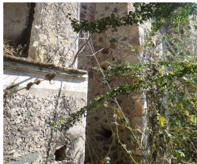
Imagen 3: Vista de perfil de primer cuerpo de contrafuerte
