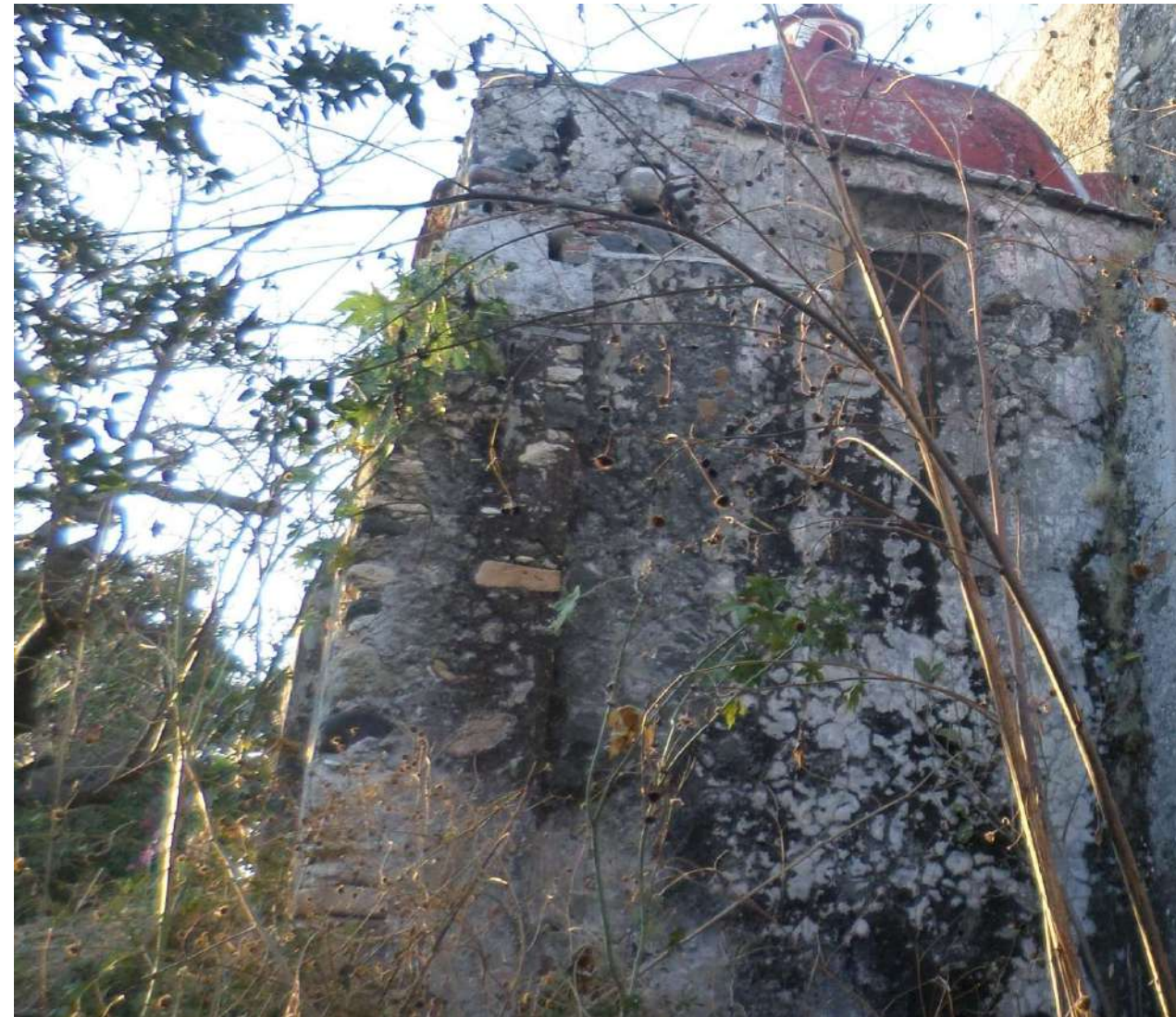
Imagen 1: Vista general del estado actual en muro interior oriente
