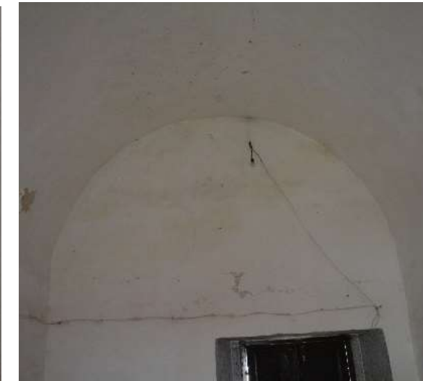
Imagen 3. Vista interior de la bóveda de anexo a sacristía
