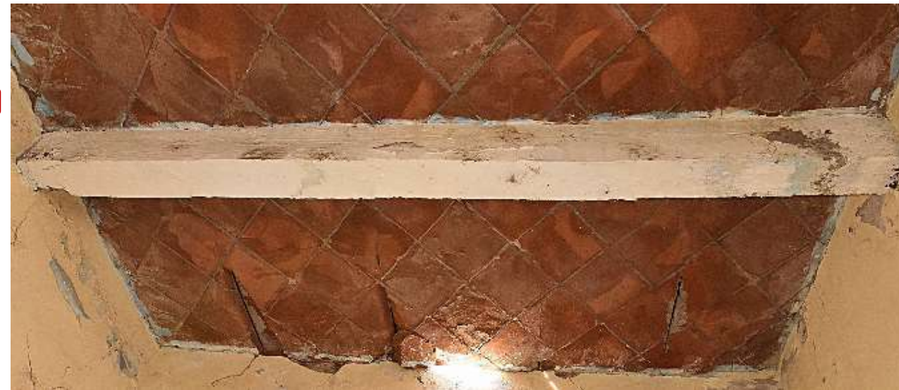
Imagen 1. Vista interior de cubierta de bodega 2
