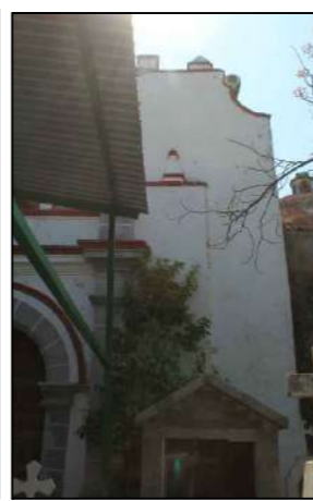
F03. Vista del estado actual de extremo sur de fachada poniente
