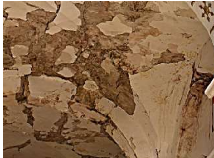
Imagen 1: Vista de intradós de cubierta parte norte
