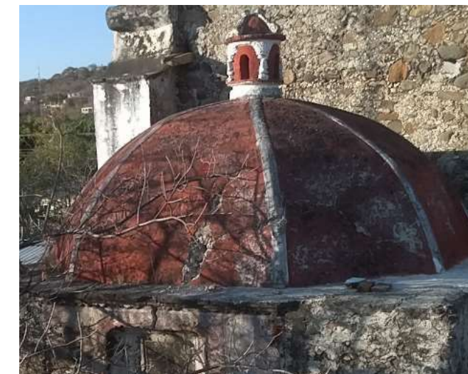
Imagen 4. Vista exterior sur de cúpula de baptisterio
