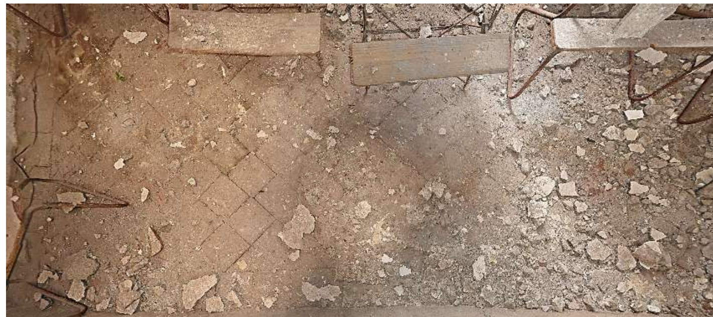
Imagen 1: Vista general del extradós de cubierta de Sotocoro (piso de coro)
