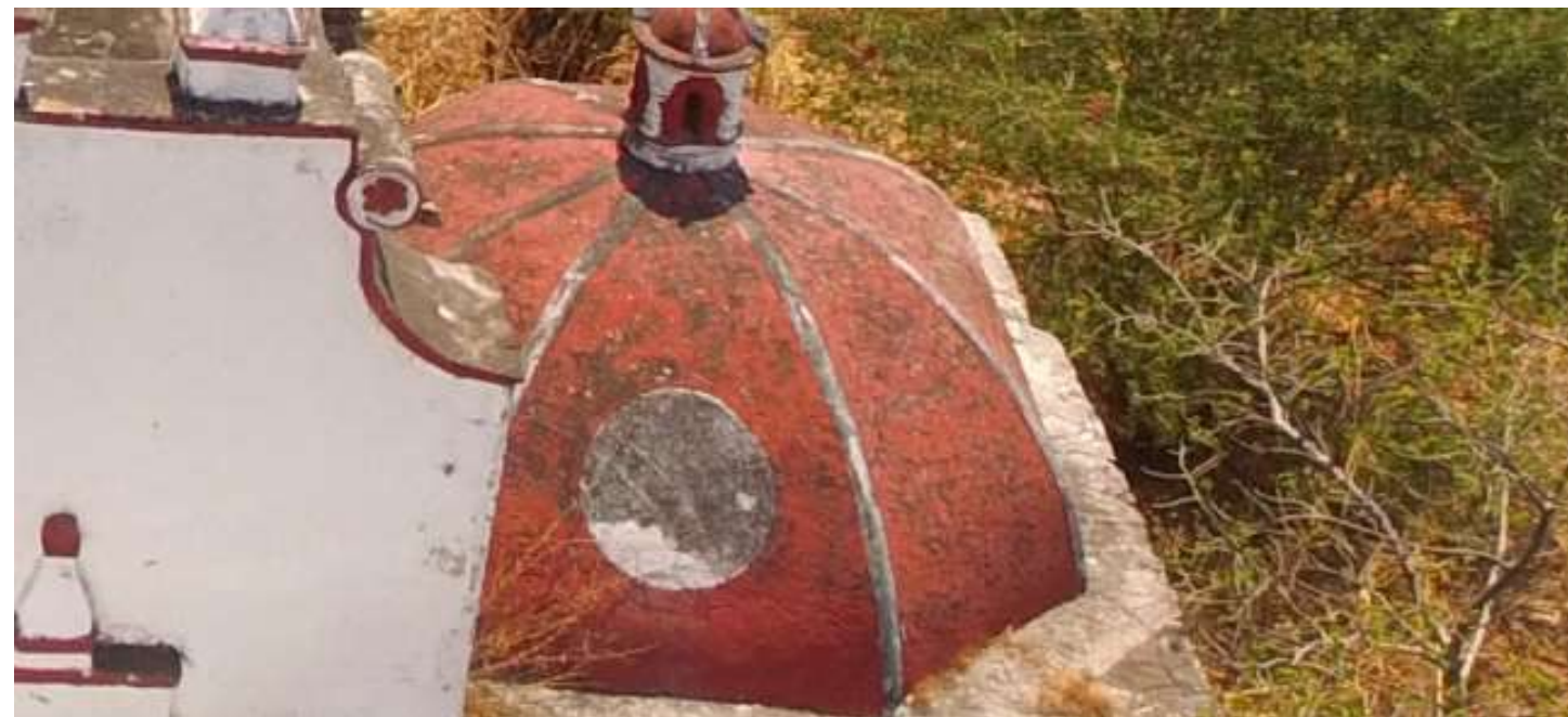
Imagen 1: Vista área poniente del extradós de cúpula
