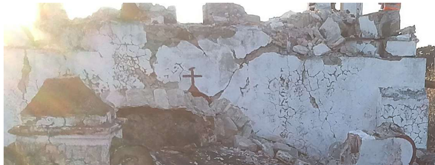
Imagen 1: Vista de muro y pechina suroriente en Nave tramo 2
