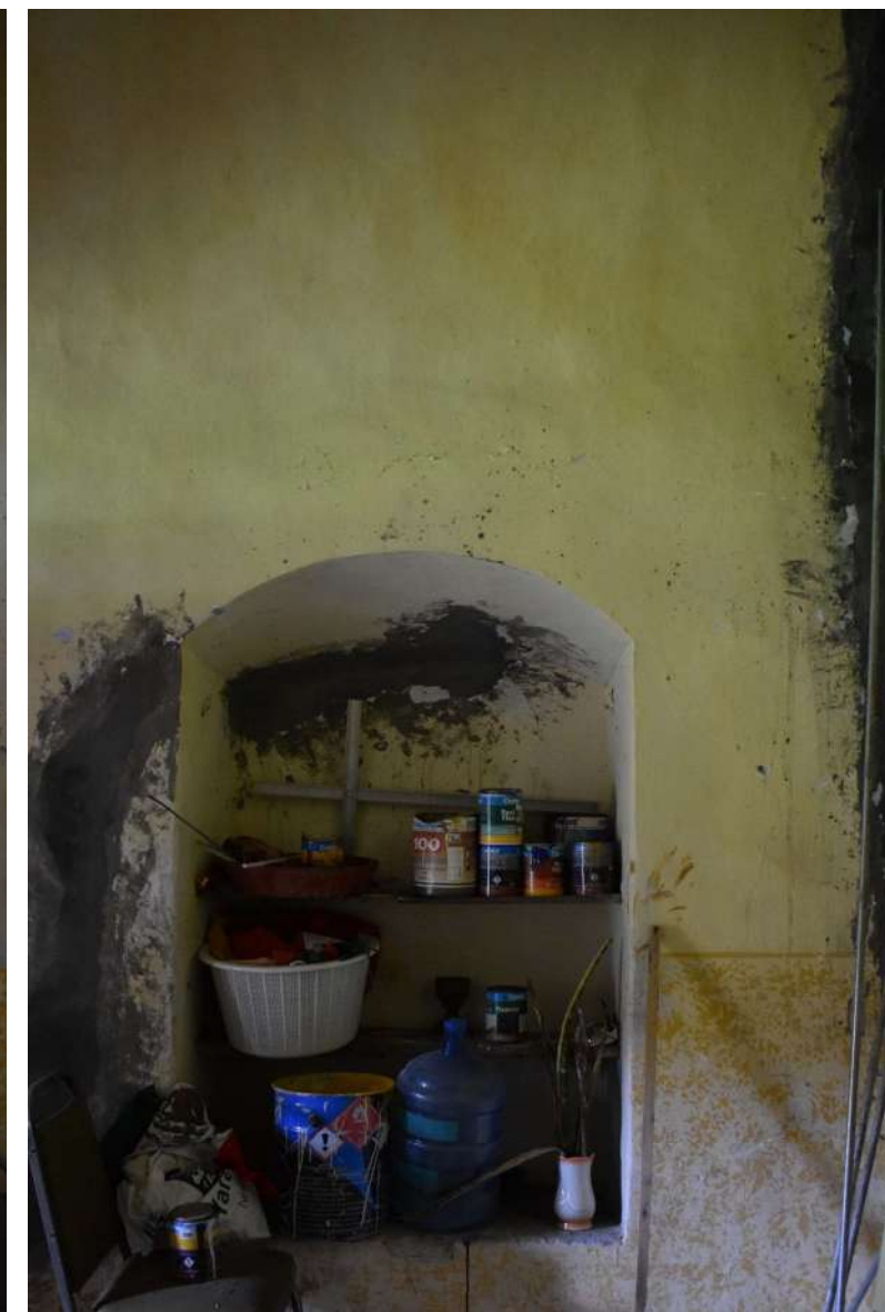
Imagen 2: Detalle del estado actual de muro interior oriente
