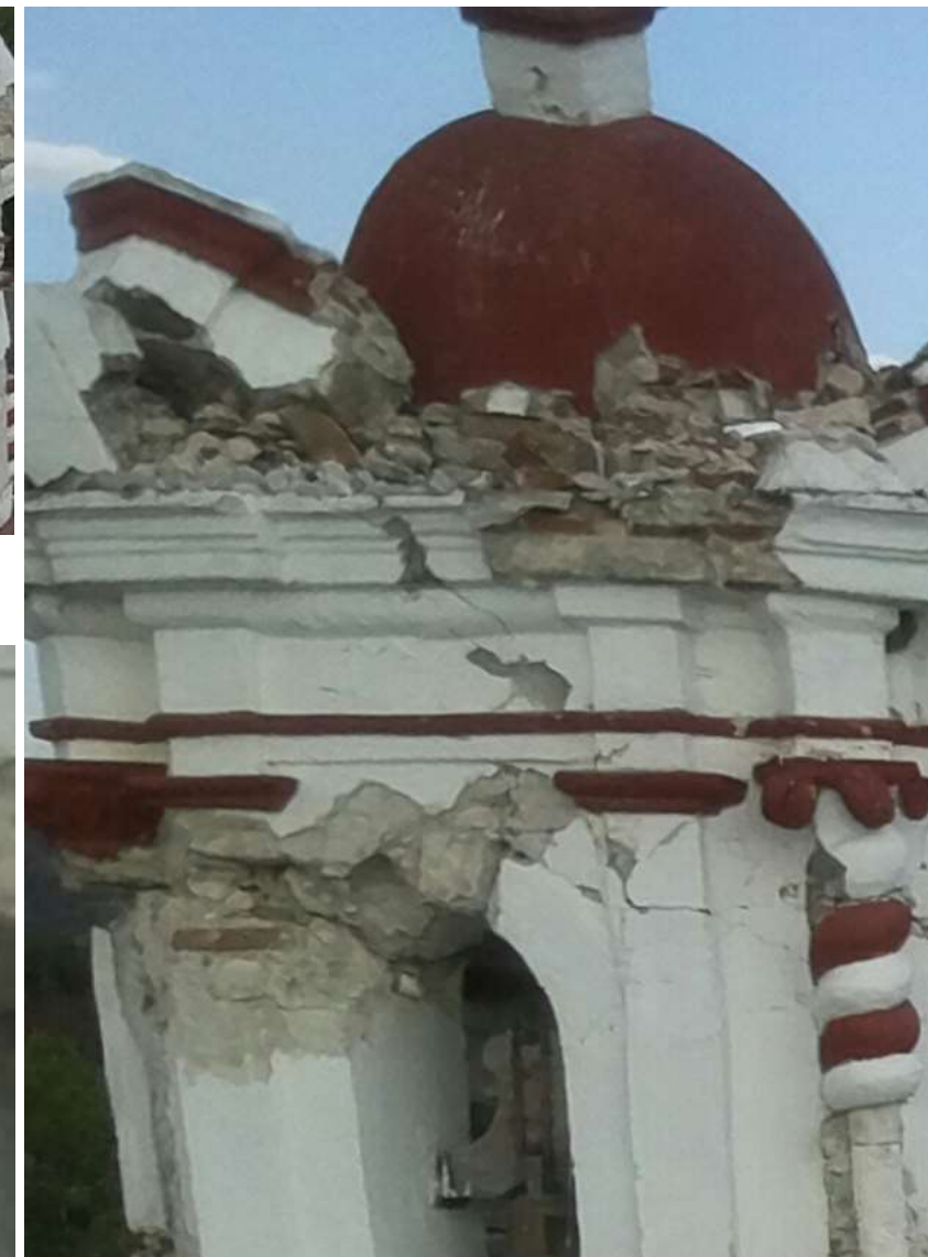
Imagen 3: Vista general del segundo cuerpo de torre fachada poniente
