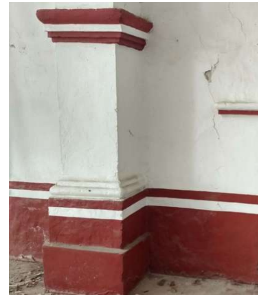
Imagen 2: Pilastra Sur de Sotocoro Vista Frontal
