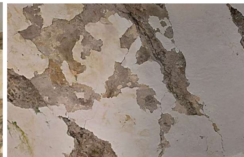
Imagen 2: Vista por intradós de bóveda de Coro
