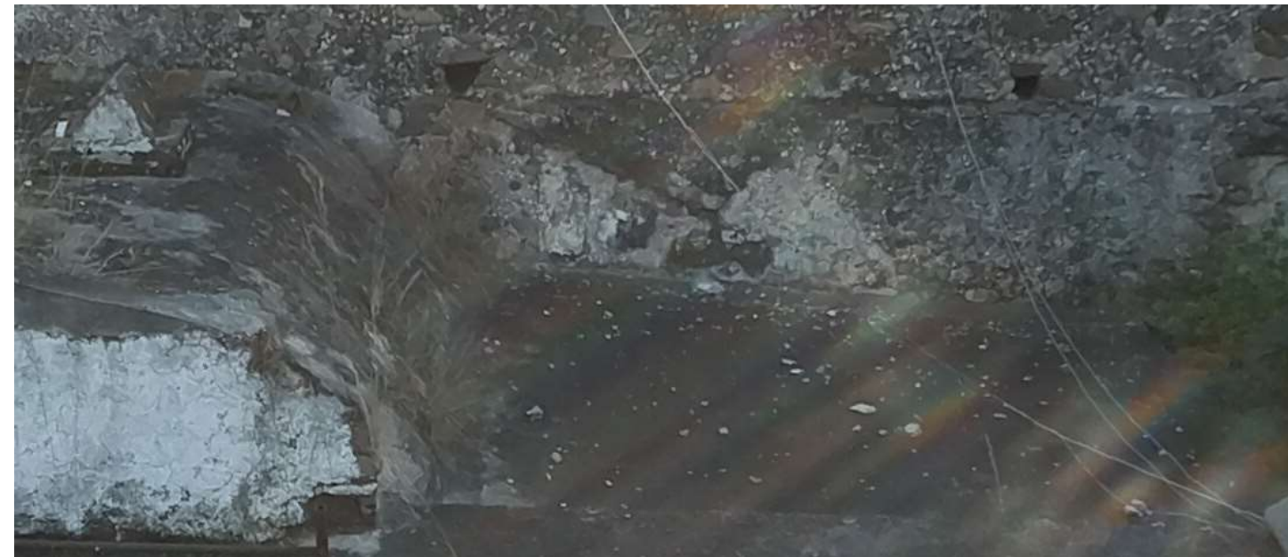
Imagen 1: Vista general de la azotea
