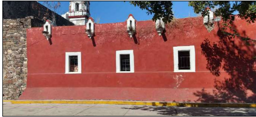
F02. Vista general de muro exterior oriente de Bodega 1 y Bodega 2
