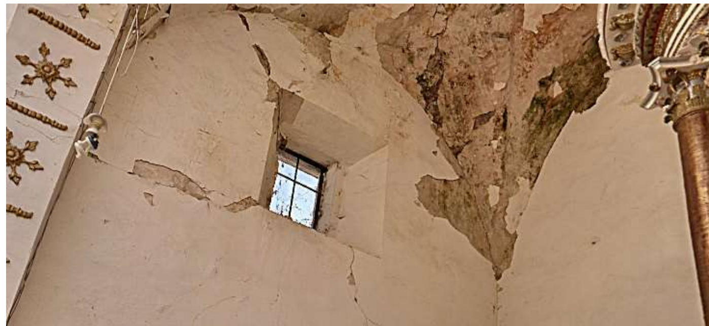
Imagen 1: Vista general del muro interior norte
