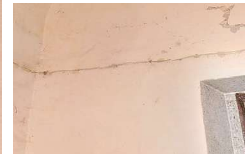
Imagen 3: Detalle del estado actual de muro interior norte
