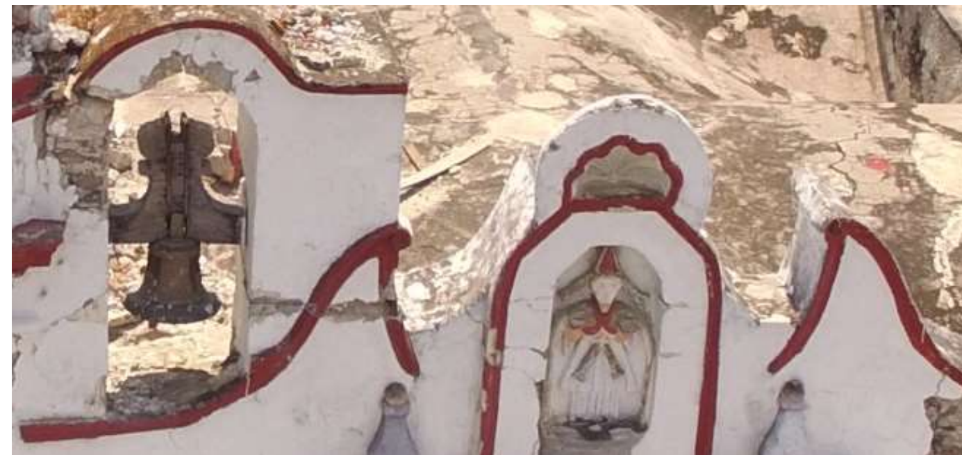
Imagen 1: Vista general del imafronte fachada poniente
