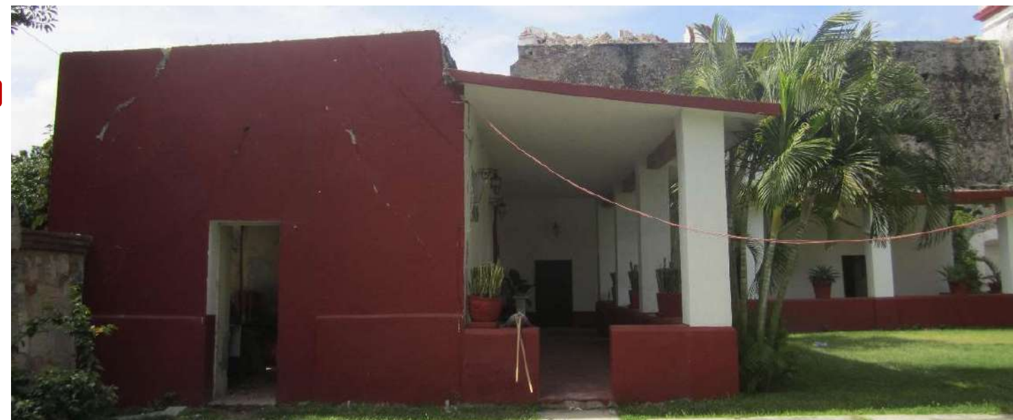
Imagen 1: Vista general de muro exterior norte
