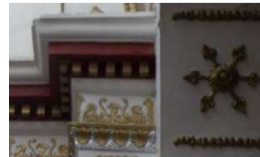
Imagen 3. Detalle de capitel de pilastra
