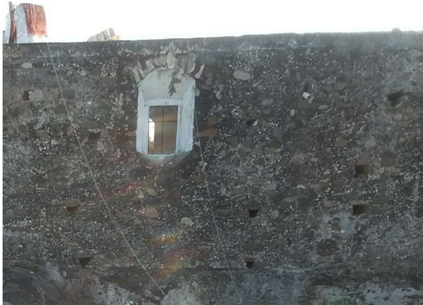
Imagen 1: Vista general de muro exterior norte
