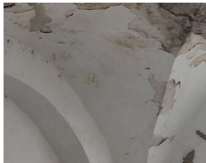
Imagen 2: Vista por el intradós parte nororiente de cubierta
