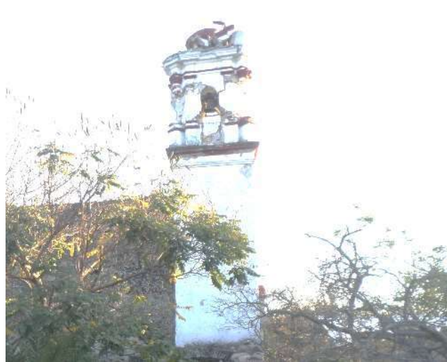
Imagen 1: Vista norte de la torre campanario
