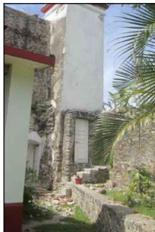
F02. Vista de primer cuerpo de Torre Campanario fachada oriente y norte
