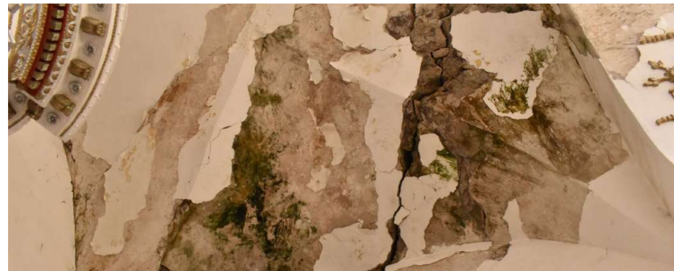
Imagen 2: Detalle del estado actual de intradós de cubierta
