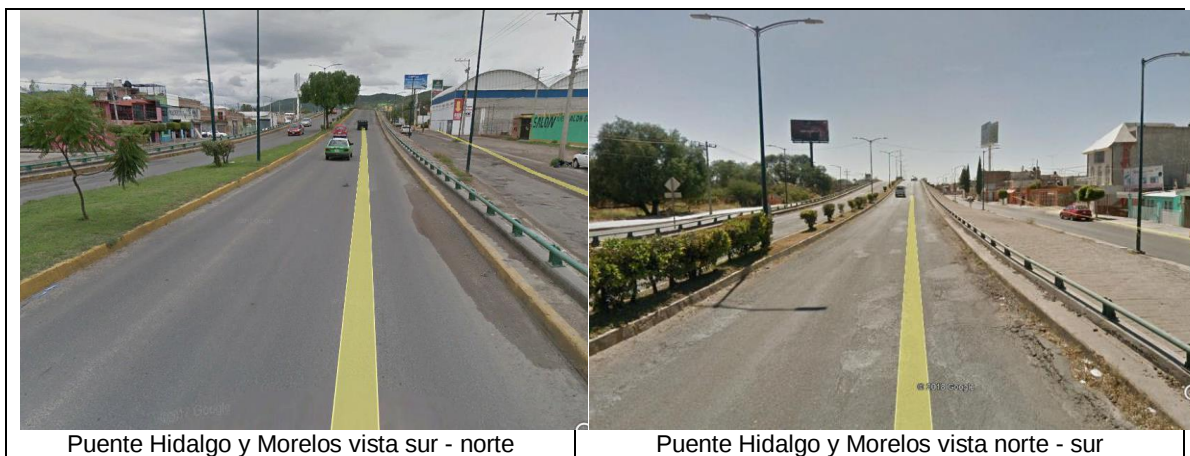
Figura 4.12 Superficie de rodamiento del puente del blvd. Hidalgo y blvd. José Ma. Morelos
