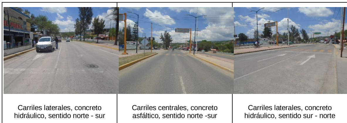
Figura 4.11 Superficie de rodamiento en el tramo de Relámpago a blvd. Dibujantes
