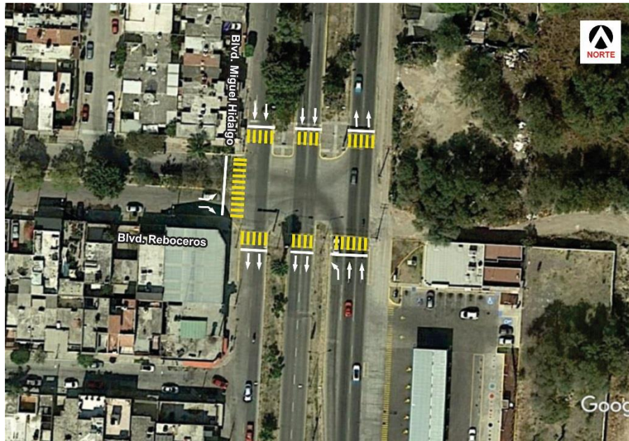
Figura 4.19 Blvd. Miguel Hidalgo y blvr. Reboceros
