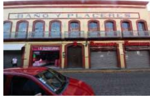
Baños Av. Ind. 107 alteraciones en planta baja para uso comercial. Fotografía: Francisco Ruiz Herrera.
