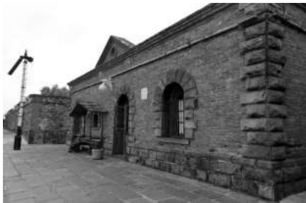
Estación Ferroviaria Atlixco Puebla. Fuente: Francisco Ruiz Herrera.
