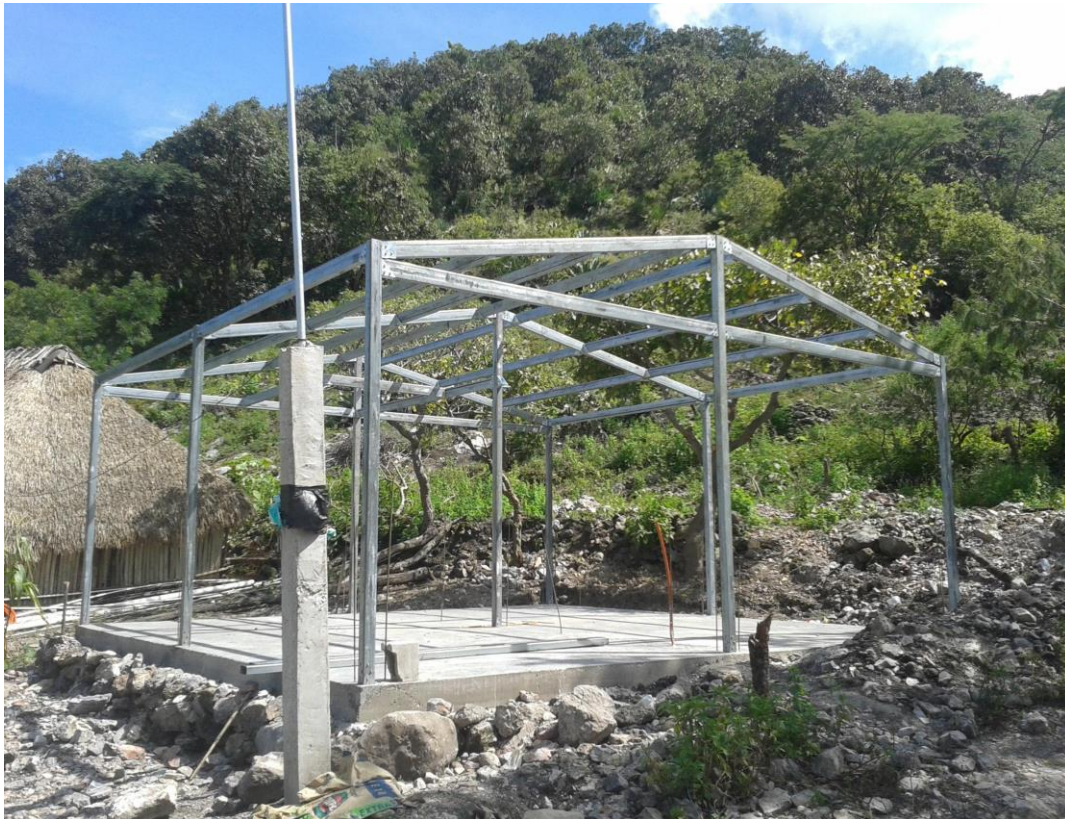
Figura 4.15 Estructura sobre losa de cimentación. (Mejor con Acero, 2014)
