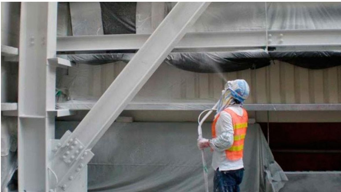
Figura 3.13 Tratamiento ignífugo de naves industriales. Fuente: (TRC paint, 2017).
