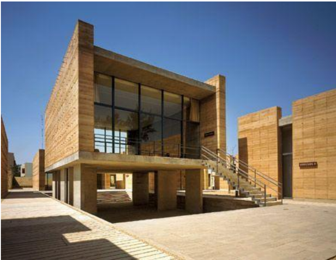
Figura 2.1 Edificación de tapias. Fuente: (Estévez ,2012).
