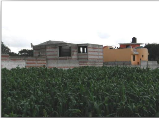
Foto 11: Tramo 10 km 17+300, spor
