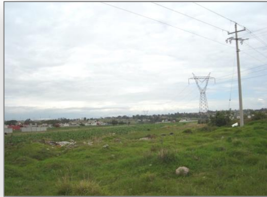
Foto 8: Tramo 5 km 9+600, spor
