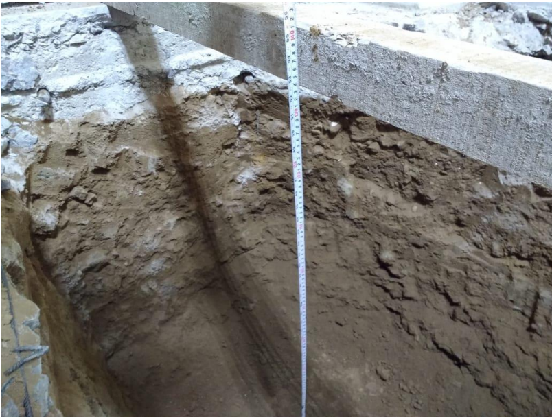
Ilustración 50. Excavación a -1.35 m a partir de N.P.T.
