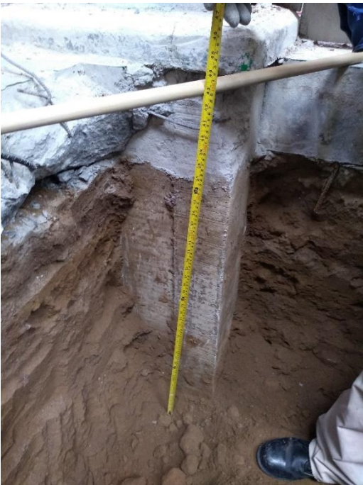
Fotografía 2. Excavación 1.10 m a partir de N.P.T. (Nivel de losa)
