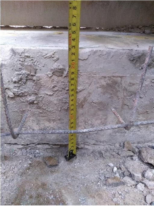
Fotografía 1. Demolición de losa de concreto armado (23 cm)
