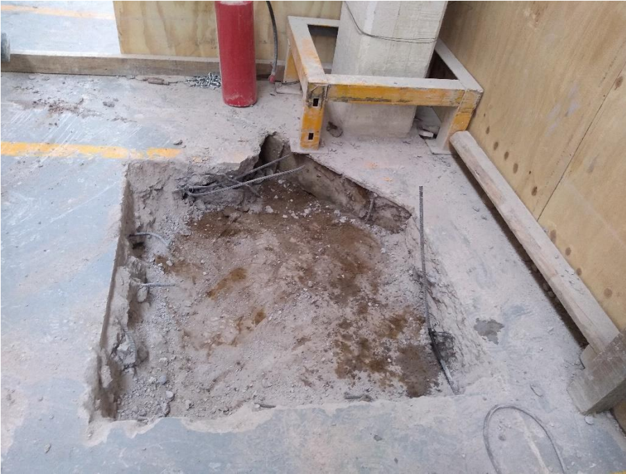
Ilustración 47. Excavación 0.20 m a partir de N.P.T. (Nivel de losa)
