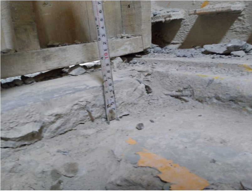
Ilustración 49. 1er Losa de firme de concreto a -0.06 m a partir de N.P.T.
