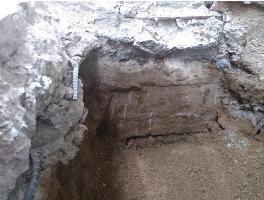
Ilustración 48. Excavación 0.50 m a partir de N.P.T. (Nivel de losa)
